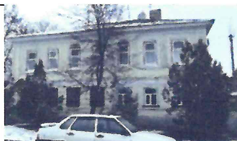
Композиция юго-восточного фасада
