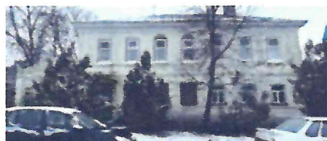
Симметричная композиция фасада на семь световых осей; центральный ризалит на три оконных проема
