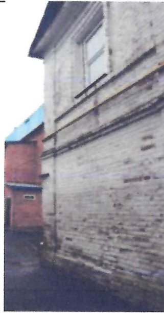
прямоугольный профильный наличник оконного проема, надоконная тяга, венчающий карниз простого профиля
