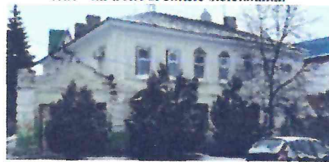
Композиция юго-восточного фасада
