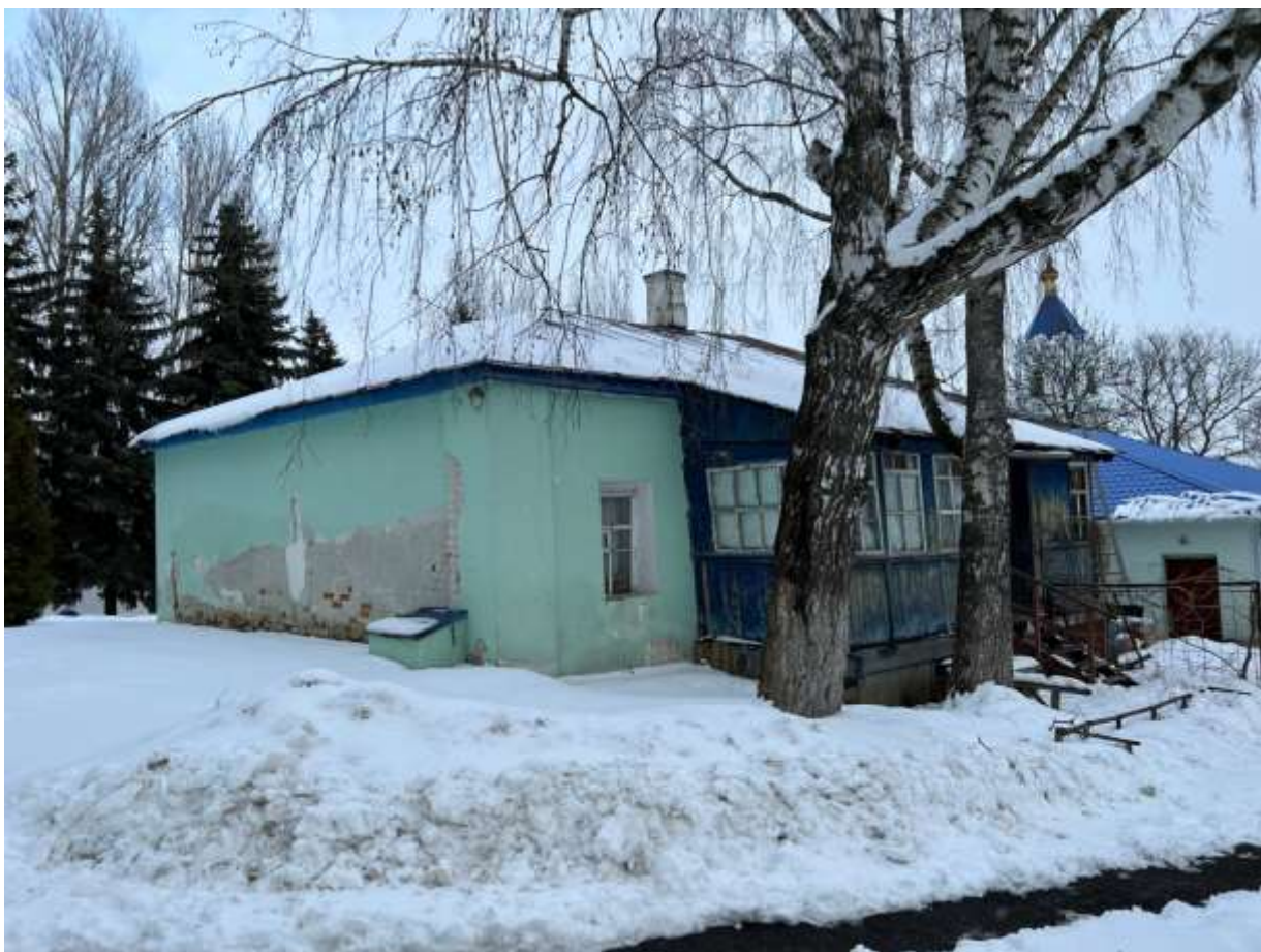
Т.ф. 5. Общий вид южного фасада Объекта
