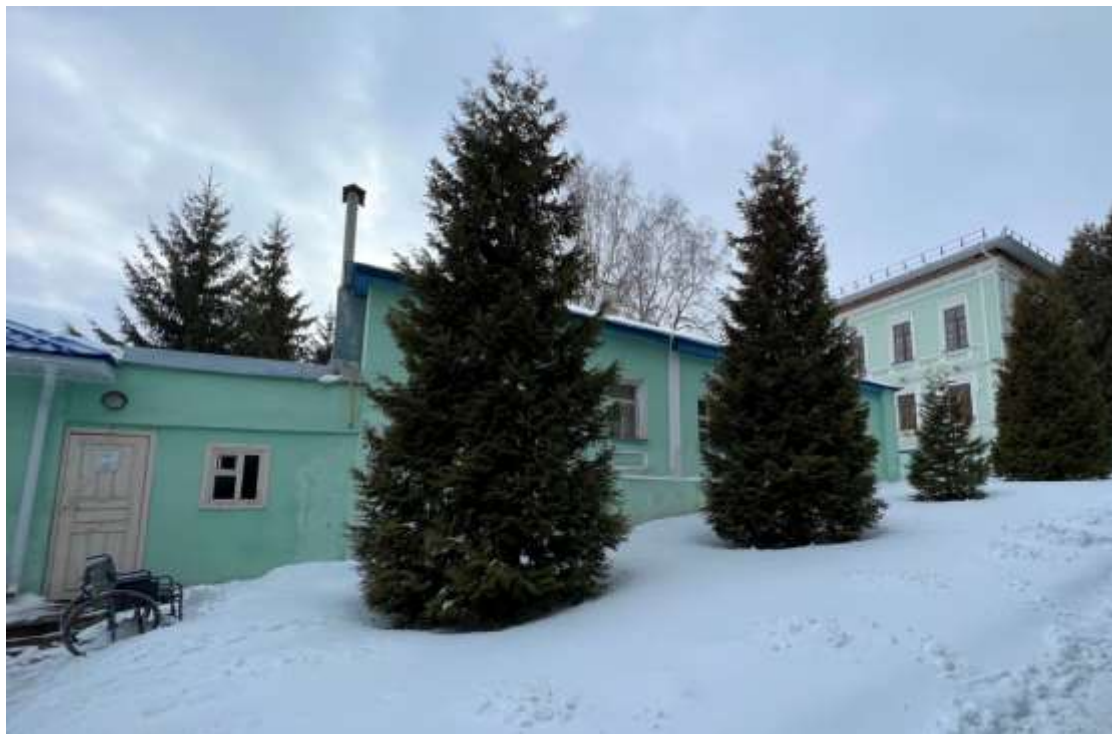
Т.ф. 1. Общий вид Объекта с северной стороны
