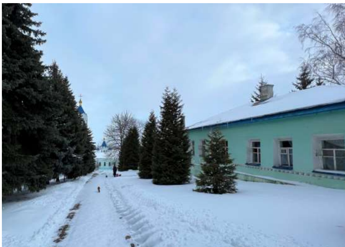
Т.ф. 2. Общий вид Объекта с северной стороны
