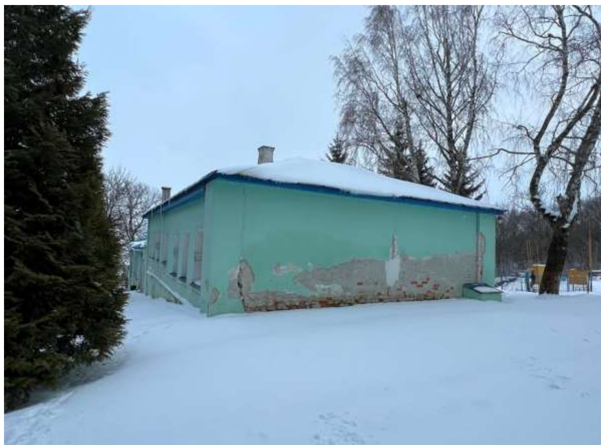
Т.ф. 4. Общий вид западного фасада Объекта
