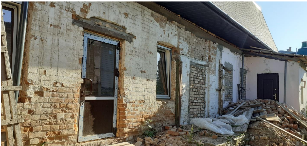
Фотография № 5. Дворовый (северный) фасад Объекта.
