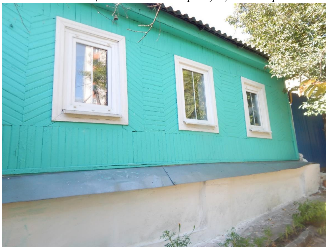
Фото 2. Оформление стен Объекта.
