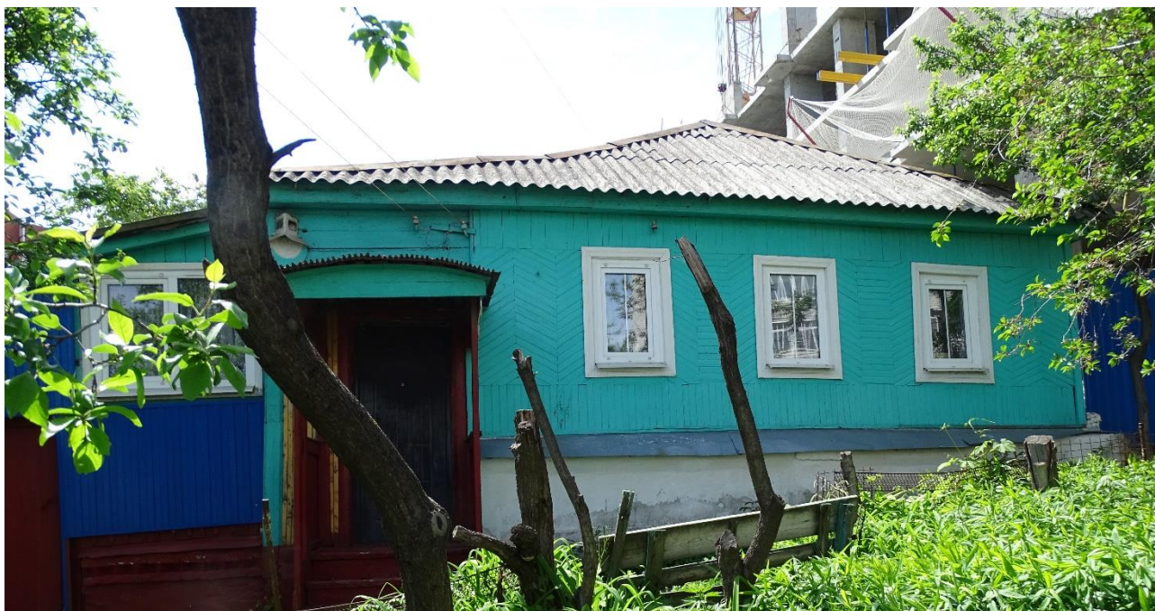
Фото 3. Слева от крыльца – пристрой к Объекту. Общий вид
