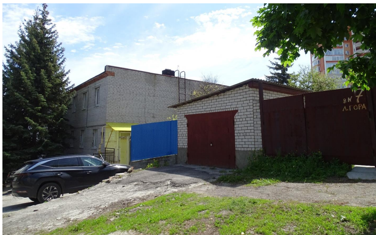
Фото 12. Общий вид строения по адресу: ул. Лысая Гора, 9
