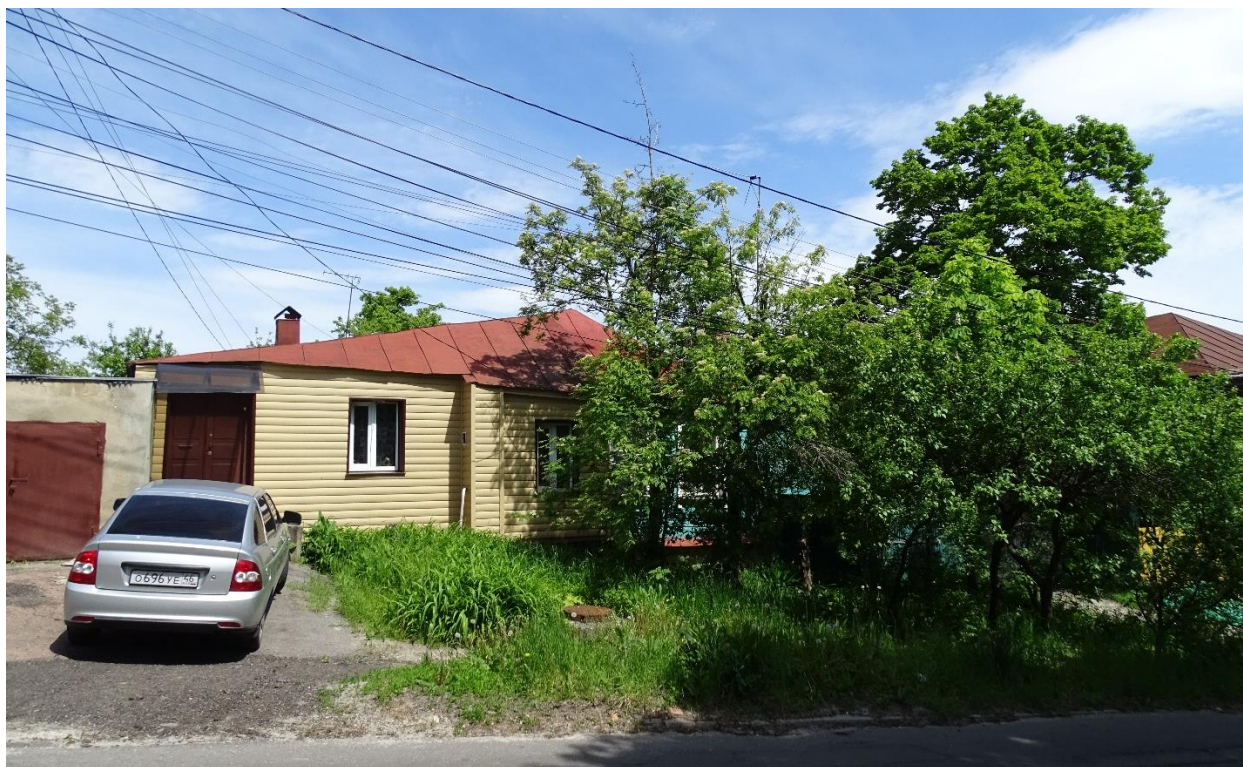
Фото 11. Общий вид жилого дома №4
