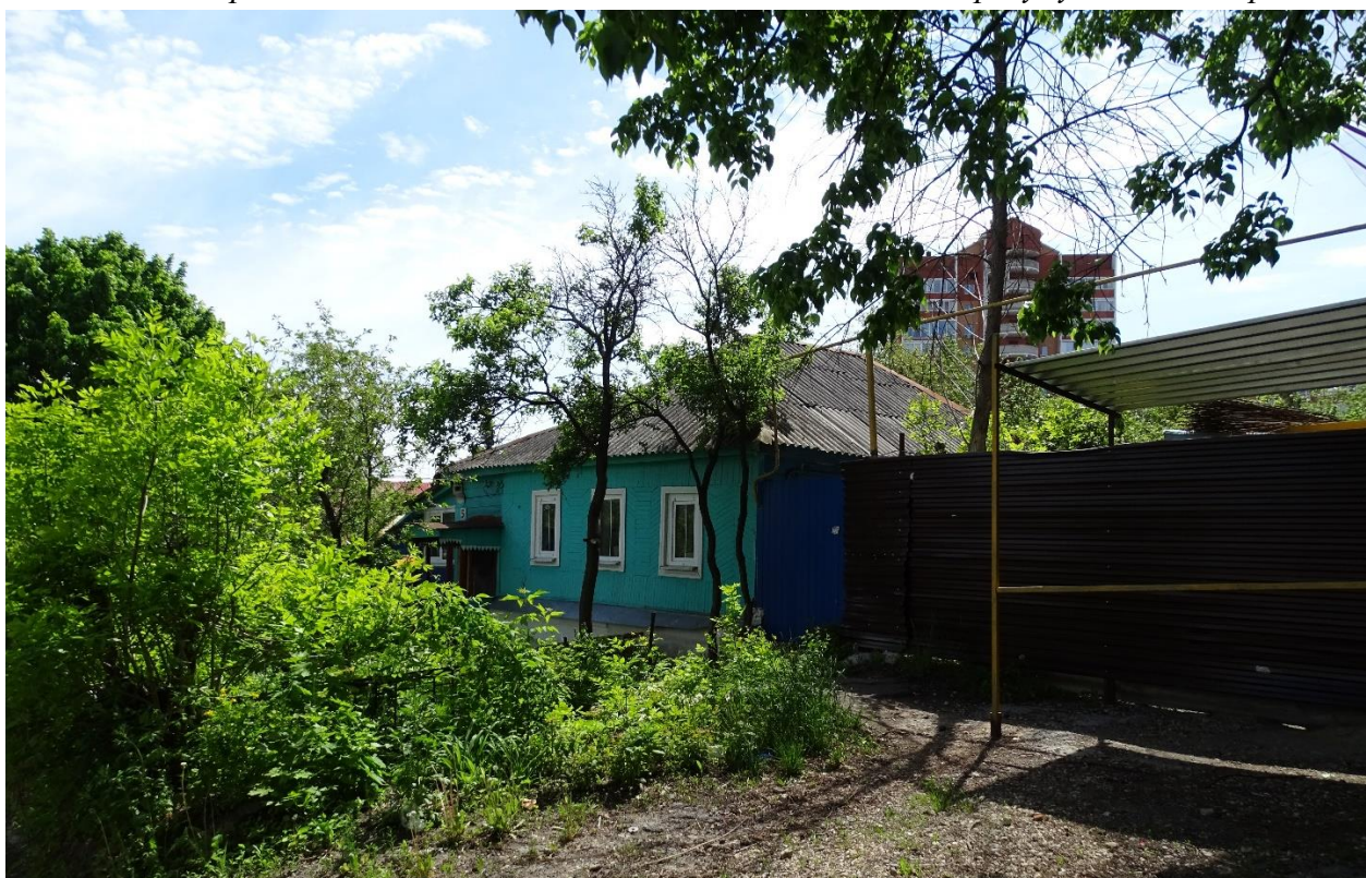
Фото 8. Забор и навес строительной площадки по адресу: ул. Лысая Гора, 3, около Объекта.
