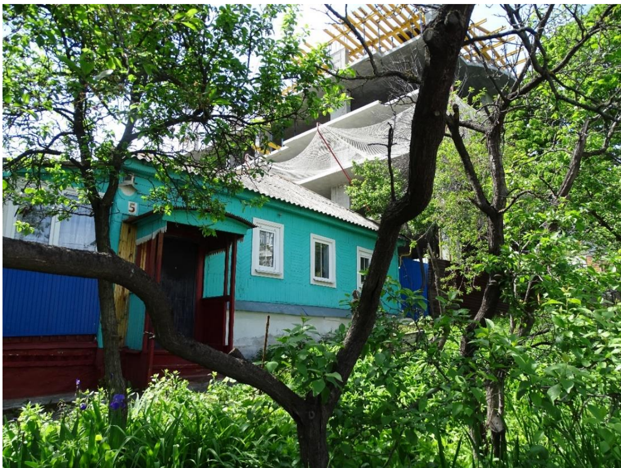
Фото 7. Строительство многоэтажного жилого дома по адресу: ул. Лысая Гора, 3.
