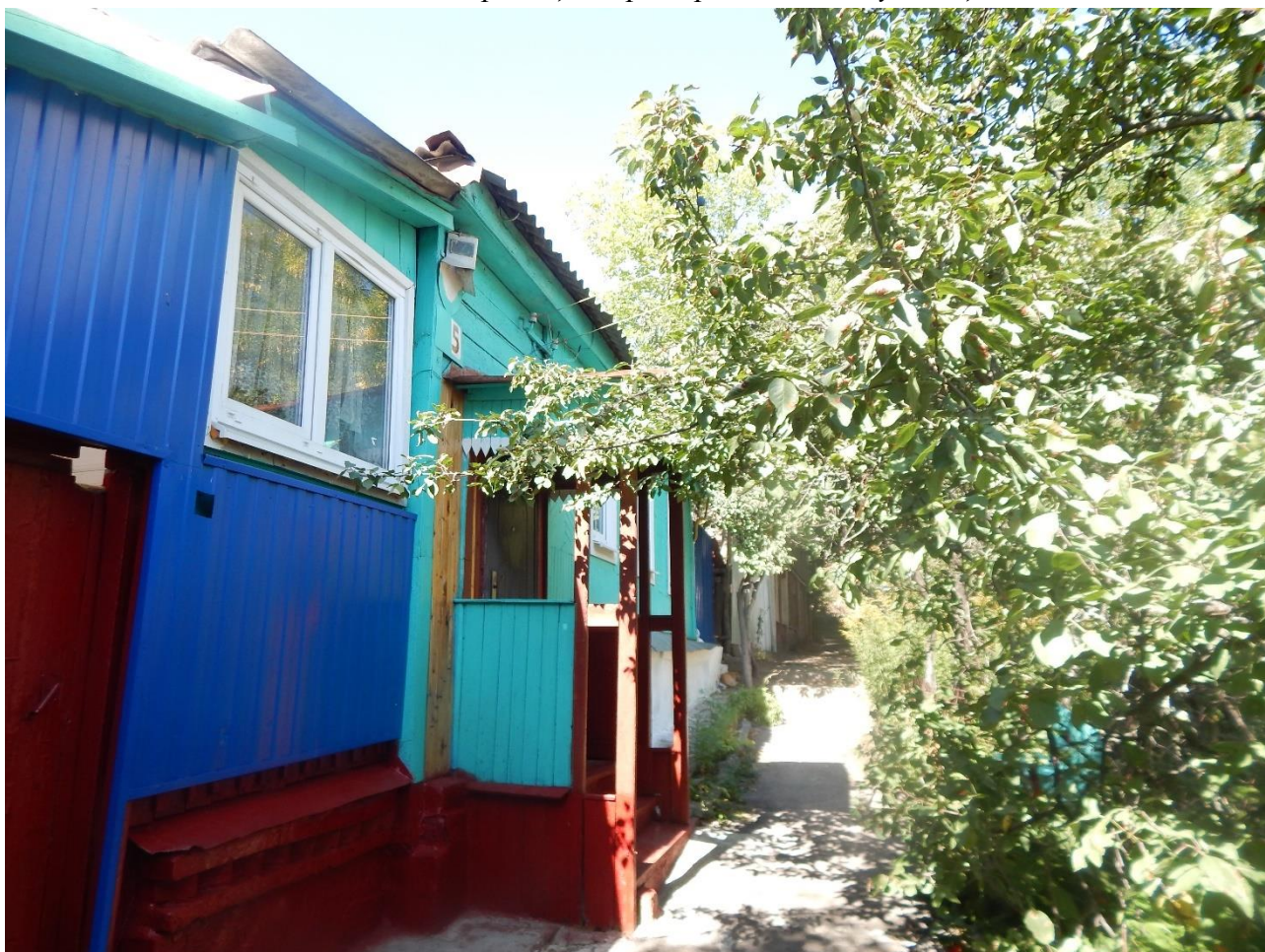
Фото 4. Слева от крыльца – пристрой к Объекту. Общий вид
