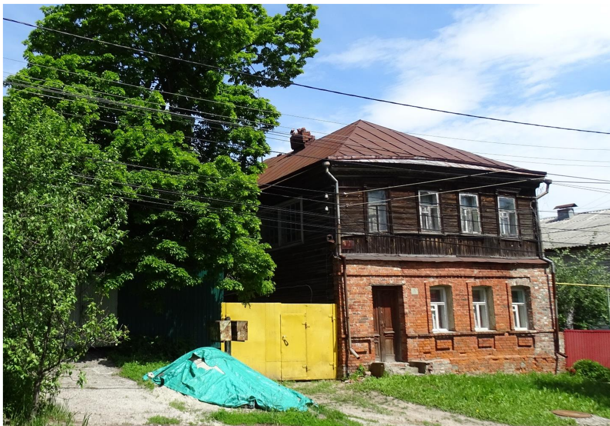
Фото 9. Общий вид жилого дома №6
