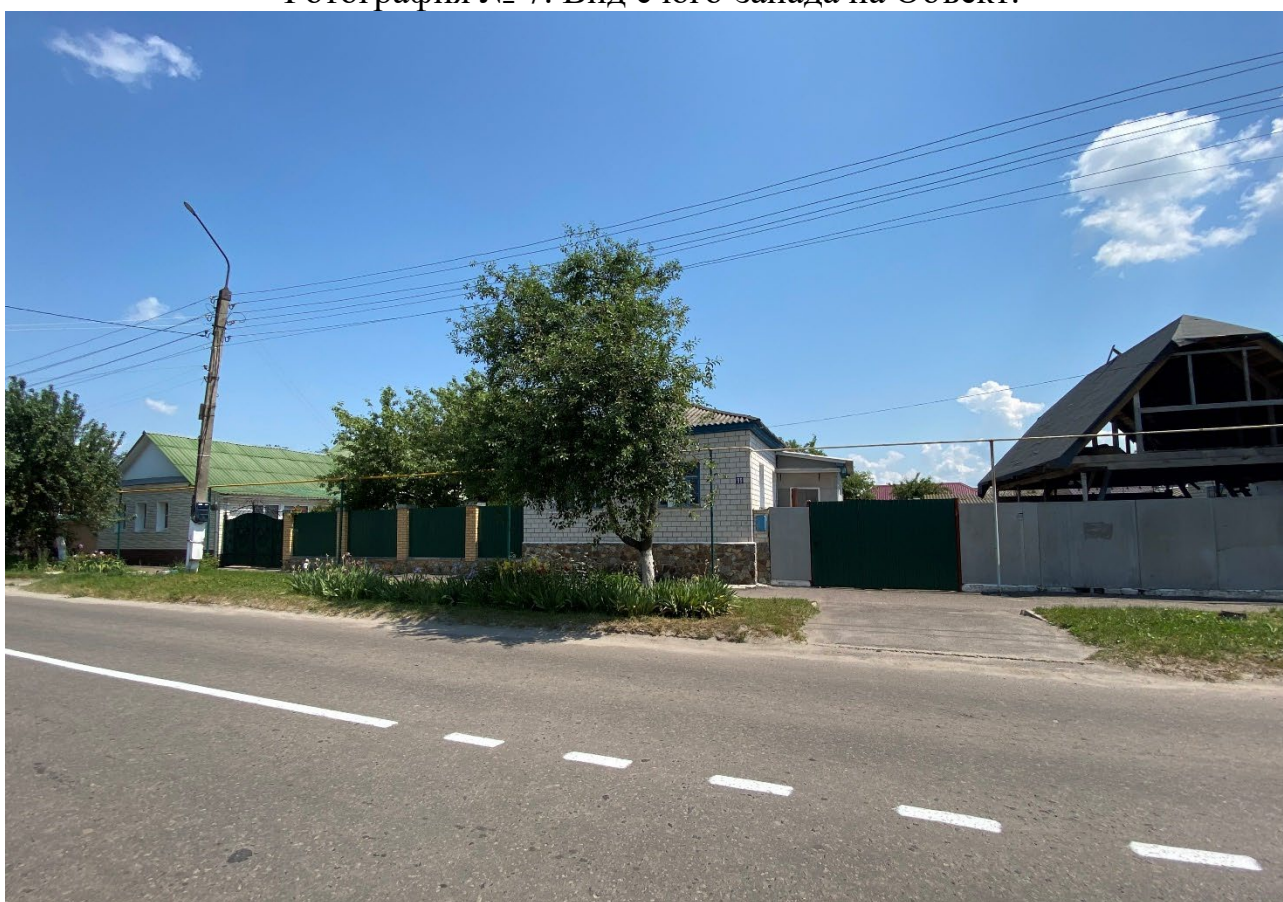
Фотография № 8. Вид с запада на Объект.
