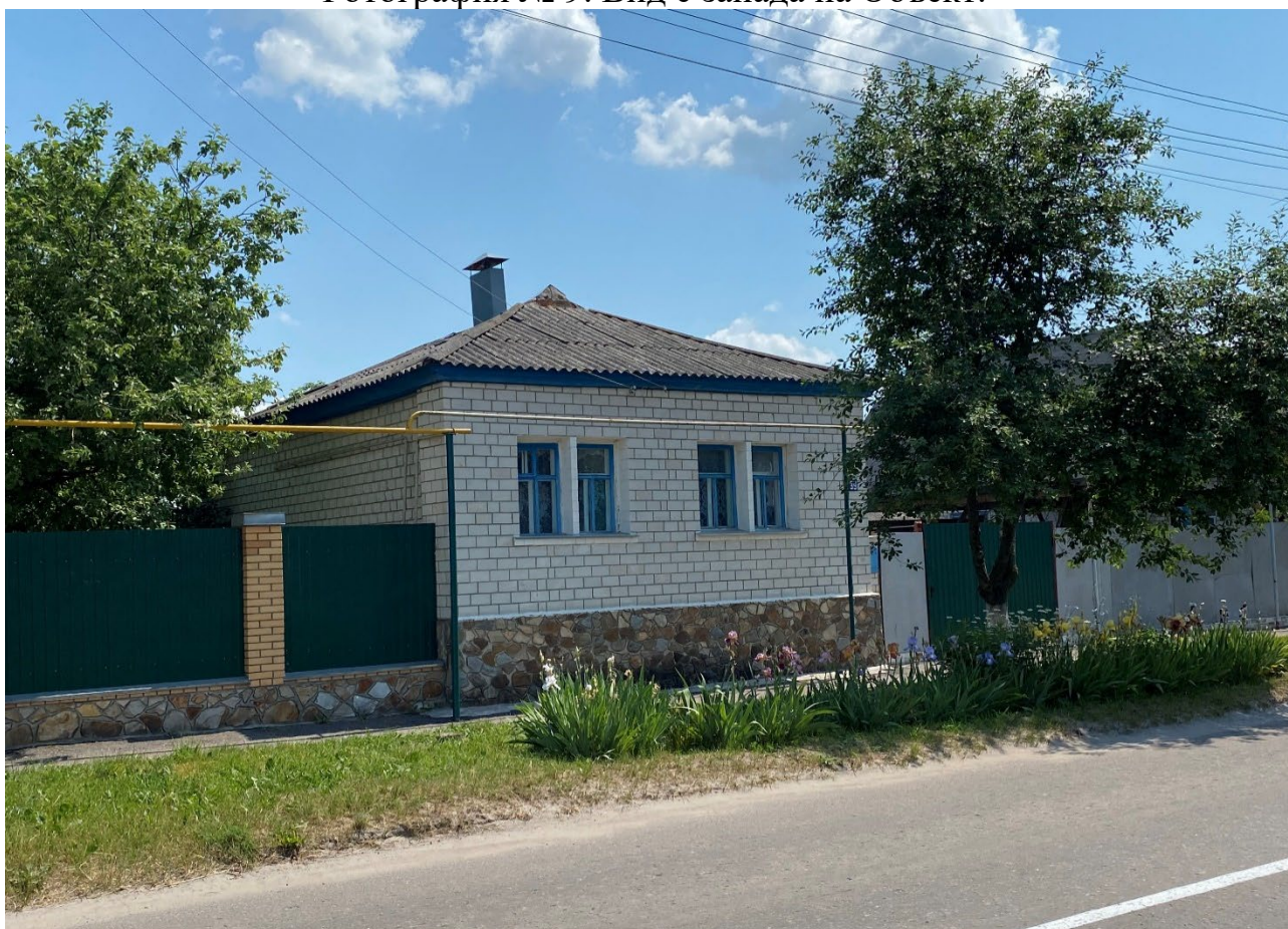
Фотография № 10. Вид с северо-запада на Объект.
