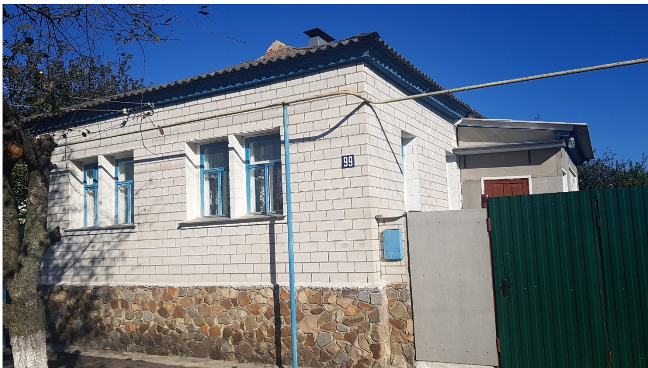
Фотография № 1. Вид с юго-запада на Объект. Общий вид здания
