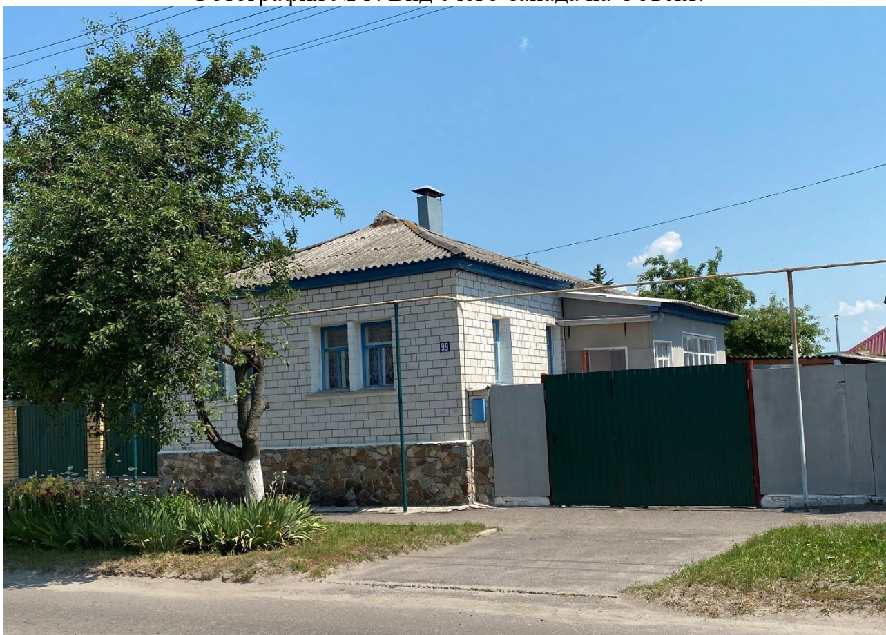
Фотография № 6. Общий вид Объекта.
