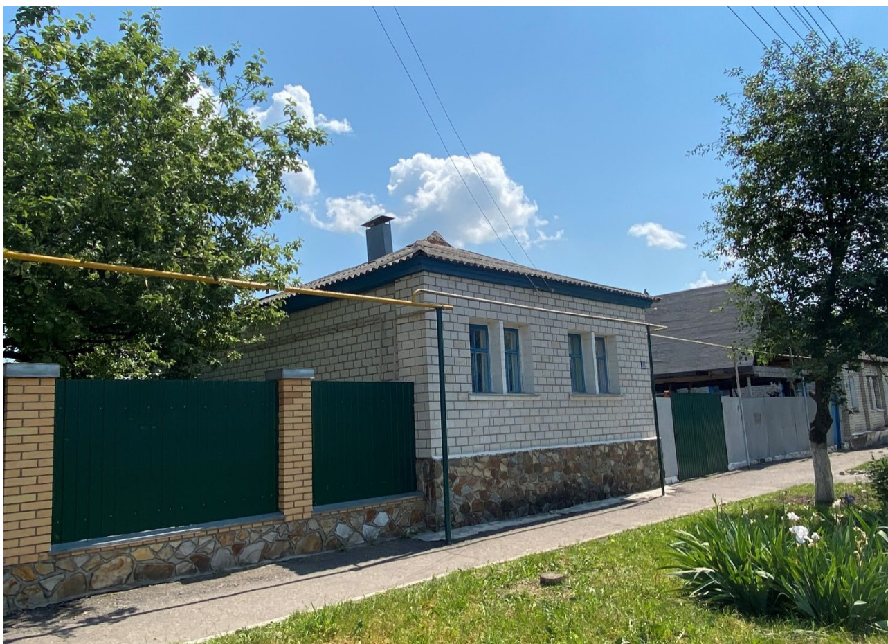
Фотография № 11. Вид с северо-запада на Объект.
