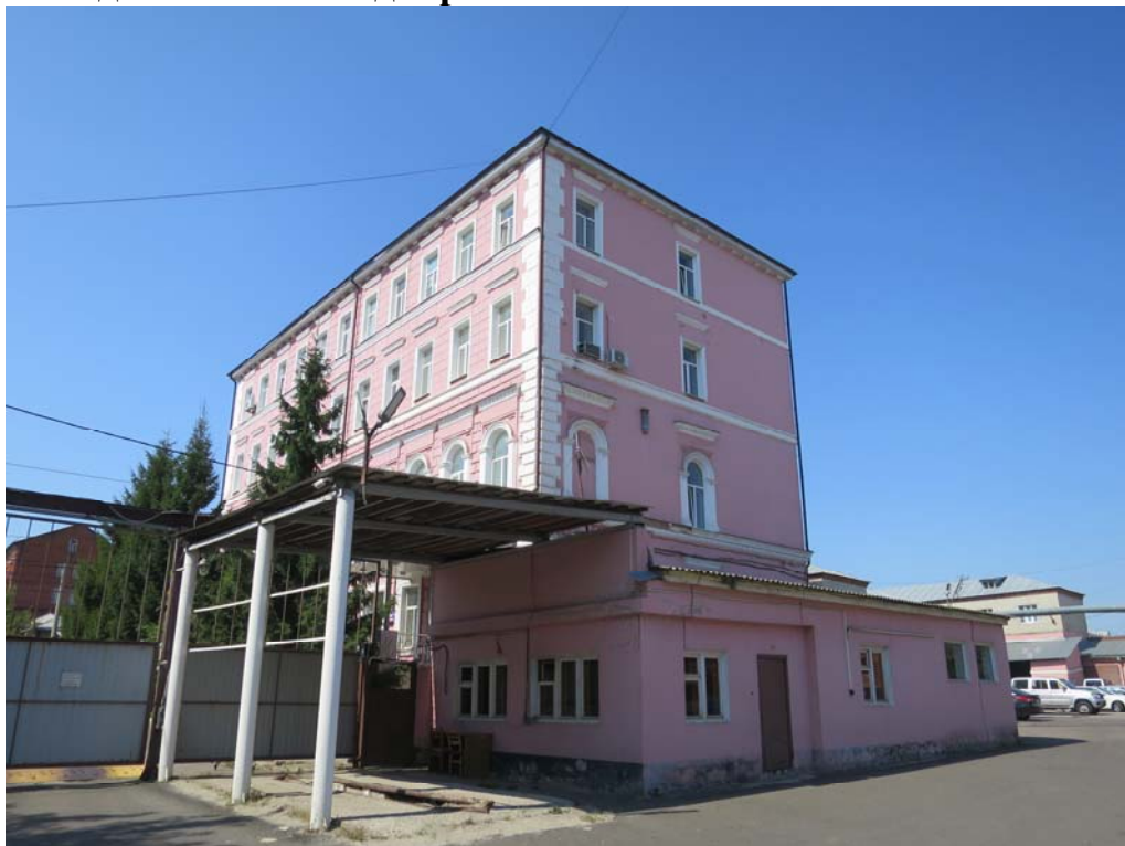
8. Вид с востока со двора.
