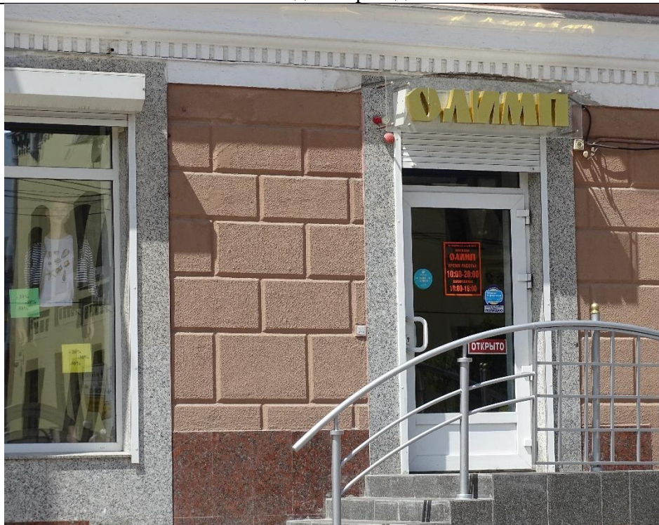
Характер штукатурки в уровне 1-го этажа
