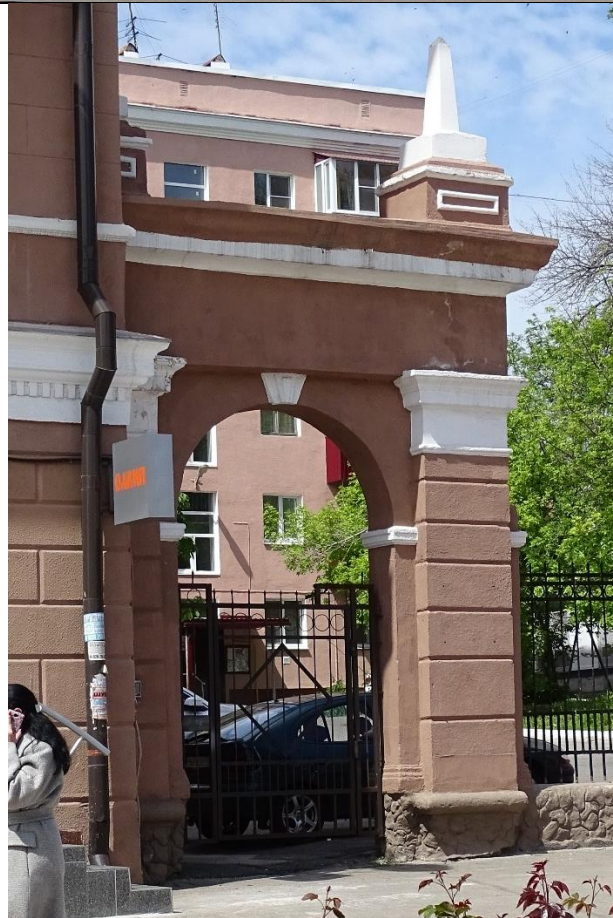
Уличный фасад южного портала
