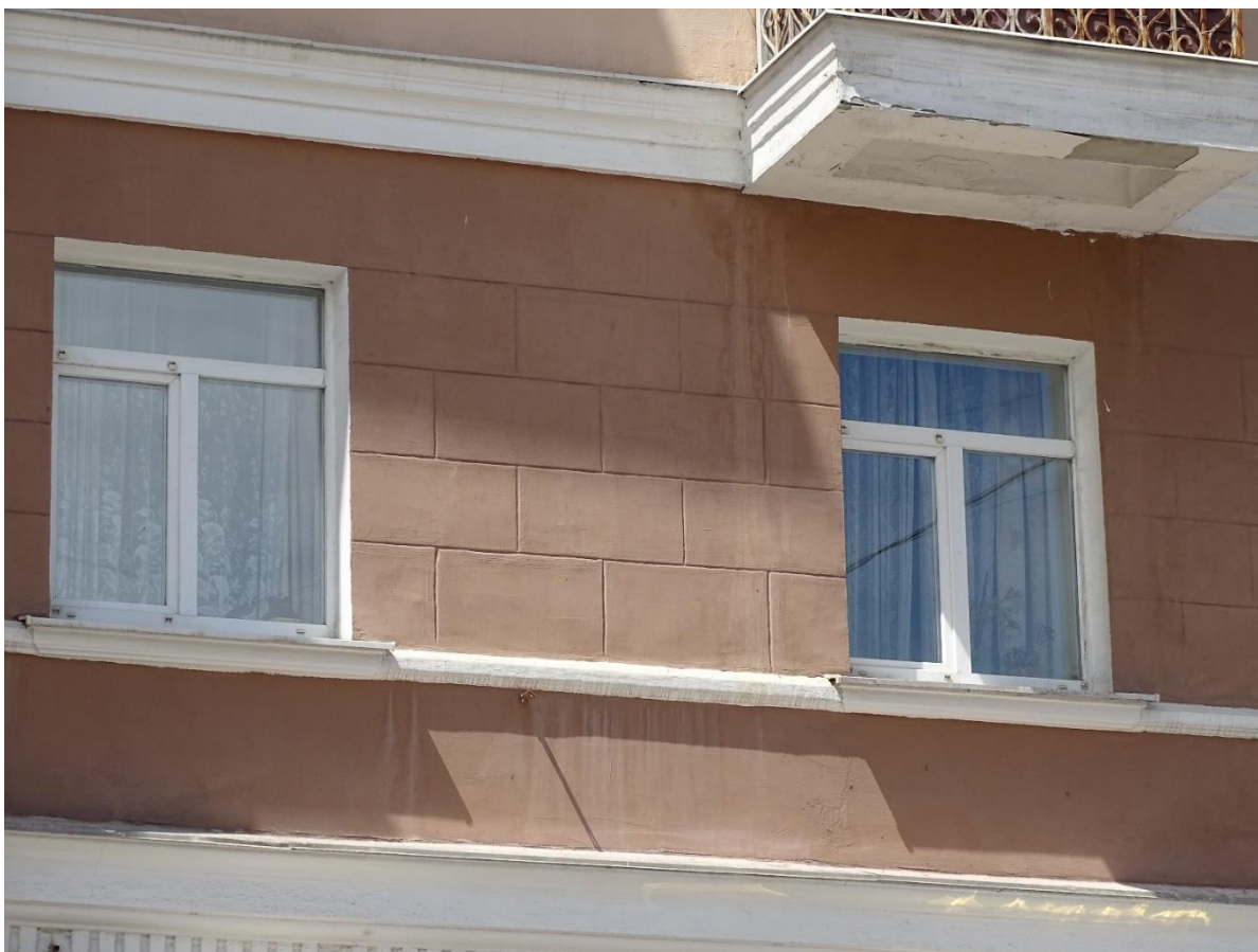
Фото 13. Окна второго этажа
