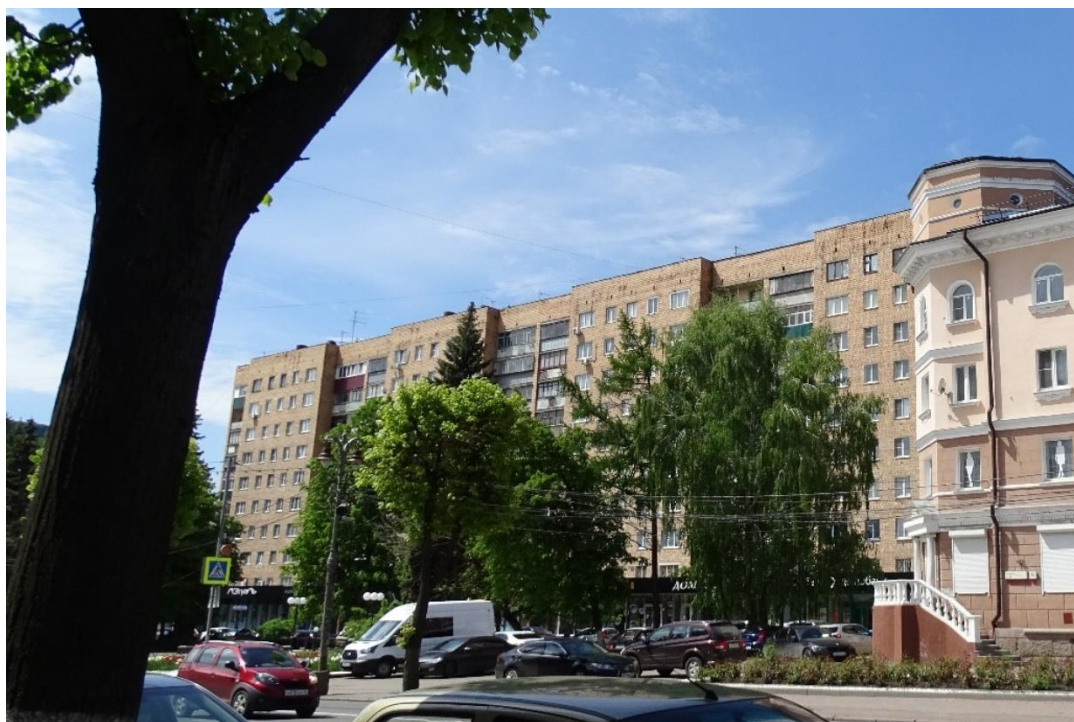
Жилой дом № 71 по ул. Ленина.
