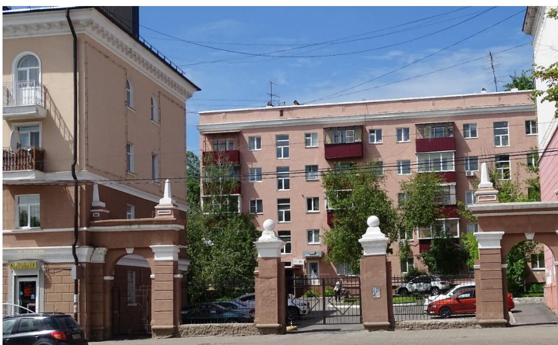
Жилой дом №84 по ул. Ленина
