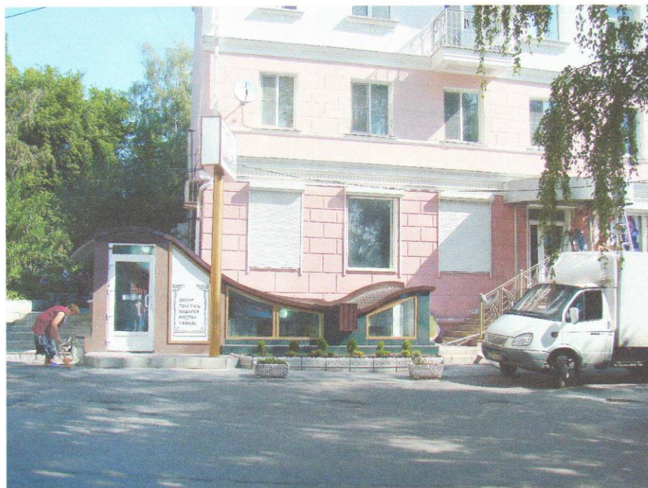
Фото 1. г. Курск, ул. Ленина, 86. Фотофиксация август 2012г
