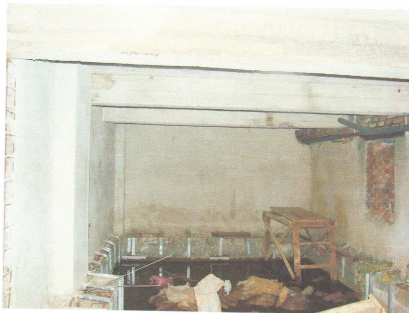
«Дом жилой», г. Курск, ул. Ленина, 86 (подвал, нежилое помещение VII). Интерьер помещений
