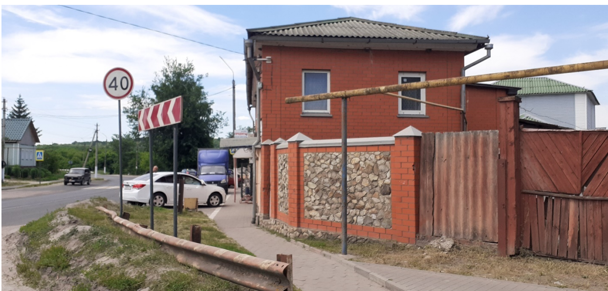
Фотография №4. Вид с юго-востока на Объект.
