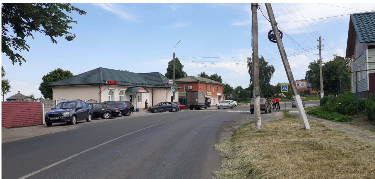
Фотография № 10. Вид с северо-запада на Объект.
