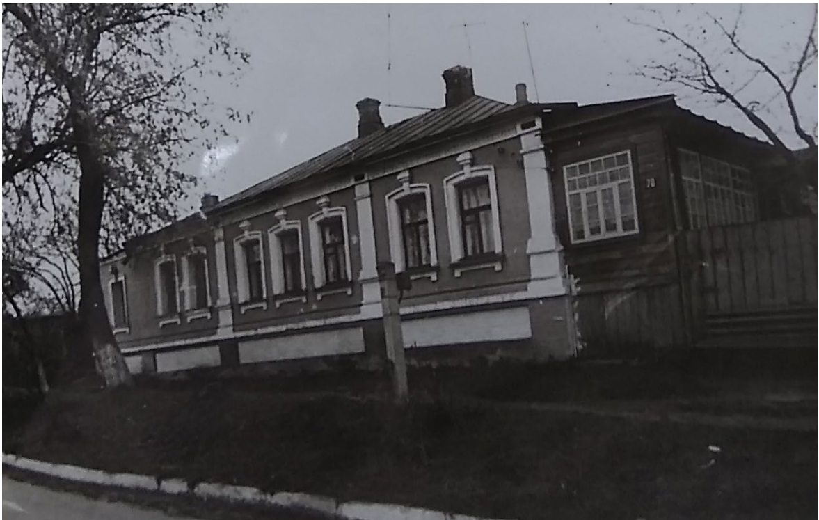
Дом по ул. Урицкого, 70.
