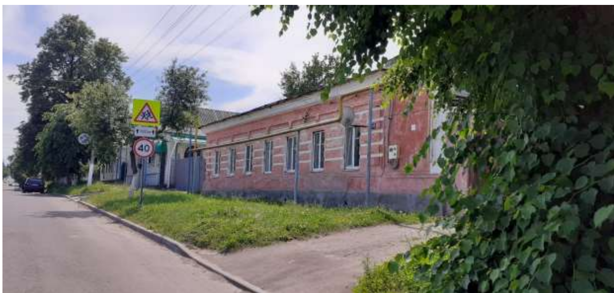
Фотография № 8. Вид с северо-востока на Объект.
