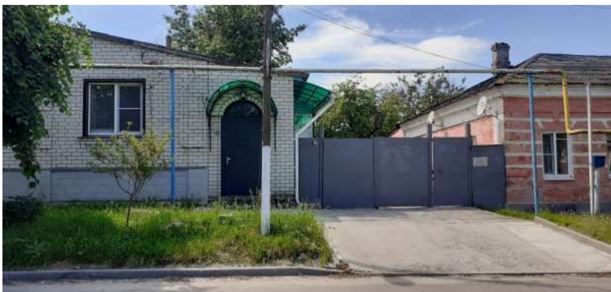
Фотография № 4. Вид с юго-востока на Объект.
