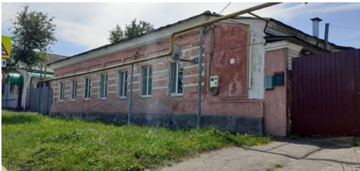
Фотография № 7. Вид с северо-востока на Объект.
