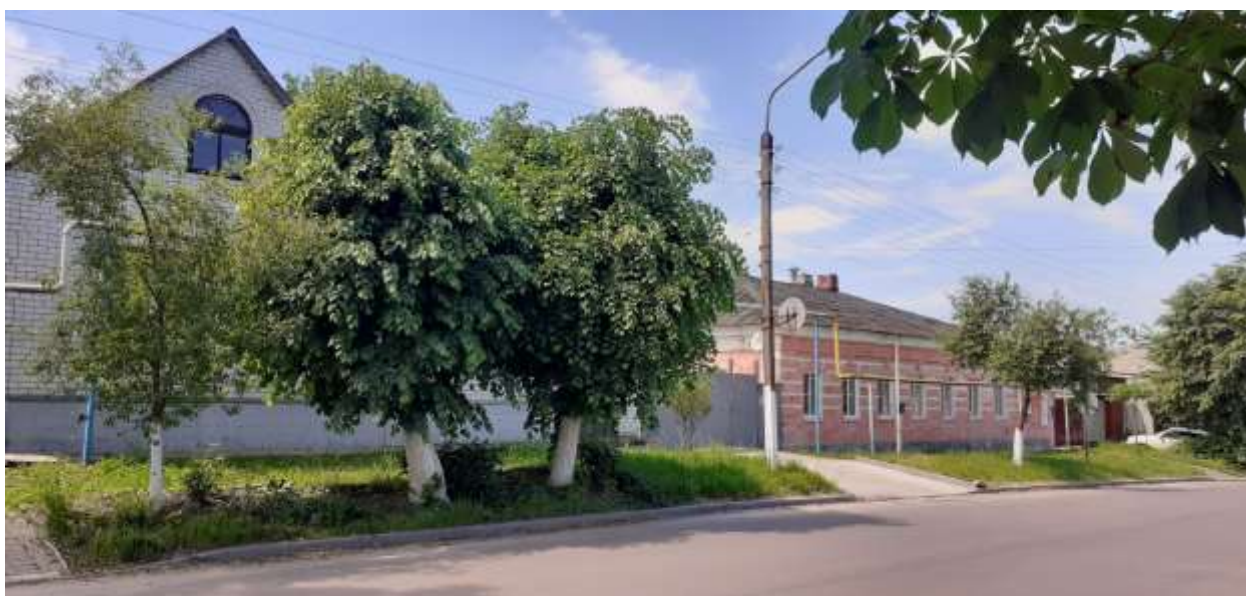
Фотография № 2. Вид с юго-востока на Объект.
