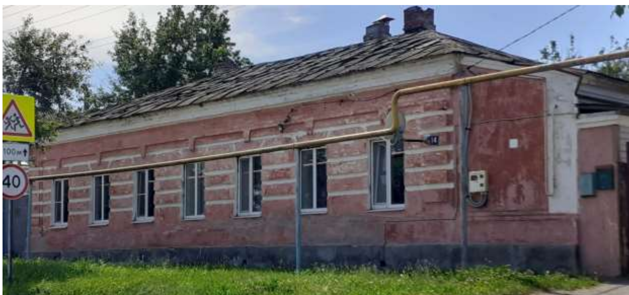
Фотография № 6. Вид с северо-востока на Объект.
