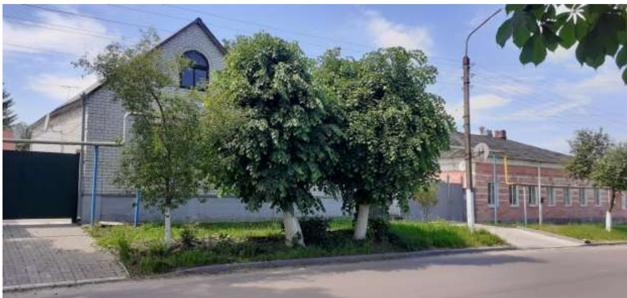
Фотография № 1. Вид с юго-востока на Объект.
