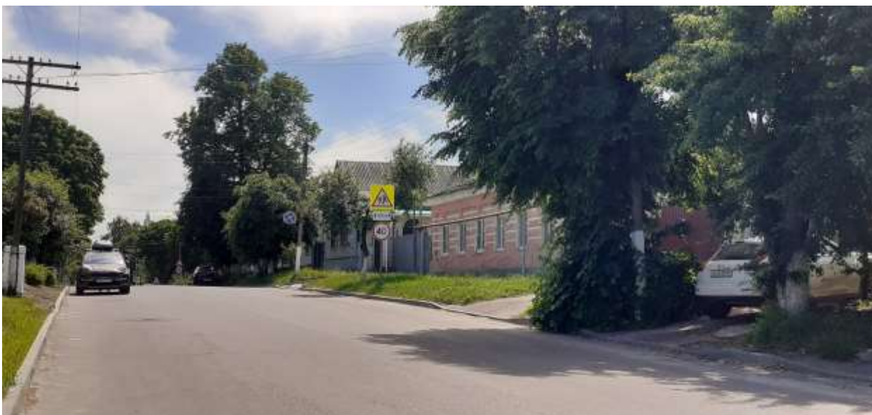
Фотография № 9. Вид с северо-востока на Объект.
