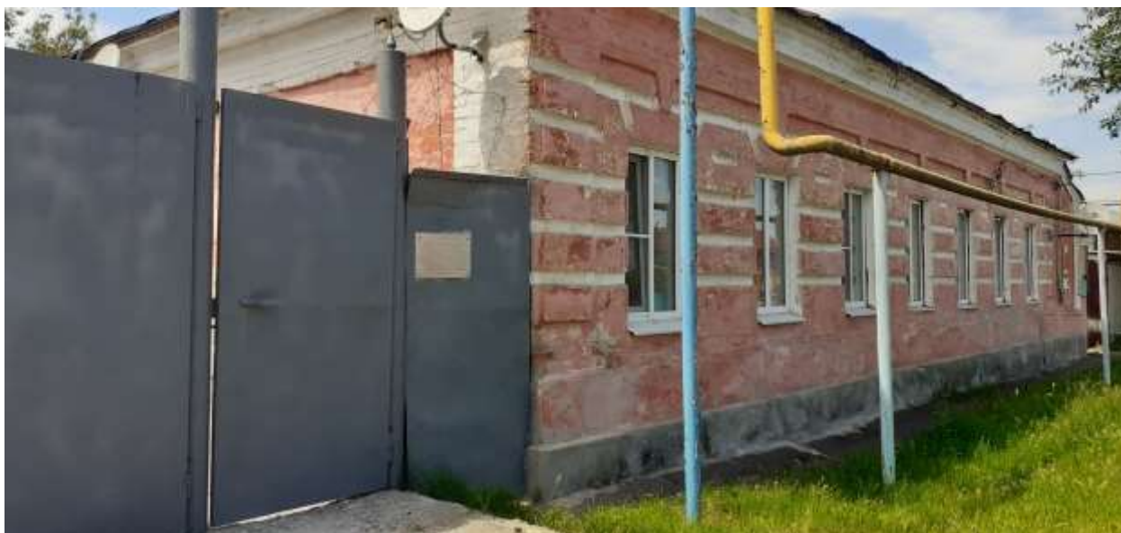
Фотография № 5. Вид с юго-востока на Объект.
