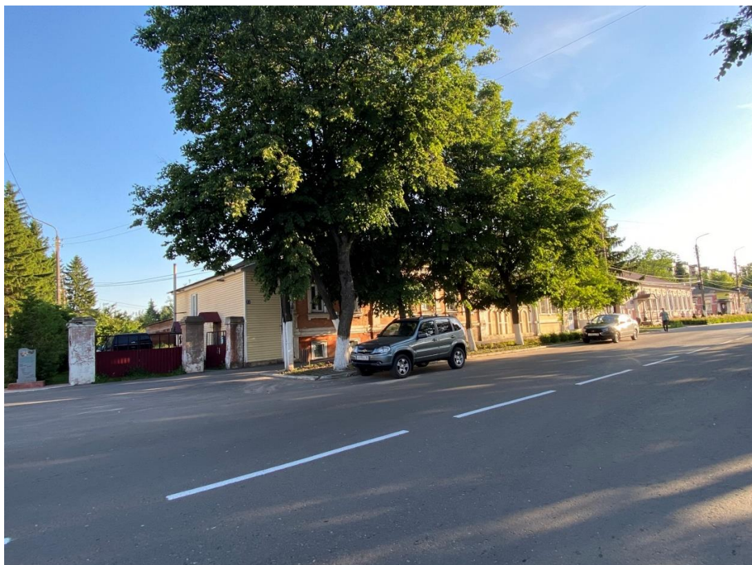
Фотография № 11. Вид с северо-востока на Объект.
