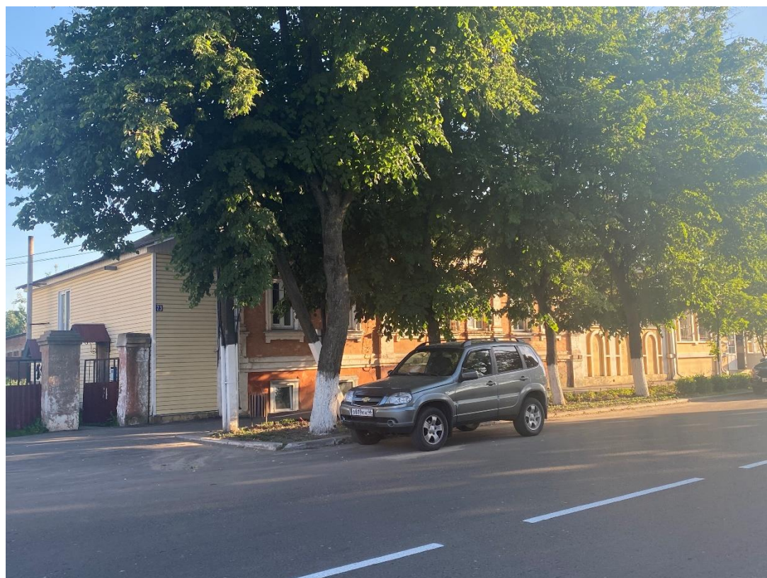
Фотография № 10. Вид с северо-востока на Объект.
