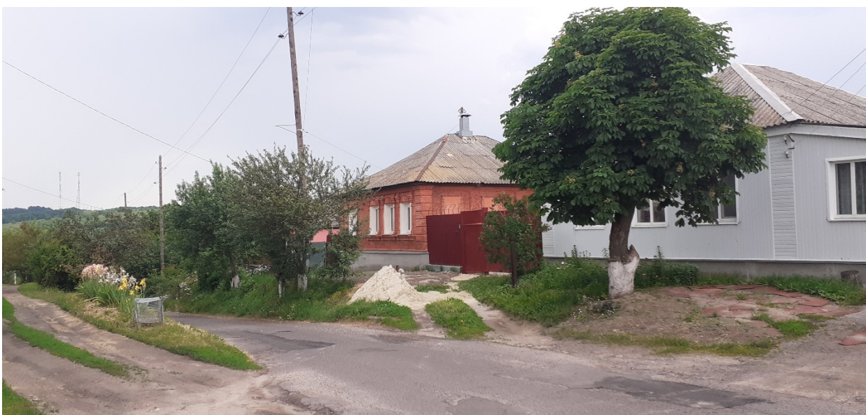
Фотография № 2. Вид с юго-запада на Объект.
