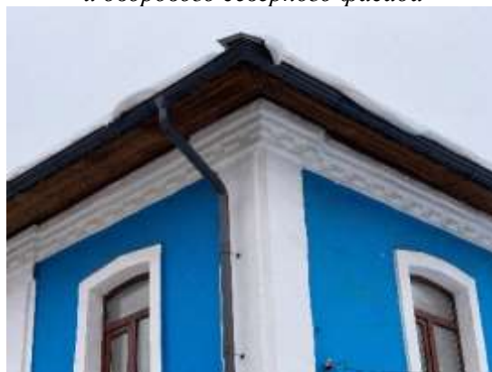
Венчающий карниз и угловая лопатка
