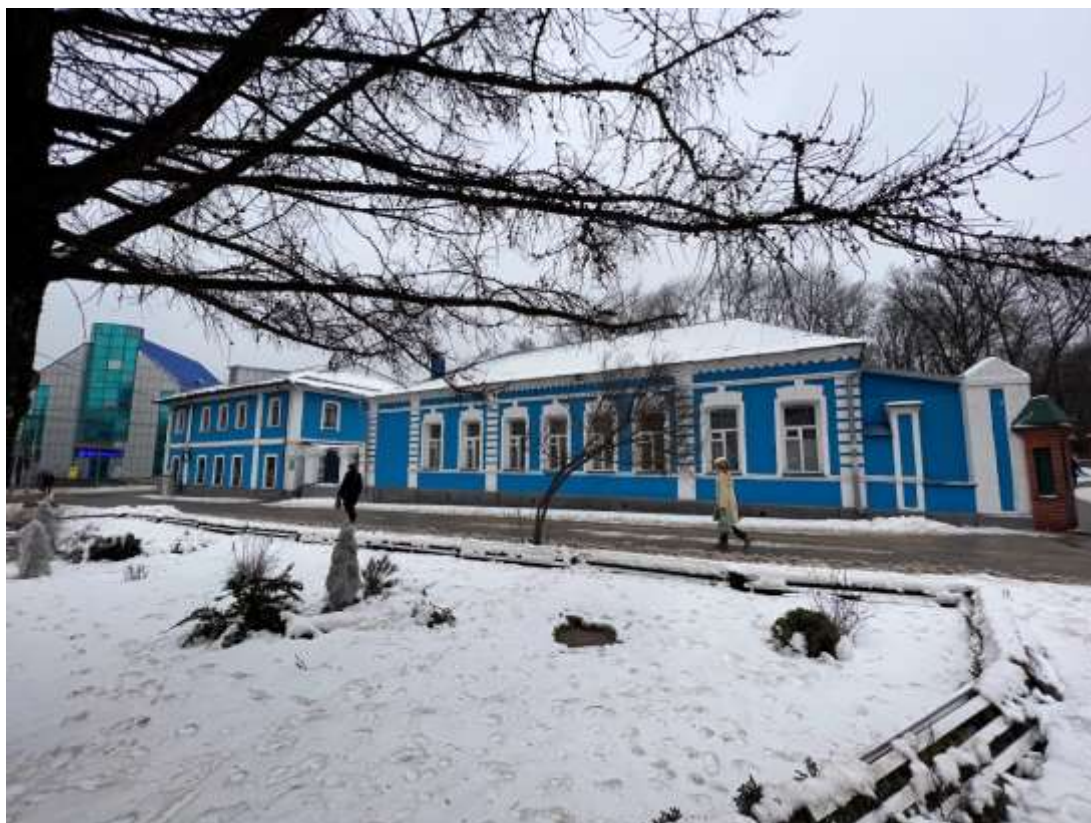
Фотография № 1. Вид с северо-востока на Объект.
