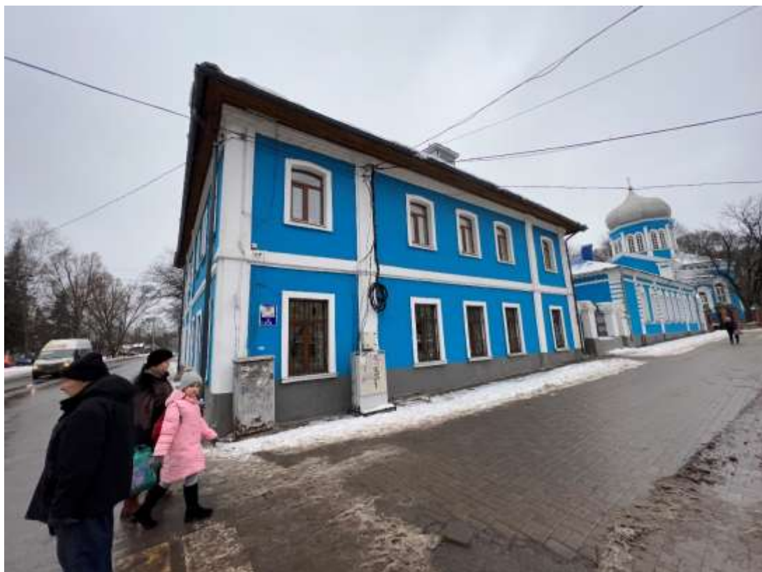
Фотография № 3. Вид с юго-востока на Объект.
