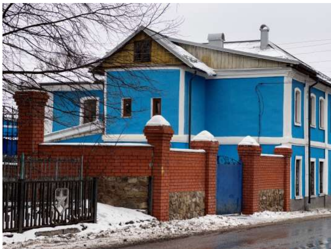
Фотография № 8. Вид с юго-запада на Объект.
