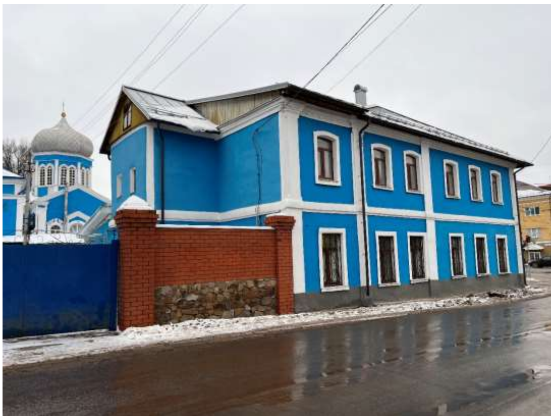
Фотография № 7. Вид с юго-запада на Объект.
