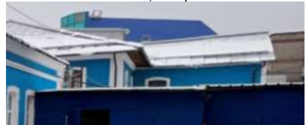
одна световая ось с дверным проемом в дворовой части фасада
