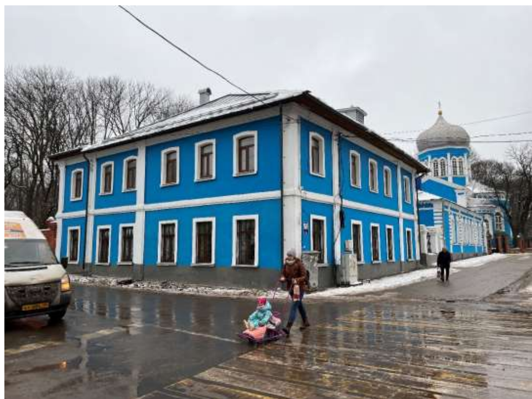
Фотография № 4. Вид с юго-востока на Объект.
