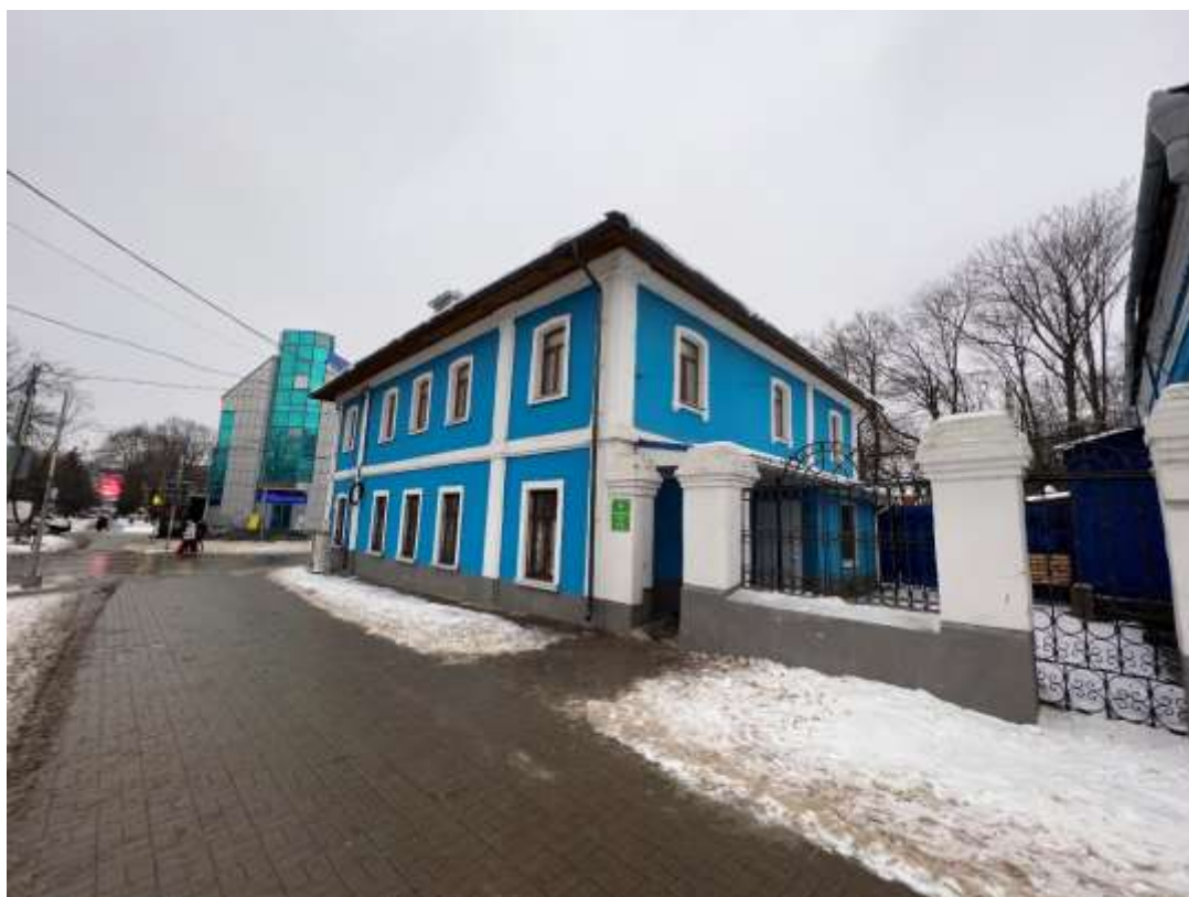
Фотография № 2. Вид с северо-востока на Объект.
