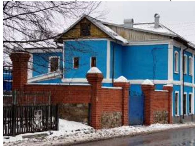
композиция западного дворового фасада
