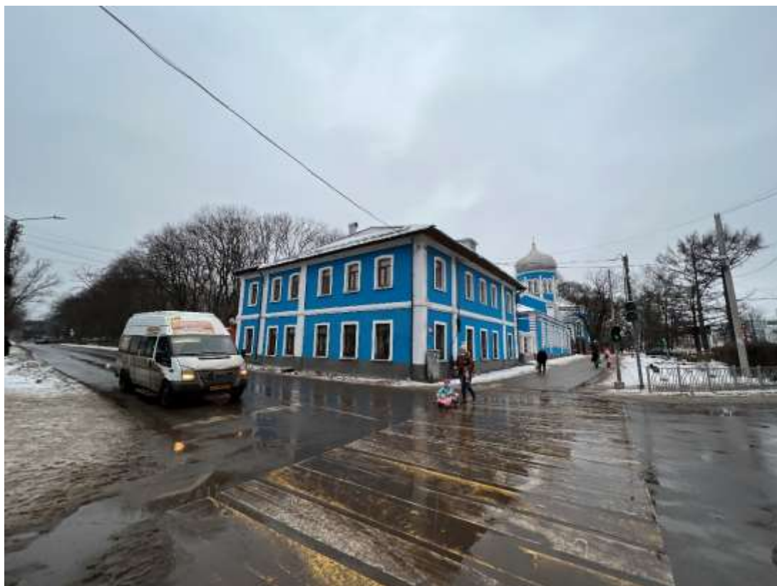
Фотография № 5. Вид с юго-востока на Объект.
