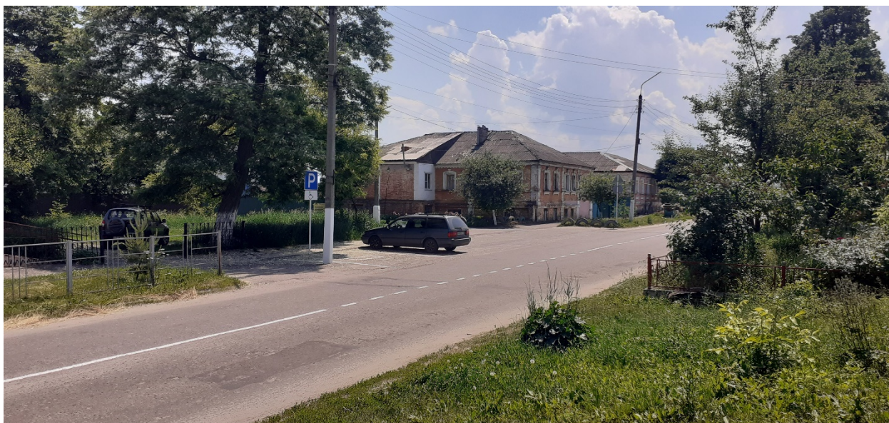
Фотография № 9. Вид с северо-запада на Объект.
