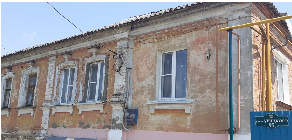
Фотография № 10. Вид с юго-запада на Объект. Центральный фасад. Фрагмент.
