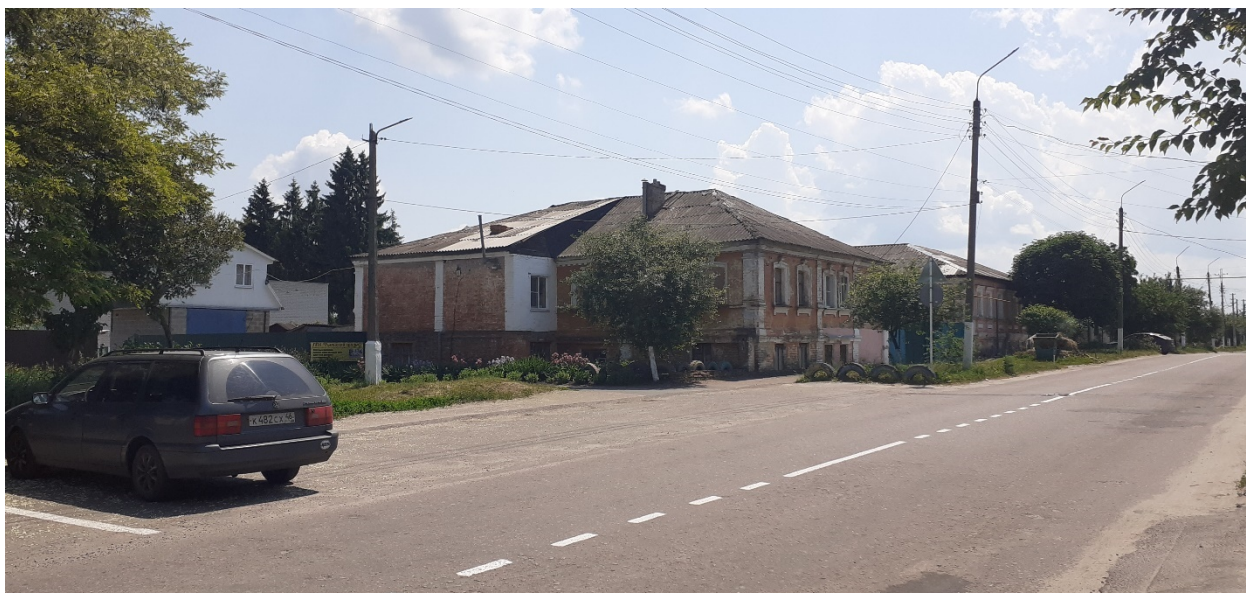
Фотография № 7. Вид с северо-запада на Объект.
