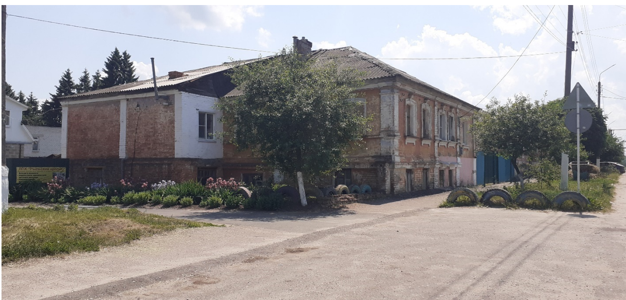
Фотография № 6. Вид с северо-запада на Объект.
