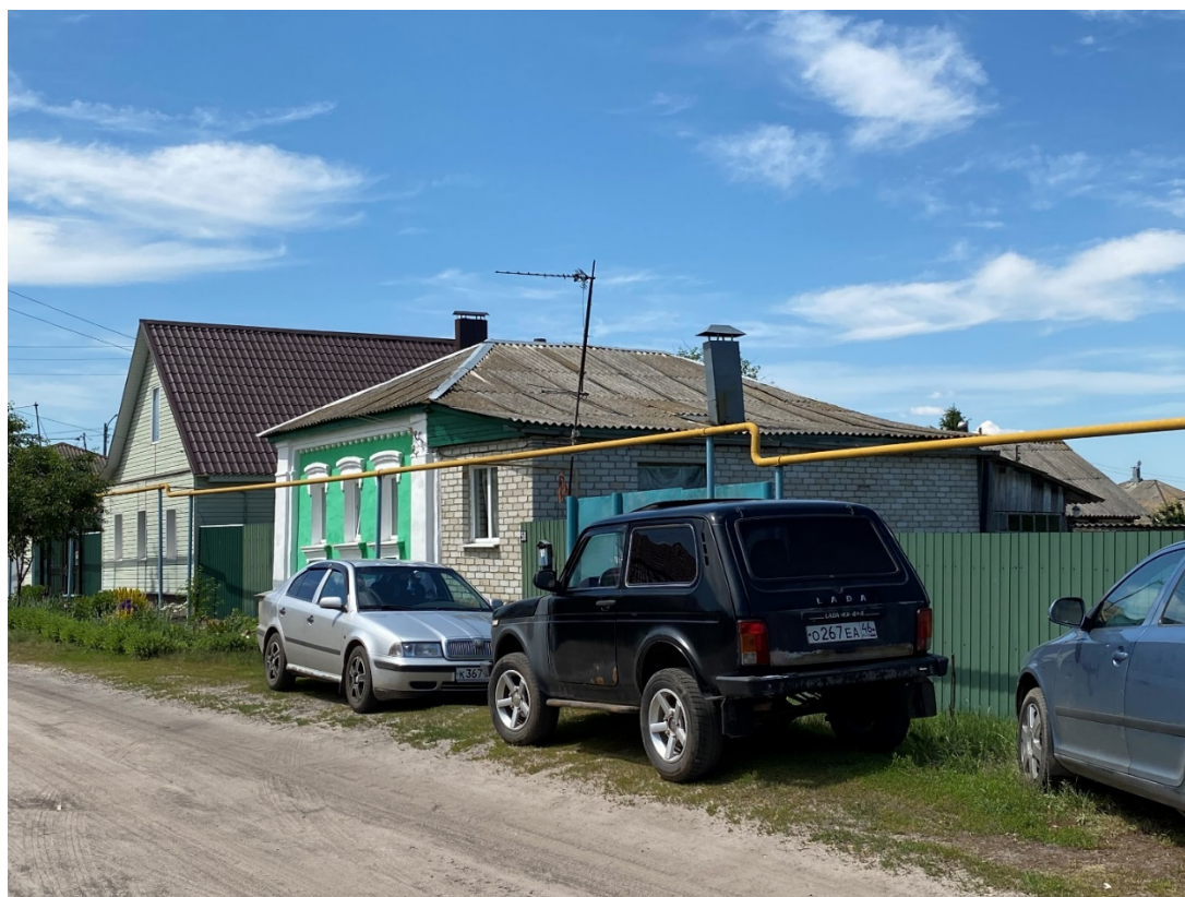
Фотография № 2. Вид с юго-востока на Объект.
