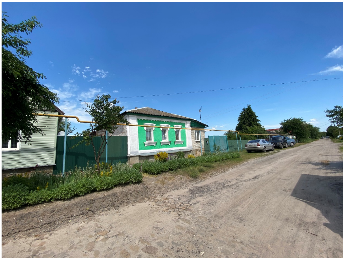
Фотография № 9. Вид с юго-запада на Объект.
