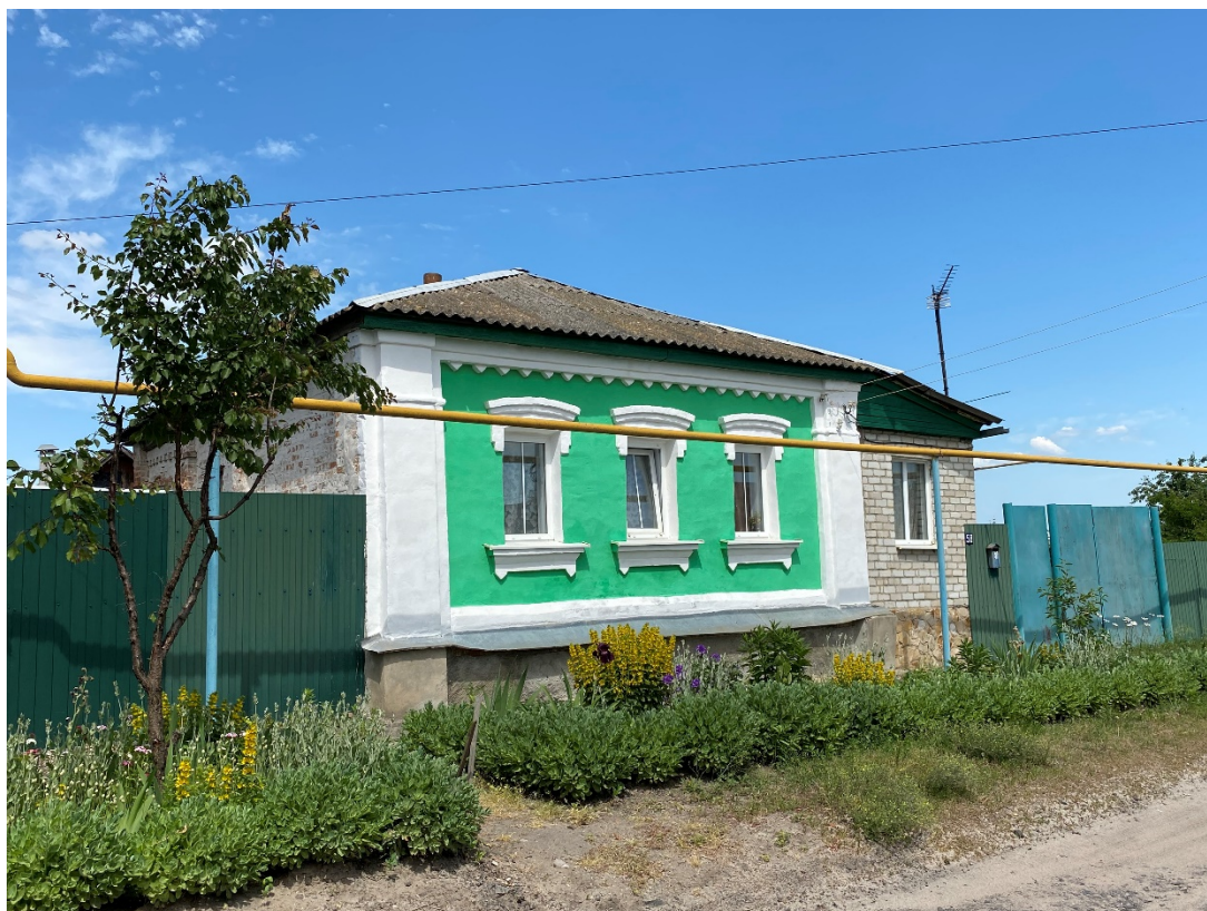
Фотография № 7. Вид с юго-запада на Объект.
