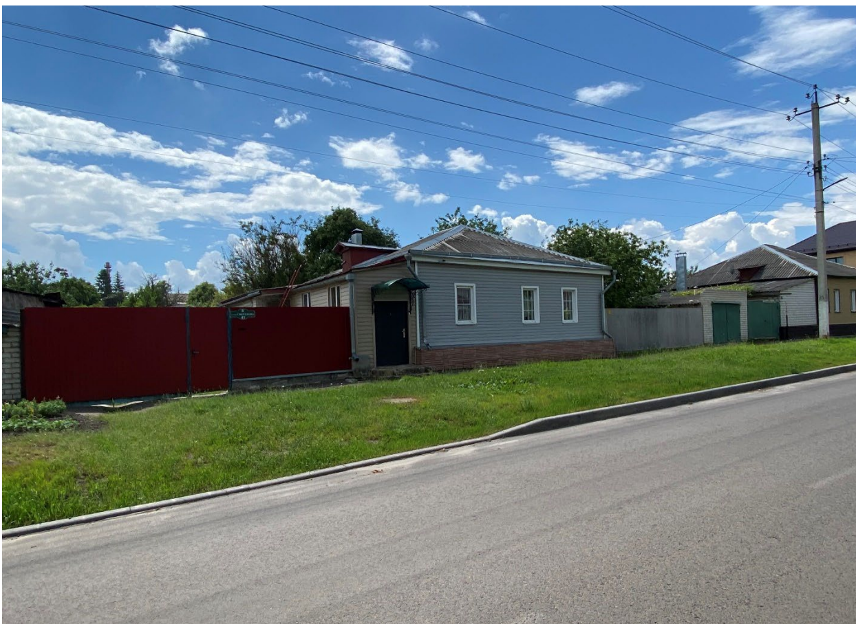
Фотография № 3. Вид с северо-востока на Объект.
