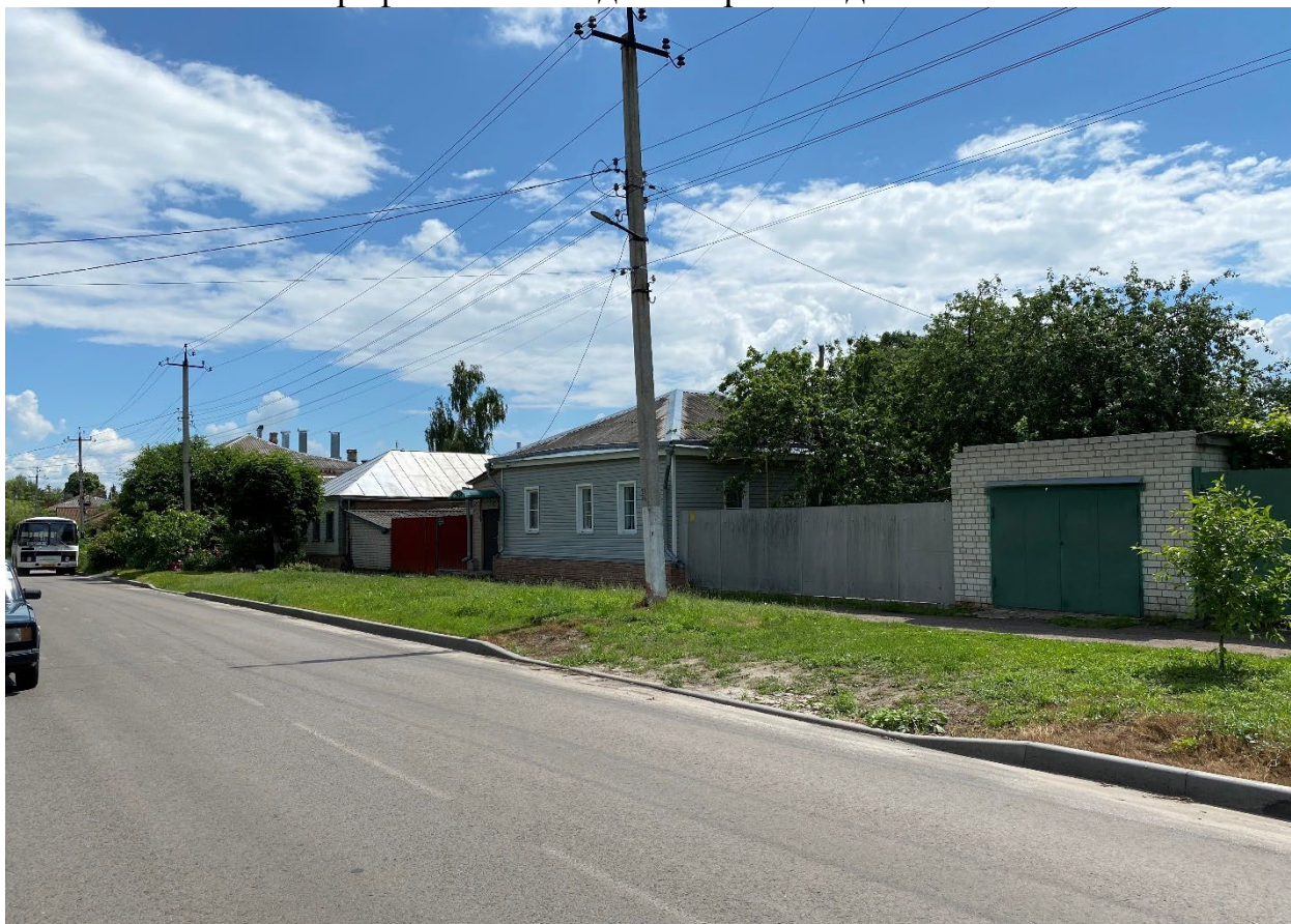
Фотография № 12. Вид с северо-запада на Объект.
