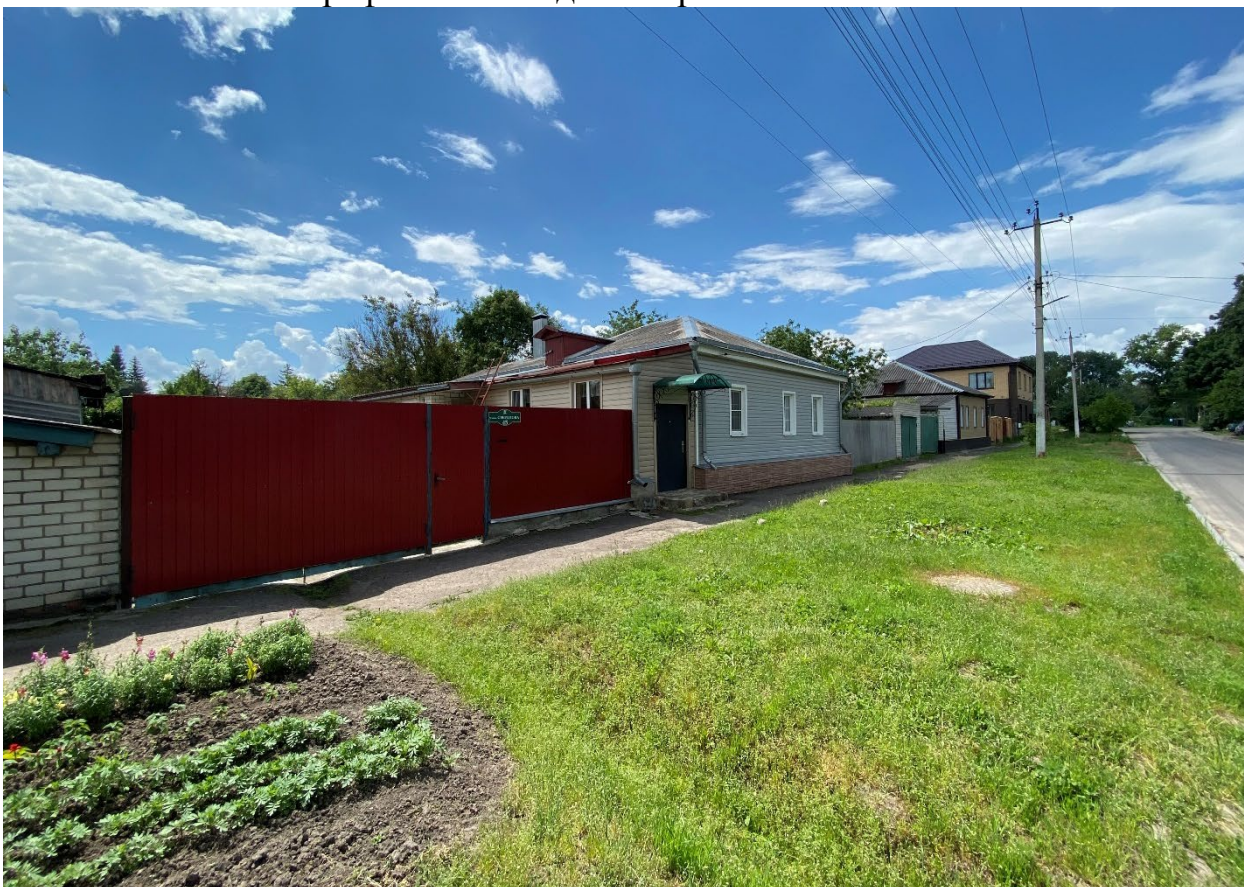
Фотография № 2. Вид с северо-востока на Объект.
