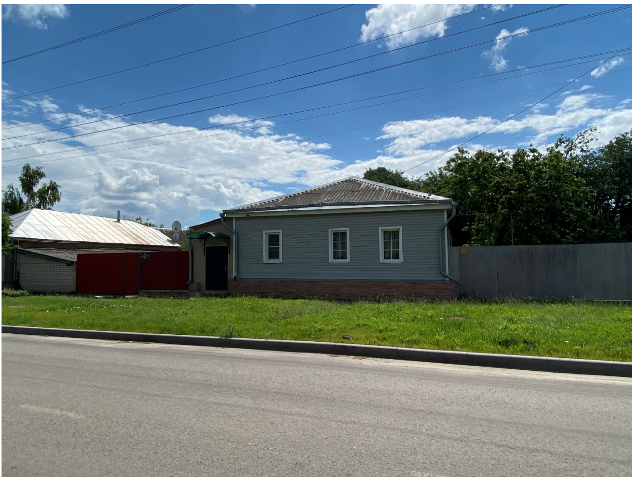
Фотография № 9. Вид с северо-запада на Объект.
