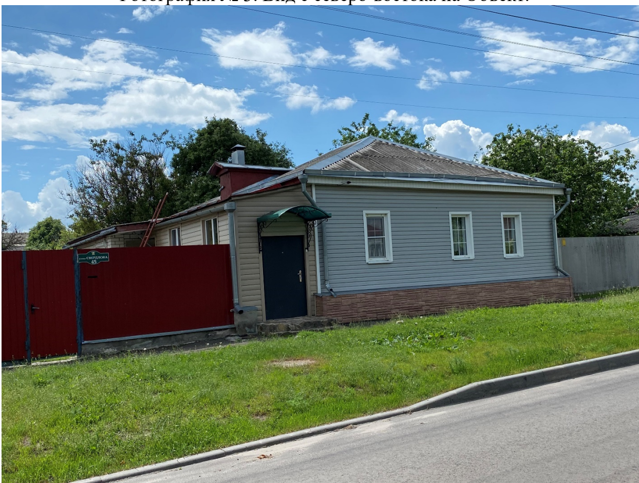
Фотография № 4. Вид с северо-востока на Объект.
