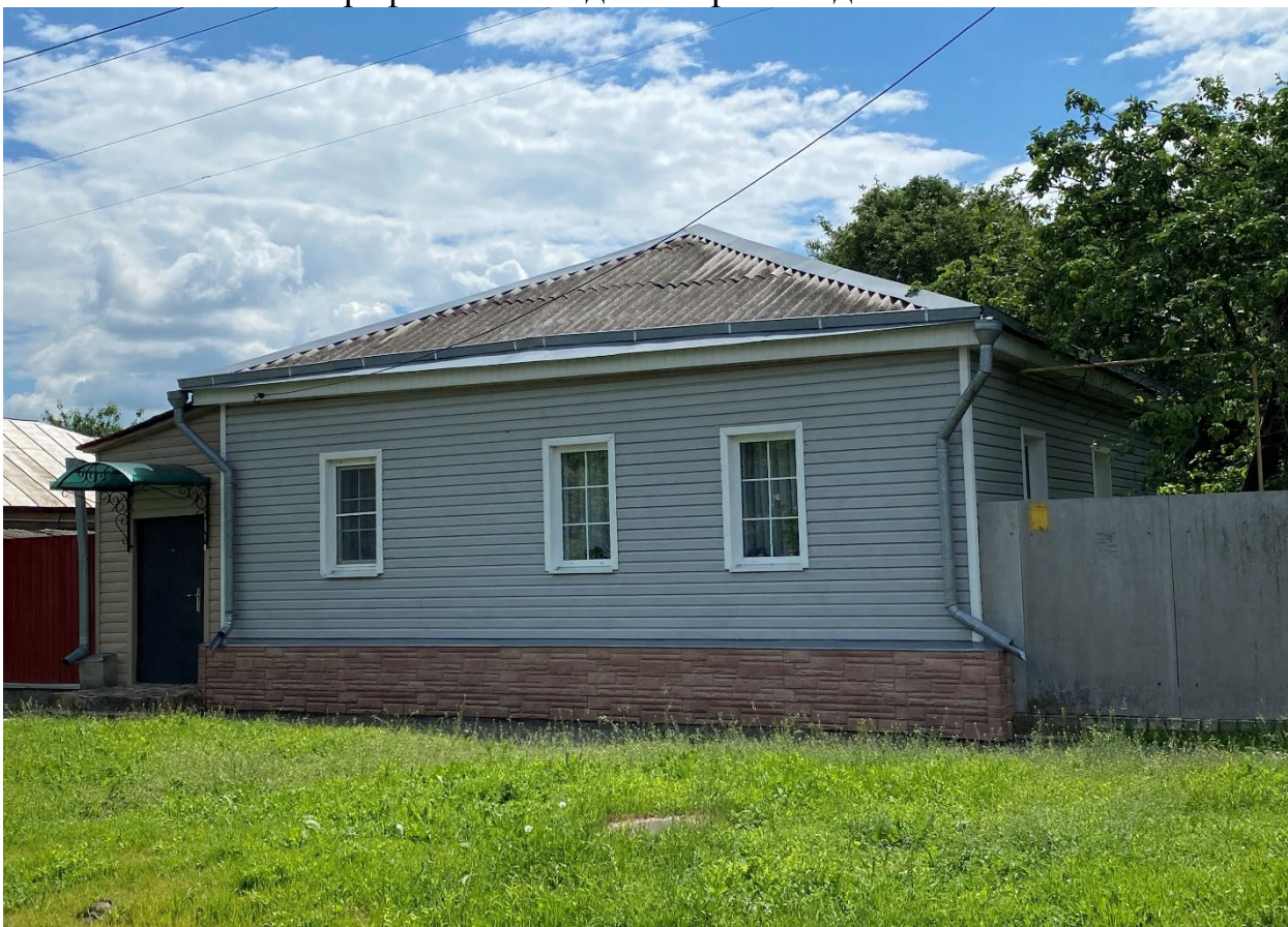
Фотография № 10. Вид с северо-запада на Объект.
