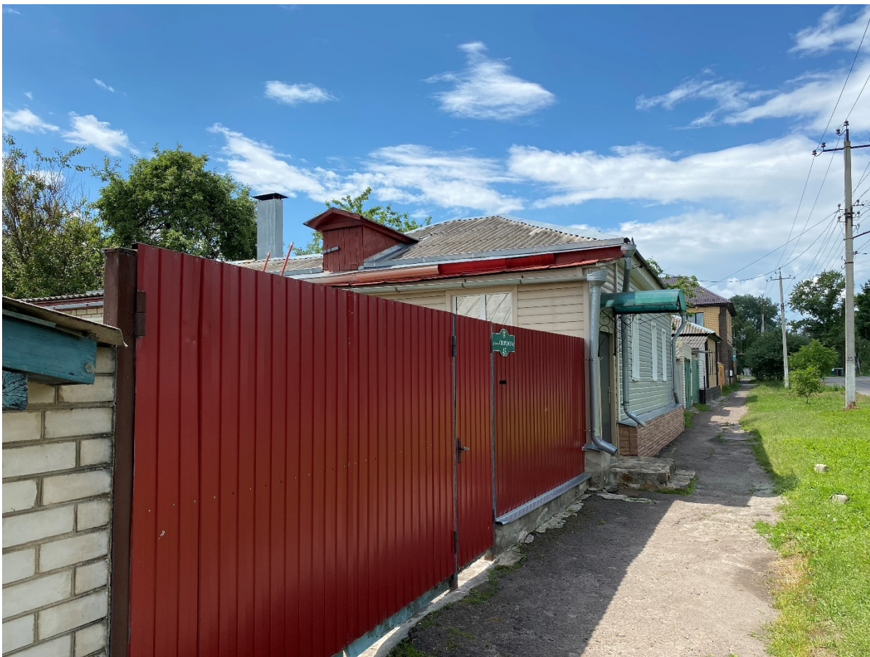
Фотография № 1. Вид с северо-востока на Объект.
