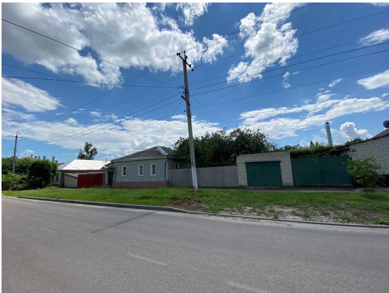
Фотография № 11. Вид с северо-запада на Объект.
