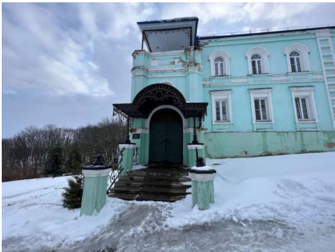
Т.ф. 3. Общий вид входной группы в здание с северной стороны
