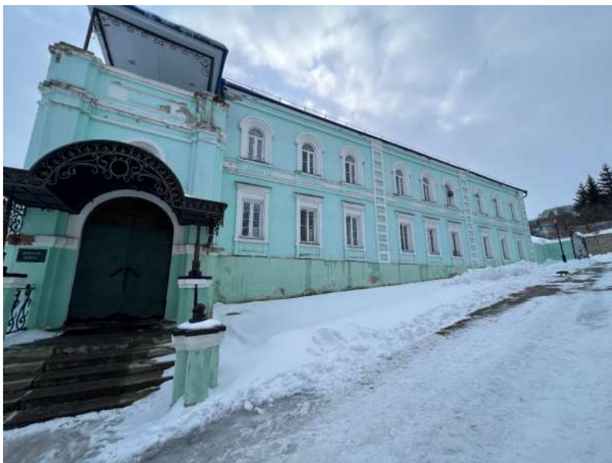
Т.ф. 2. Общий вид северного фасада Объекта
