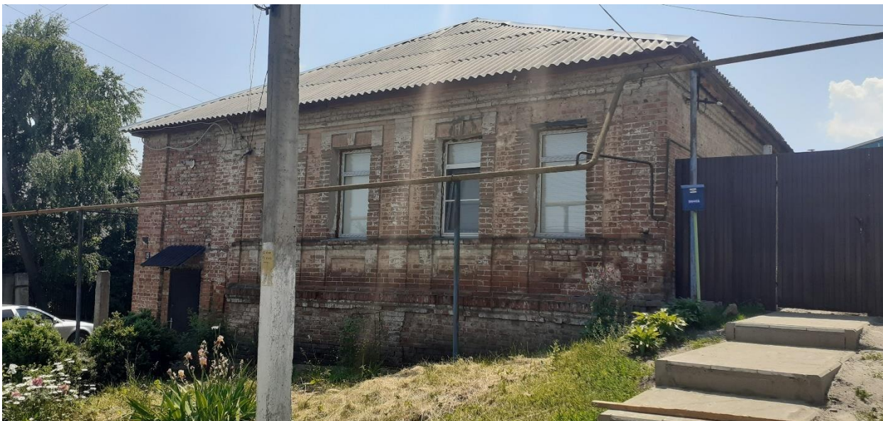
Фотография № 7. Вид с северо-запада на Объект.
