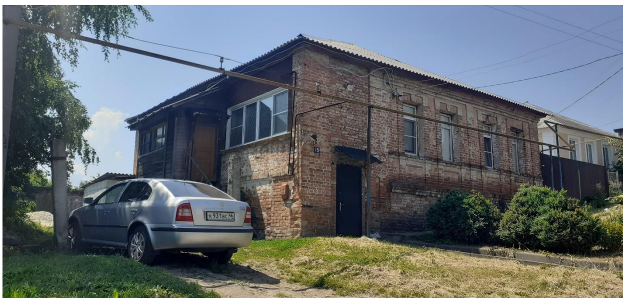
Фотография № 4. Вид с северо-востока на Объект.
