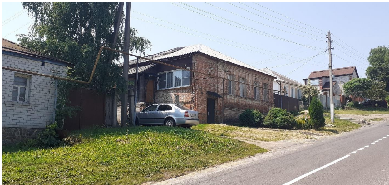
Фотография № 3. Вид с северо-востока на Объект.
