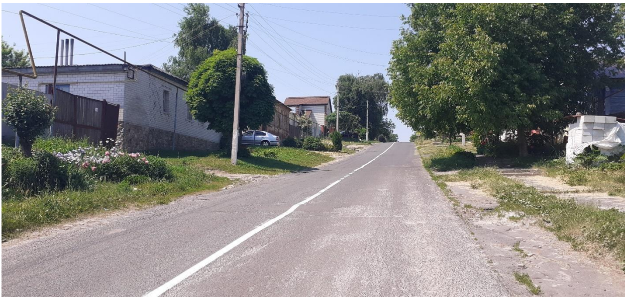
Фотография № 1. Вид с северо-востока на Объект.
