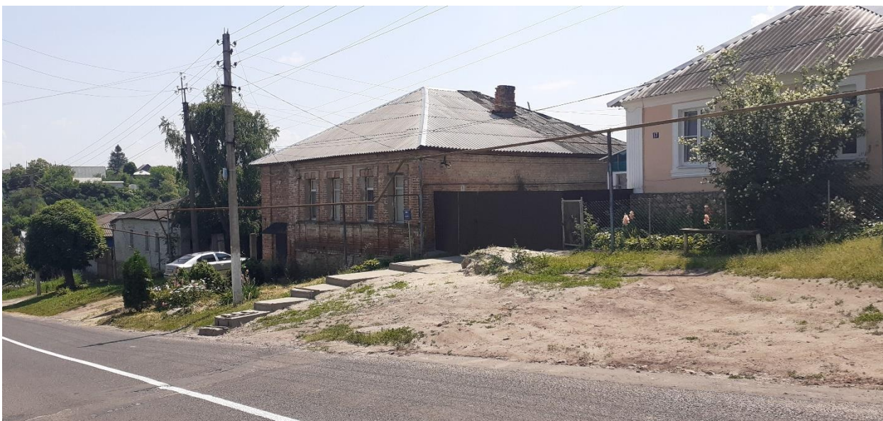
Фотография № 9. Вид с северо-запада на Объект.
