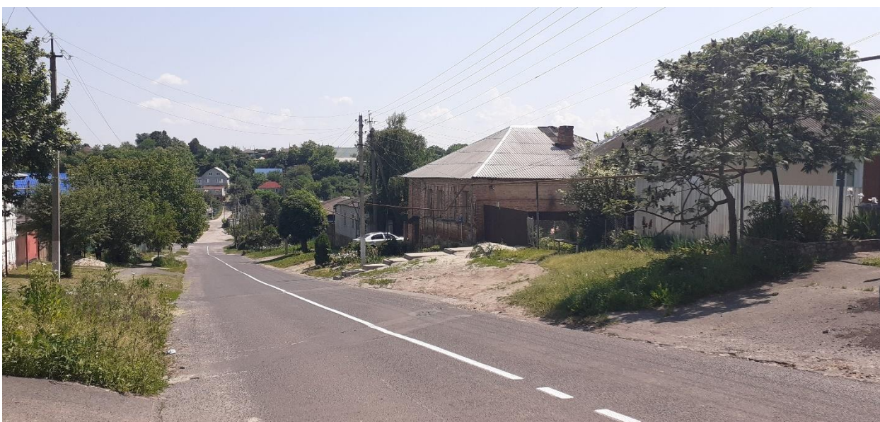
Фотография № 10. Вид с северо-запада на Объект.
