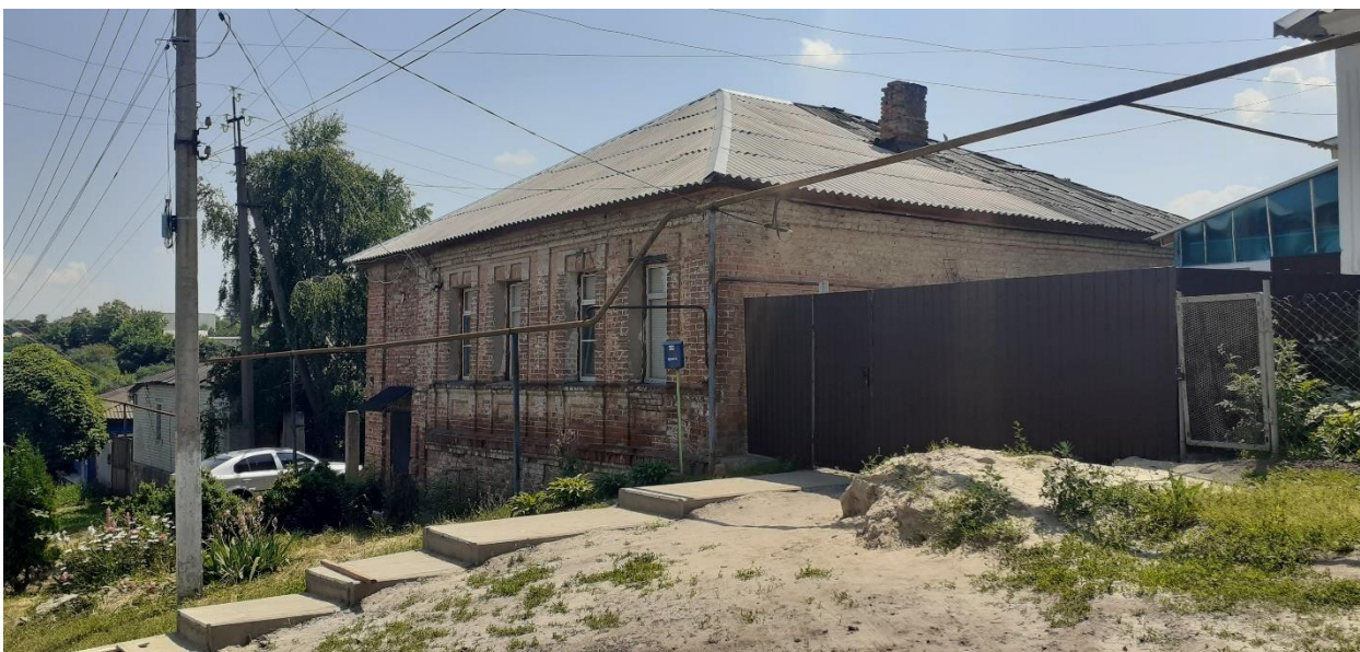
Фотография № 8. Вид с северо-запада на Объект.
