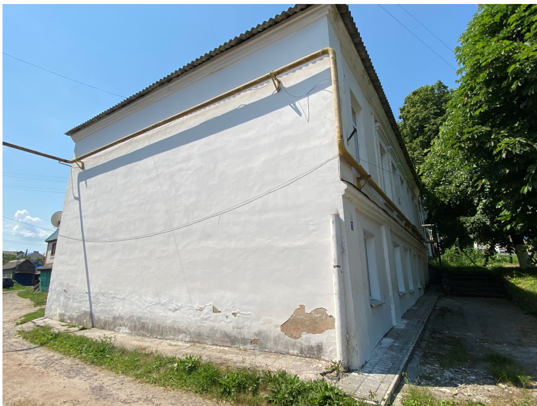
Фотография № 9. Вид с северо-востока на Объект.
