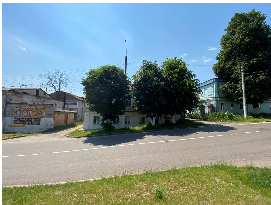
Фотография № 6. Вид с севера на Объект.
