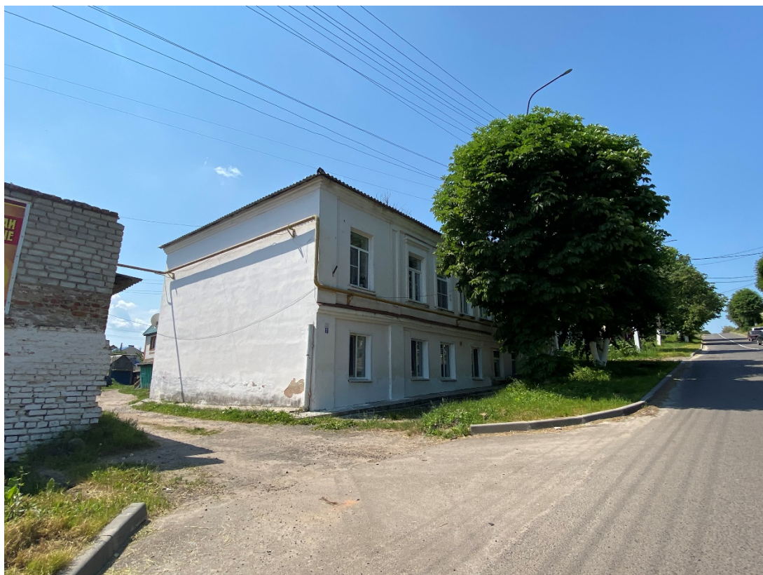
Фотография № 8. Вид с северо-востока на Объект.
