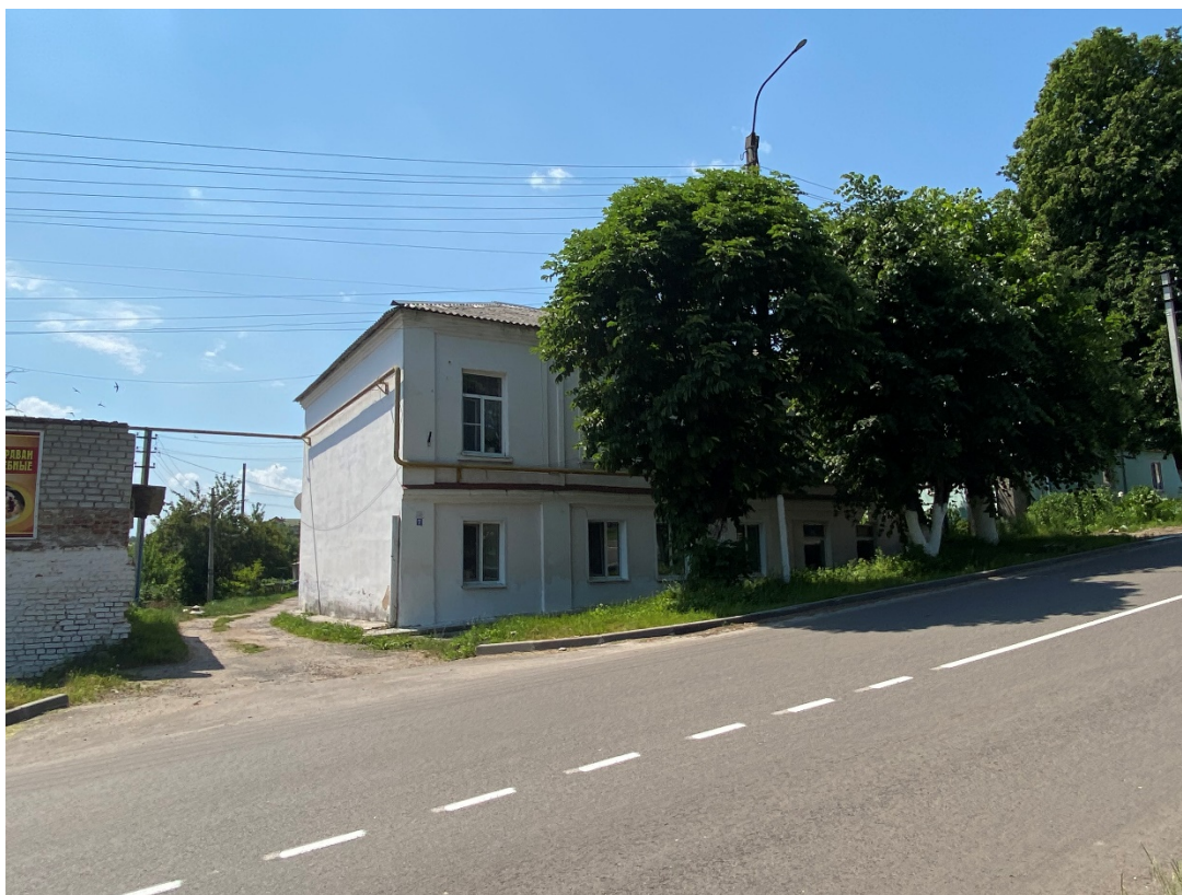
Фотография № 7. Вид с северо-востока на Объект.
