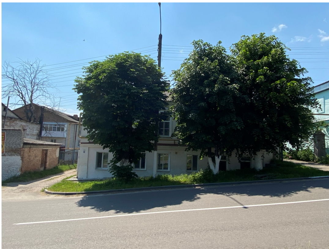
Фотография № 5. Вид с севера на Объект.
