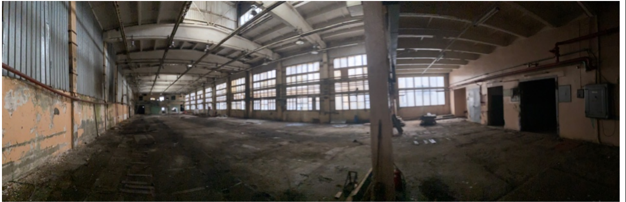
Объект проектирования (помещения). Общий вид. Автор и дата: А.Ф. Мартынов; 15.12.2021
