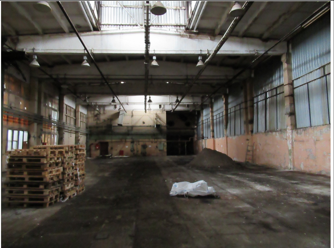
Объект проектирования (помещения). Общий вид. Автор и дата: А.Ф. Мартынов; 15.12.2021
