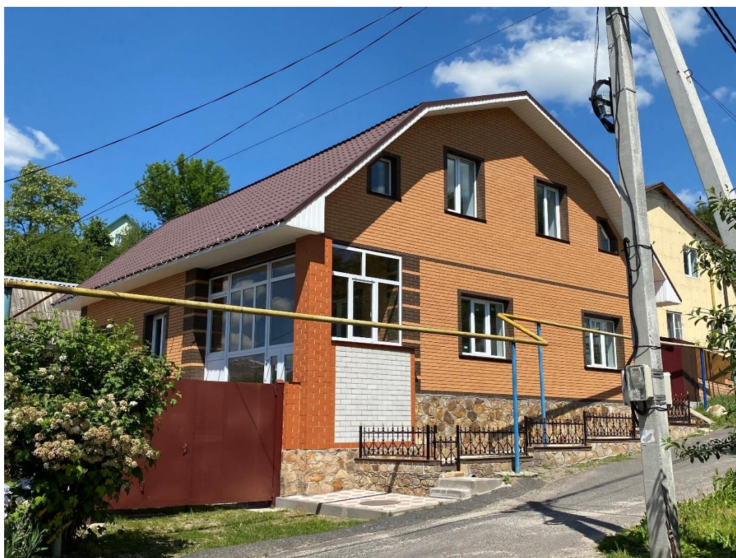
Фотография № 6. Вид с юго-запада на Объект.
