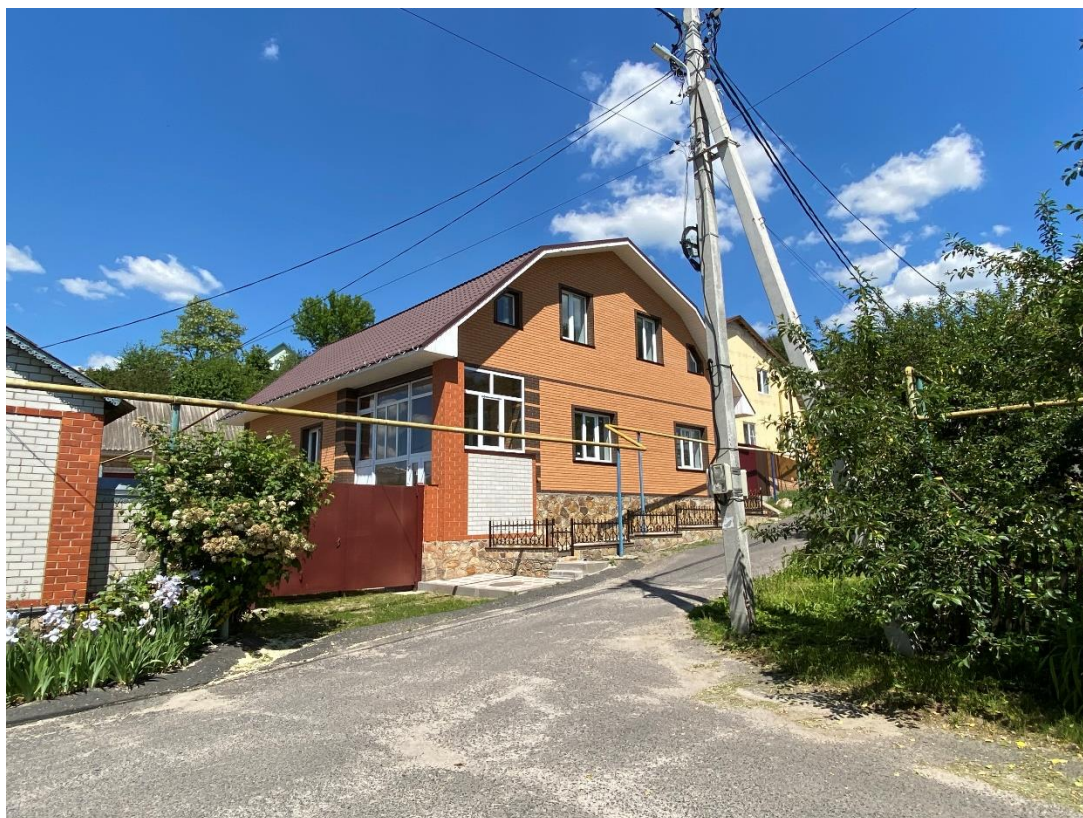
Фотография № 5. Вид с юго-запада на Объект.
