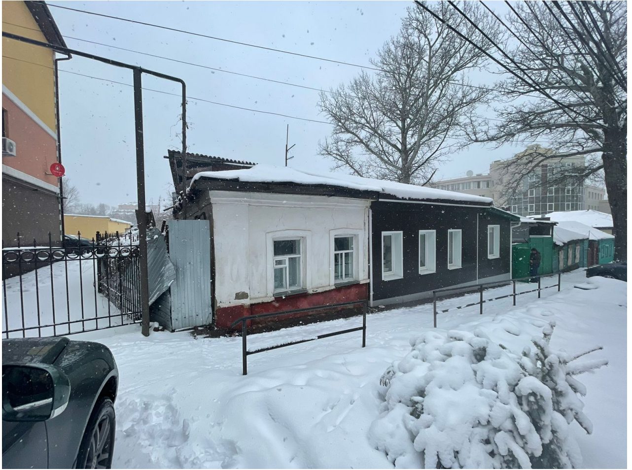
Выявленный объект культурного наследия «Дом жилой, кон. XIX-нач. XX вв.» (г. Курск, ул. Мирная, 14). Общий вид. Автор и дата: А.Ф. Мартынов; 04.03.2022
