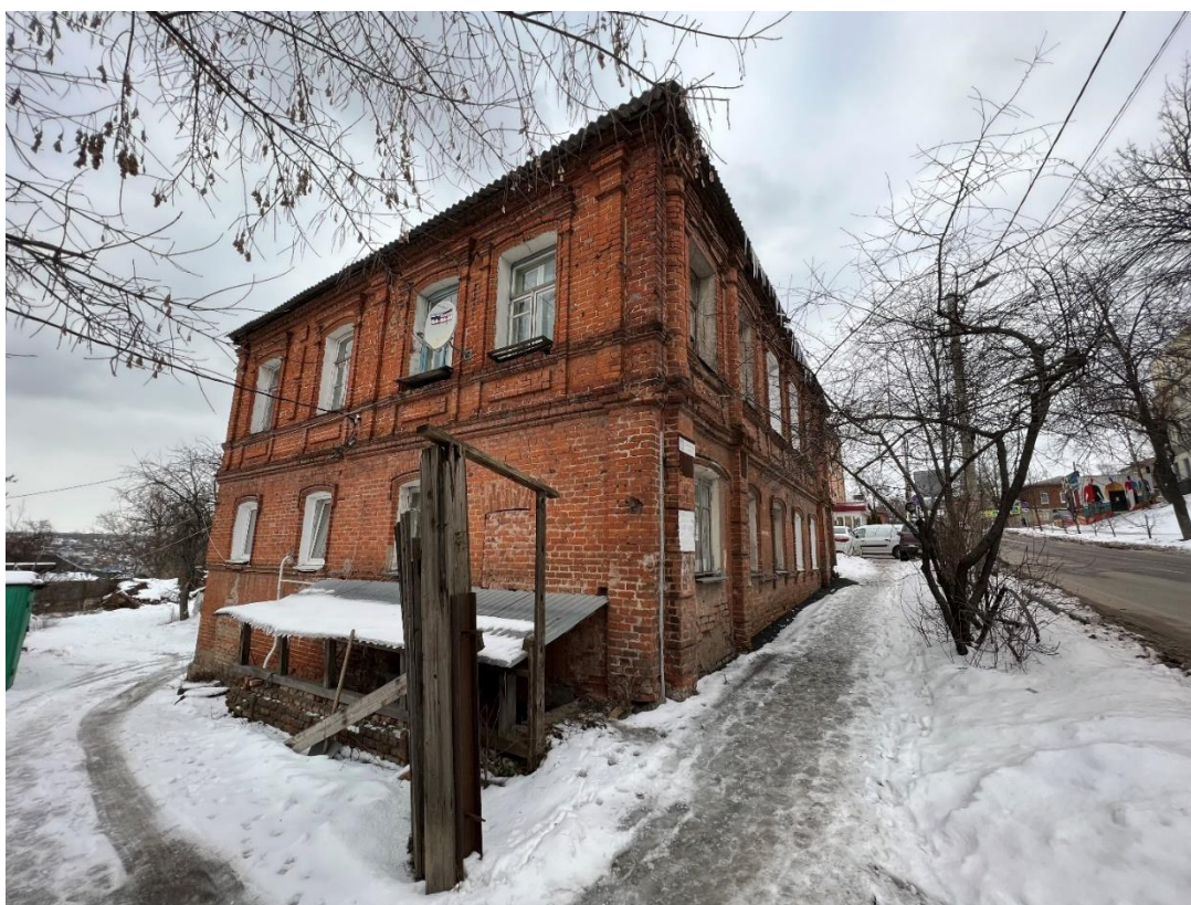
Фотография № 2. Вид с юго-востока на Главный усадебный дом.
