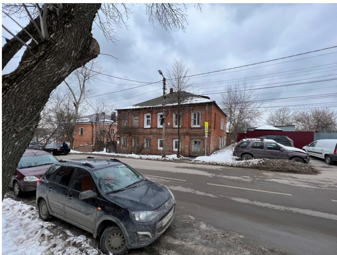
Фотография № 24. Вид с северо-востока на Главный усадебный дом.
