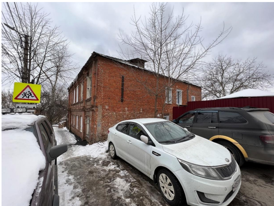
Фотография № 27. Вид с северо-востока на Главный усадебный дом.
