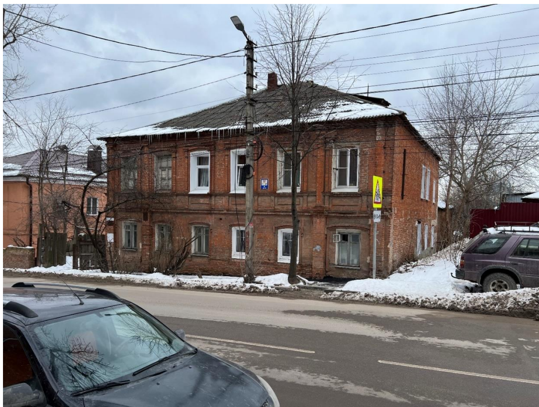
Фотография № 25. Вид с северо-востока на Главный усадебный дом.
