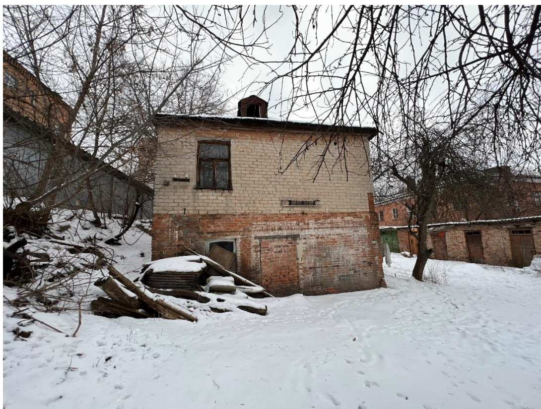
Фотография № 18. Вид с запада на Флигель.
