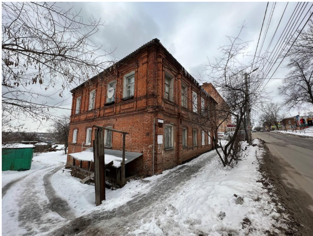
Фотография № 1. Вид с юго-востока на Главный усадебный дом.
