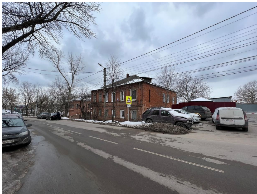
Фотография № 28. Вид с северо-востока на Главный усадебный дом.
