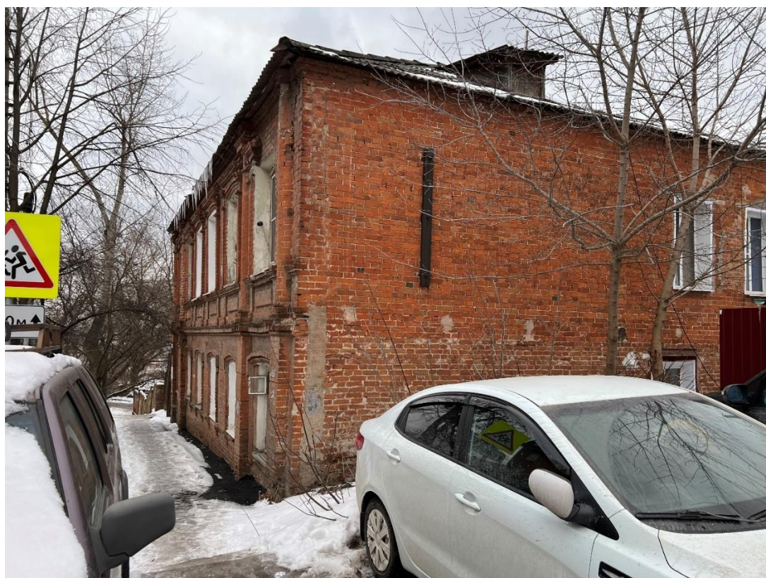
Фотография № 26. Вид с северо-востока на Главный усадебный дом.
