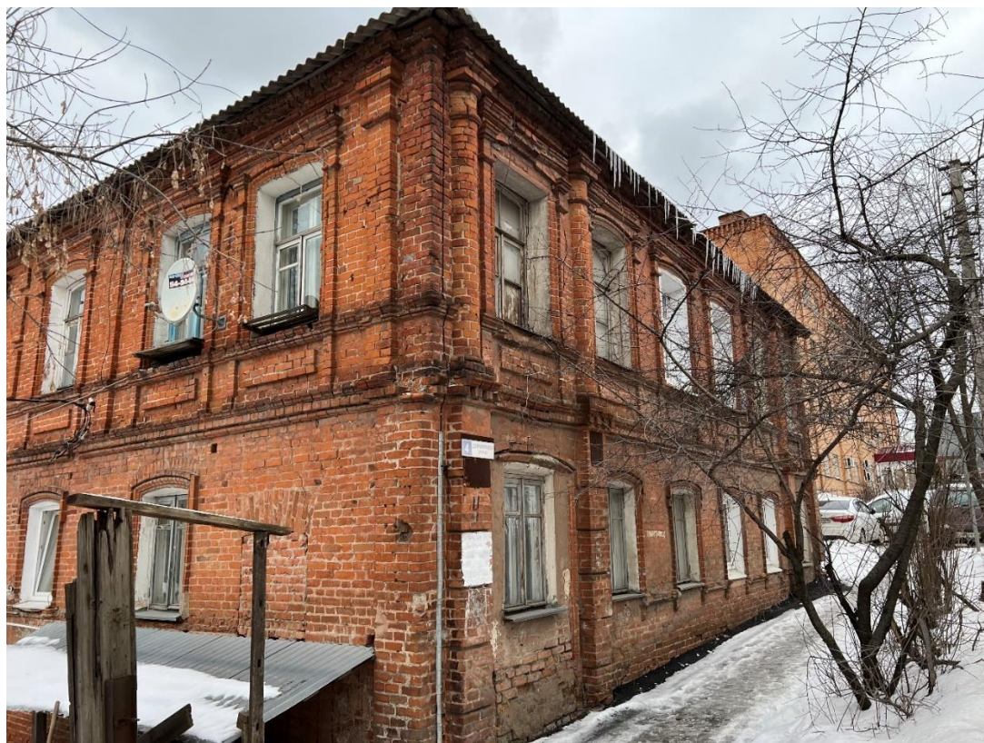
Фотография № 3. Вид с юго-востока на Главный усадебный дом.
