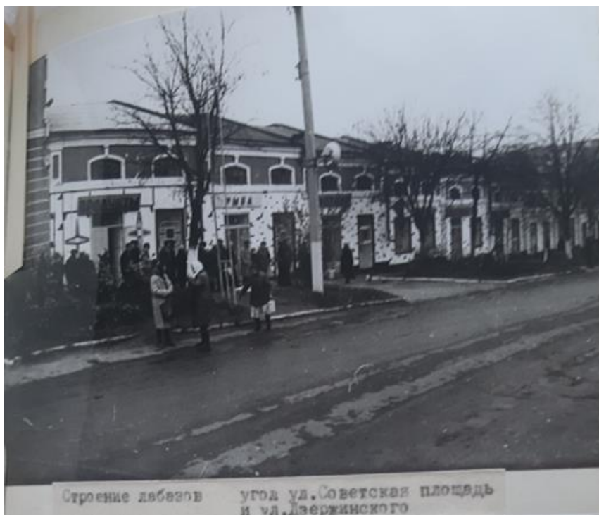
Строение лабазов, угол ул. Советская и ул. Дзержинского, середина XIX в. Здание Объекта на фотографии в «Проекте охранных зон г. Рыльска Курской обл.» 1990 года
