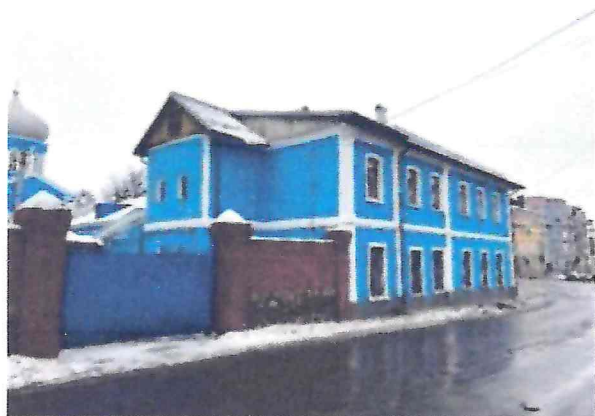
Вид на дворовый западный фасад и лицевой фасад по ул. Красный Октябрь
