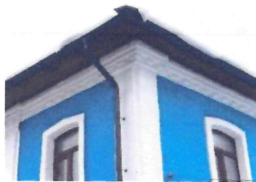
Венчающий карниз и угловая лопатка
