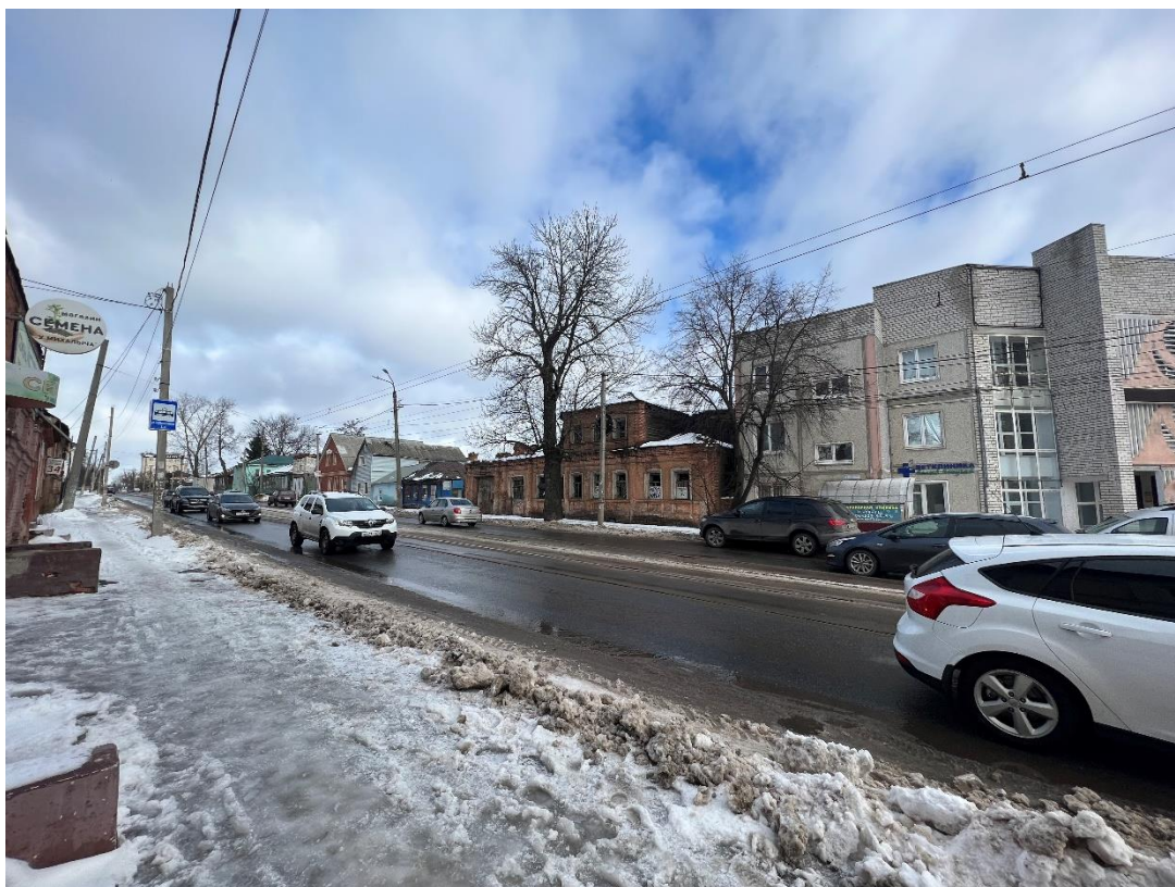
Фотография № 9. Вид с юго-запада на Объект.
