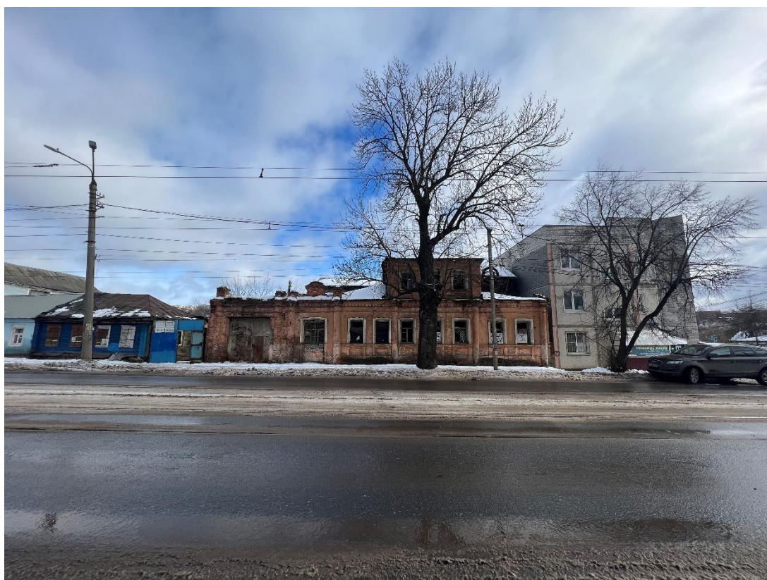
Фотография № 6. Вид с юго-запада на Объект.
