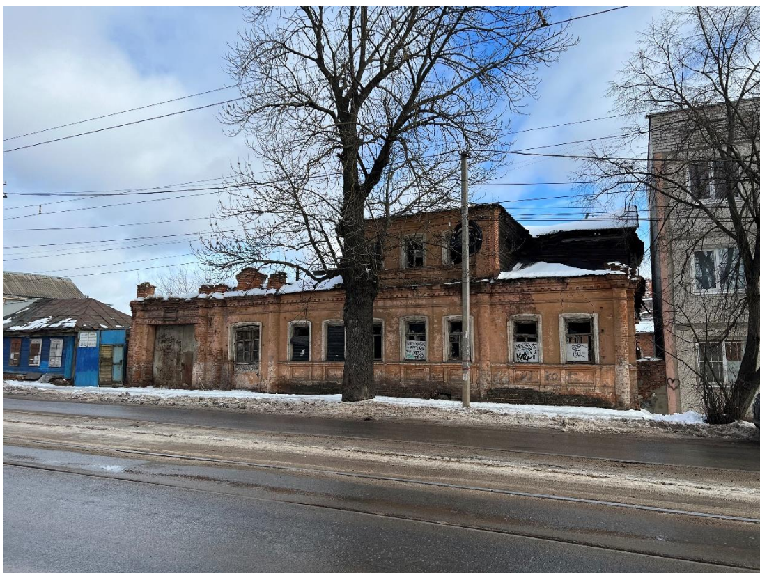
Фотография № 7. Вид с юго-запада на Объект.
