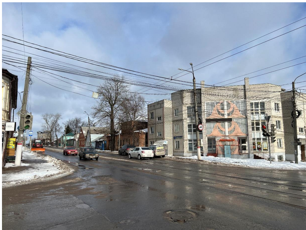
Фотография № 10. Вид с юга на Объект.
