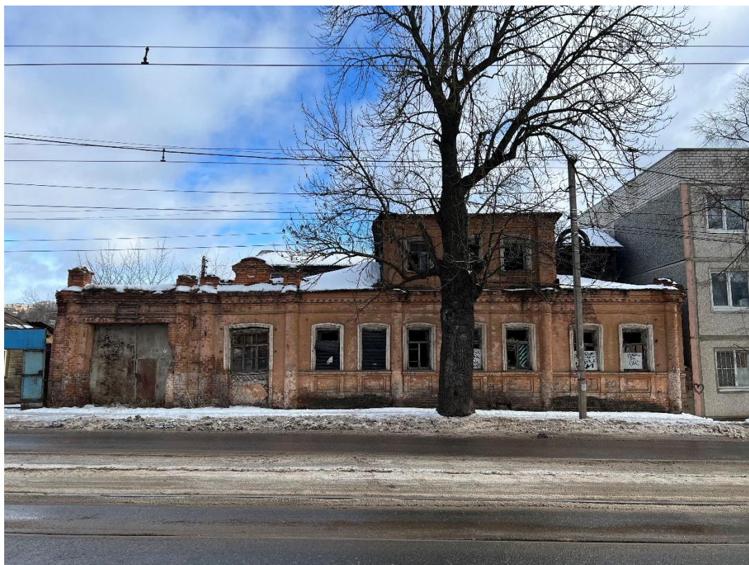
Фотография № 5. Вид с юго-запада на Объект.
