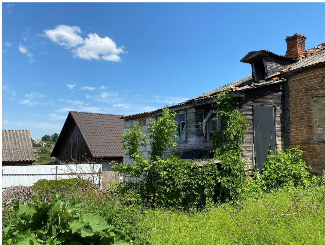
Фотография № 11. Вид с юго-запада на Объект.
