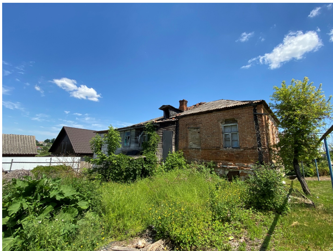
Фотография № 10. Вид с запада на Объект.
