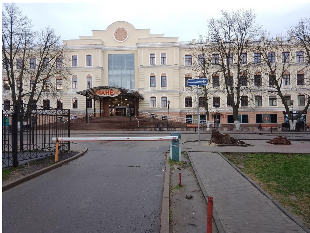
Фотография № 6. Вид с северо-востока на Объект.
