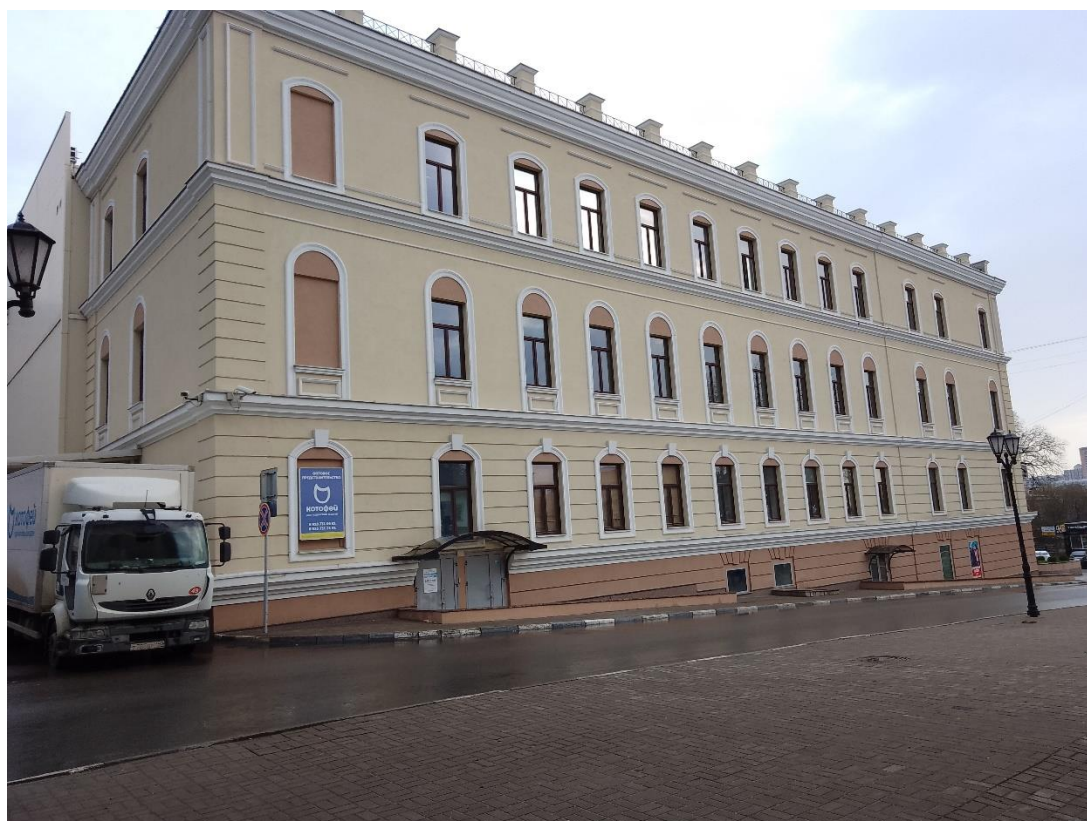
Фотография № 14. Вид с юга на Объект.
