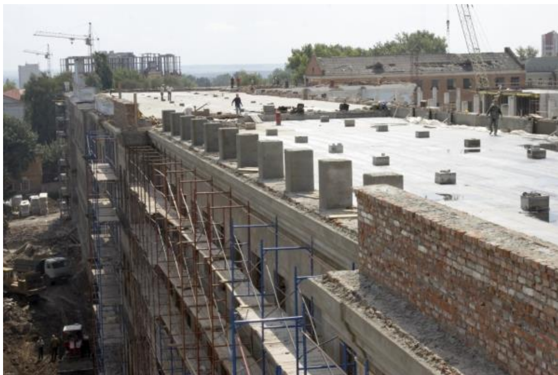
49. Курск. Вид на крышу Объекта в период реконструкции. Фотография, 2006 г. Источник: https://lenox.ru/project/mall-manege/
