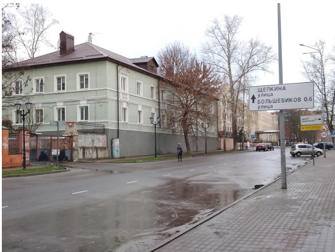
Фотография № 18. Вид с юго-востока на Объект.
