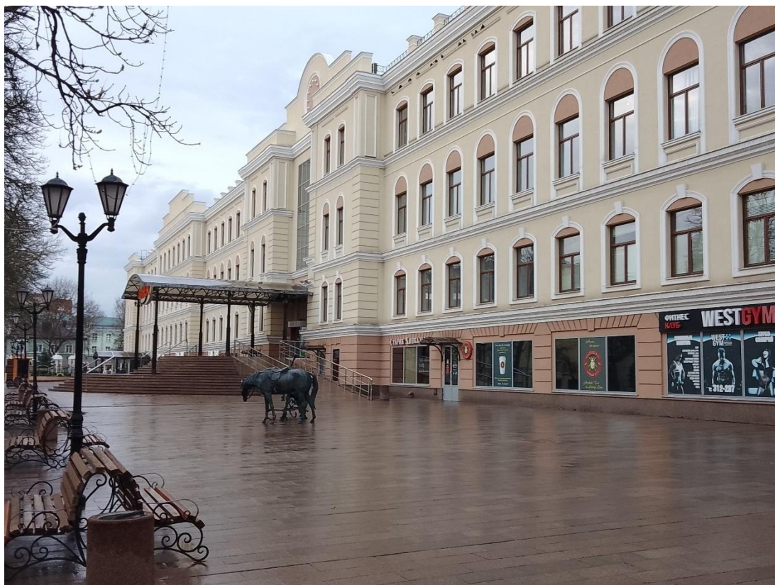
Фотография здания Объекта – ул. Щепкина, 4Б. Вид с севера. Автор: Е.М. Федосеева
