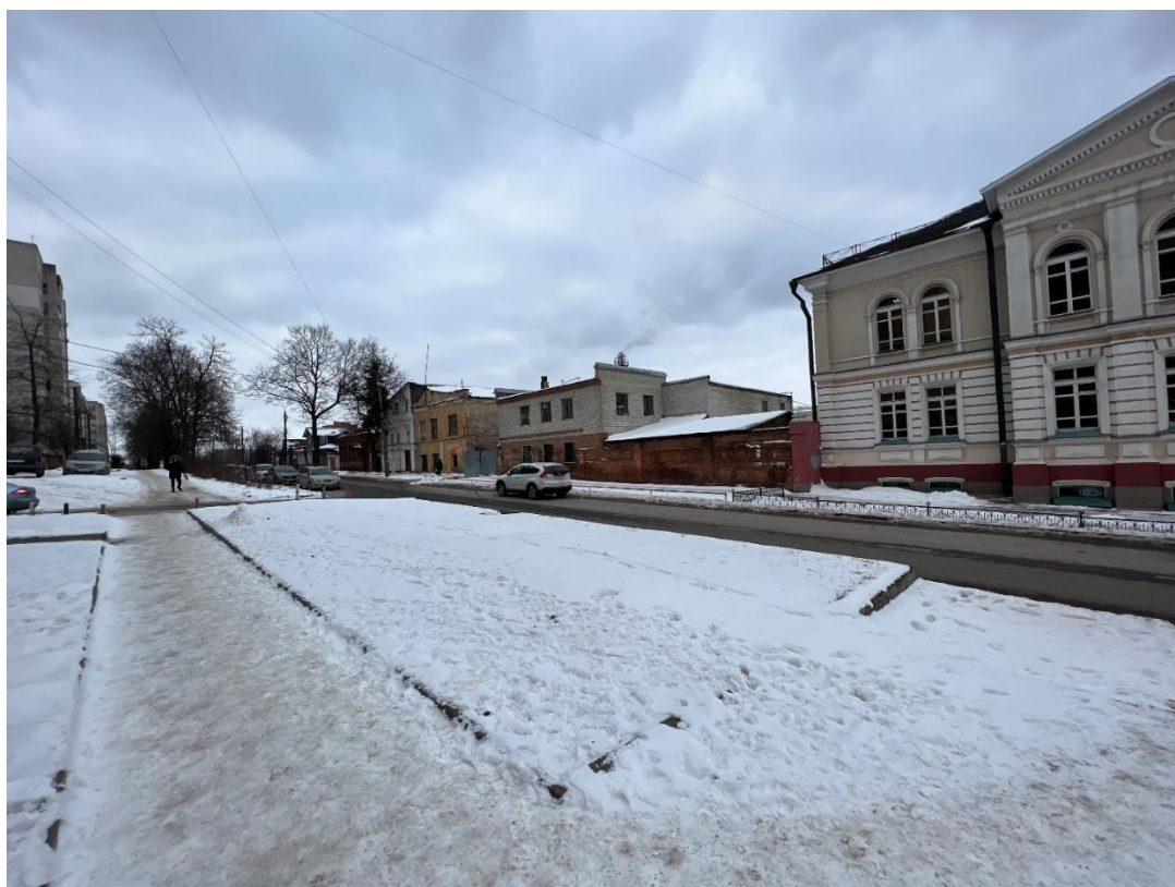
Фотография исследуемой территории – ул. Ломоносова, от д. 3 до д. 3Б. Вид с юга. Автор: Е.М. Федосеева
