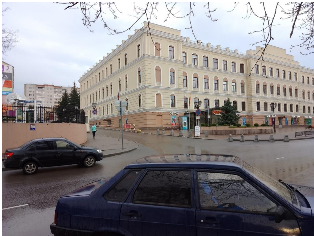
Фотография № 13. Вид с востока на Объект.
