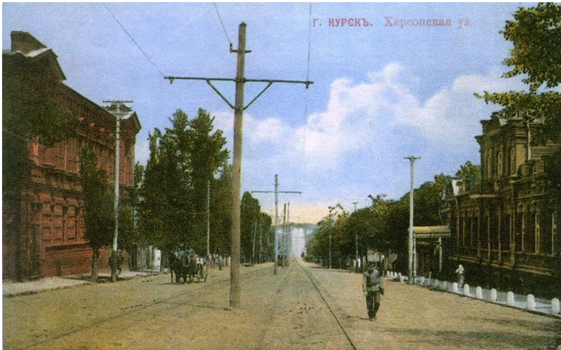
26. Вид Херсонской ул. в направлении к Красной площади на участке между улицами Театрально - Дружининской и Ломоносовской - Чумаковской. Открытка, 1900-1910-е гг. Слева – здание Образцовой церковно-приходской школы при Духовной Семинарии со Знаменской домовою церковью. Источник: https://old.kurskcity.ru/pubs/photo/221
