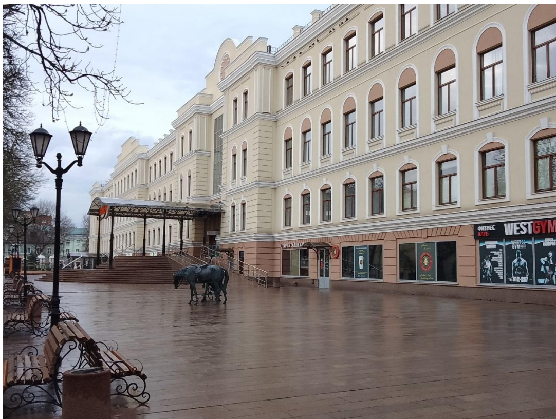
Фотография № 3. Вид с севера на Объект.
