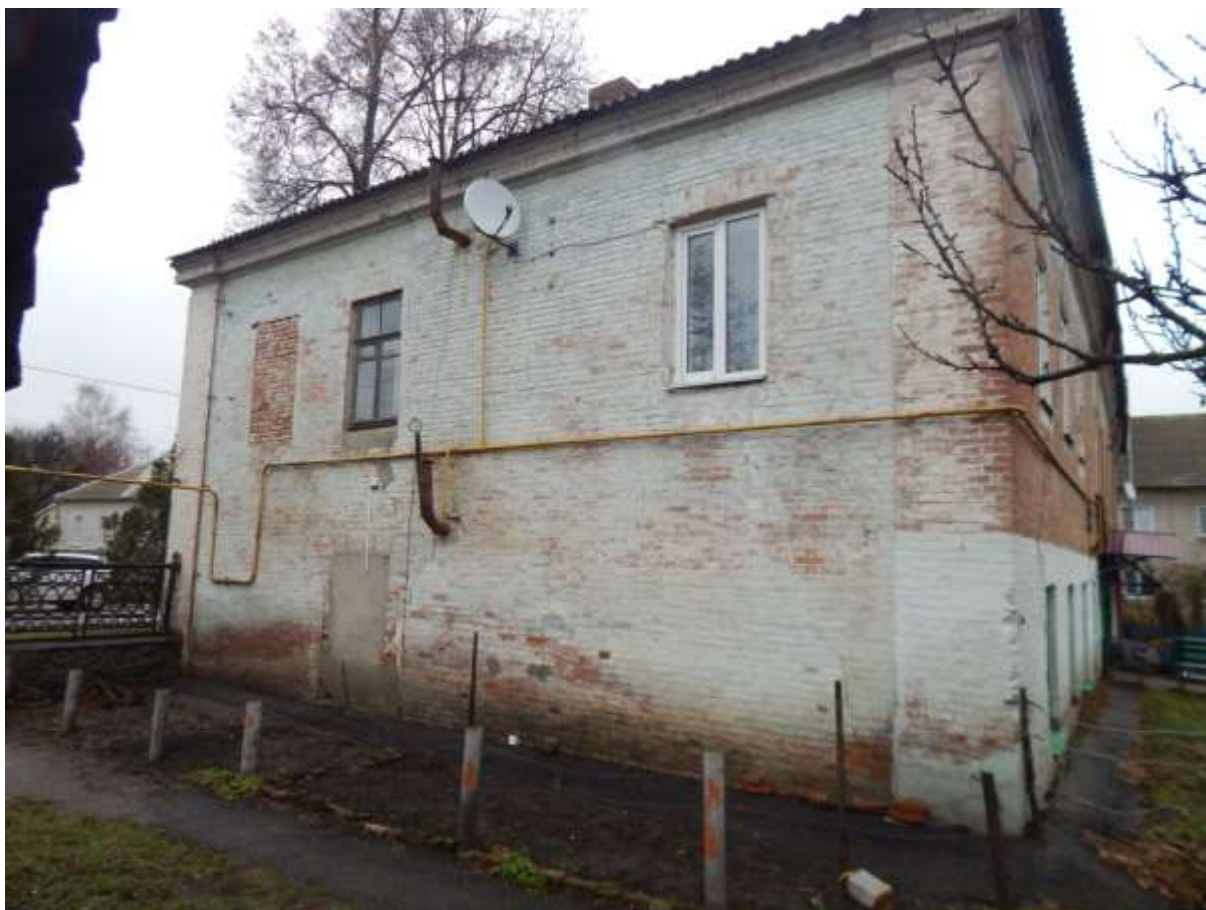
Т.ф. 6. Отдельные элементы декоративного убранства бокового фасада Объекта.
