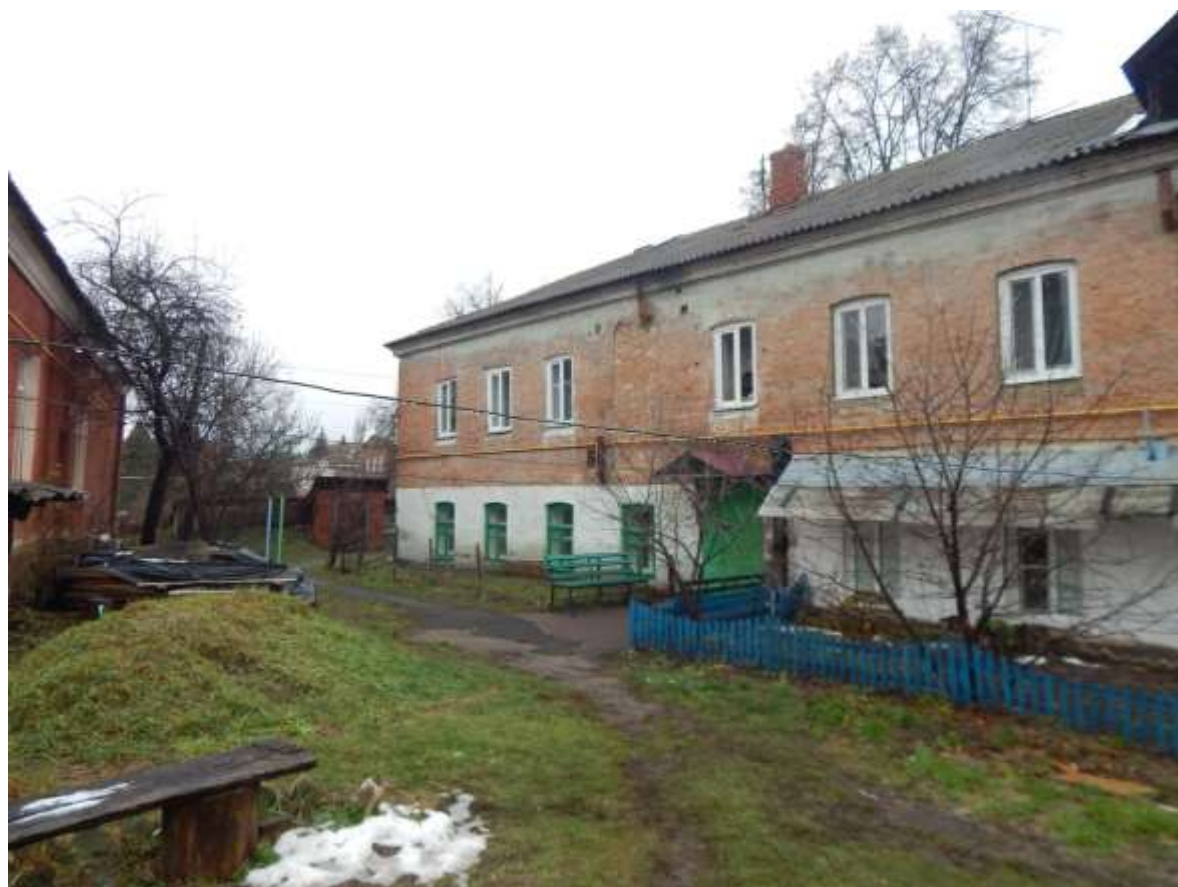
Т.ф. 4. Общий вид дворового фасада Объекта.
