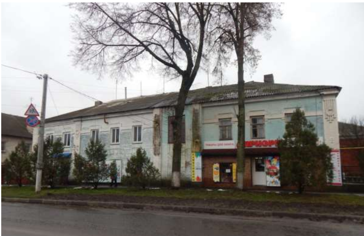
«Здание больницы» по улице 1 Мая, д. 18
