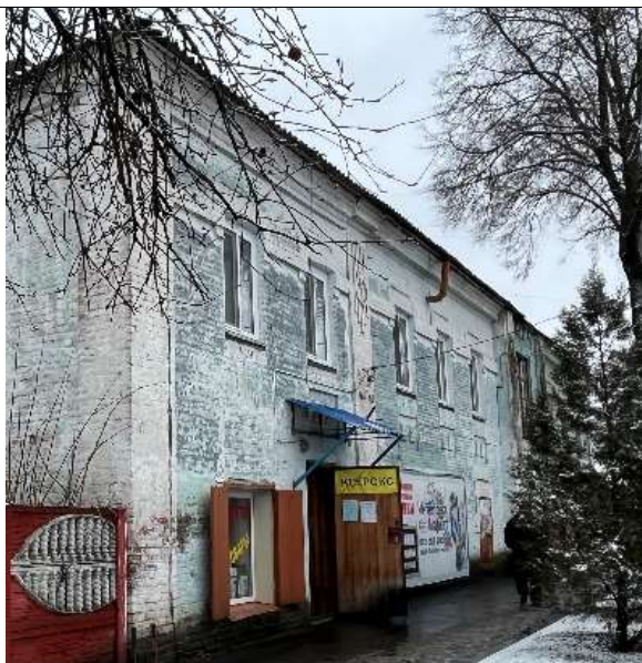
подоконные горизонтальные ниши второго этажа с кирпичным декором из двух квадратов
