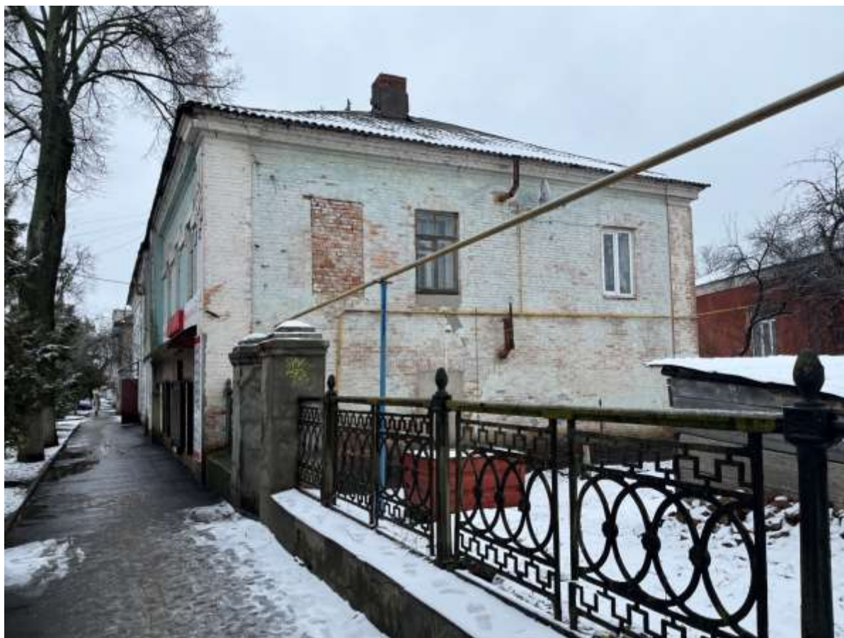
Т.ф. 2. Общий вид бокового фасада со стороны ул. 1 Мая.
