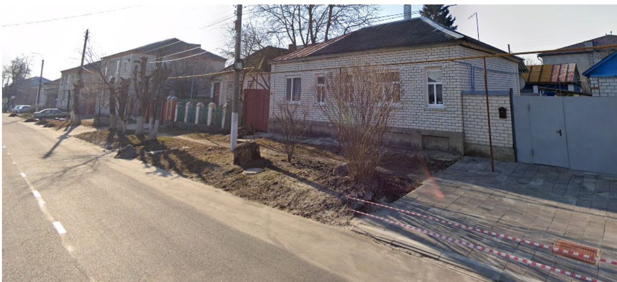
Фотография № 10. Вид с северо-запада на Объект.
