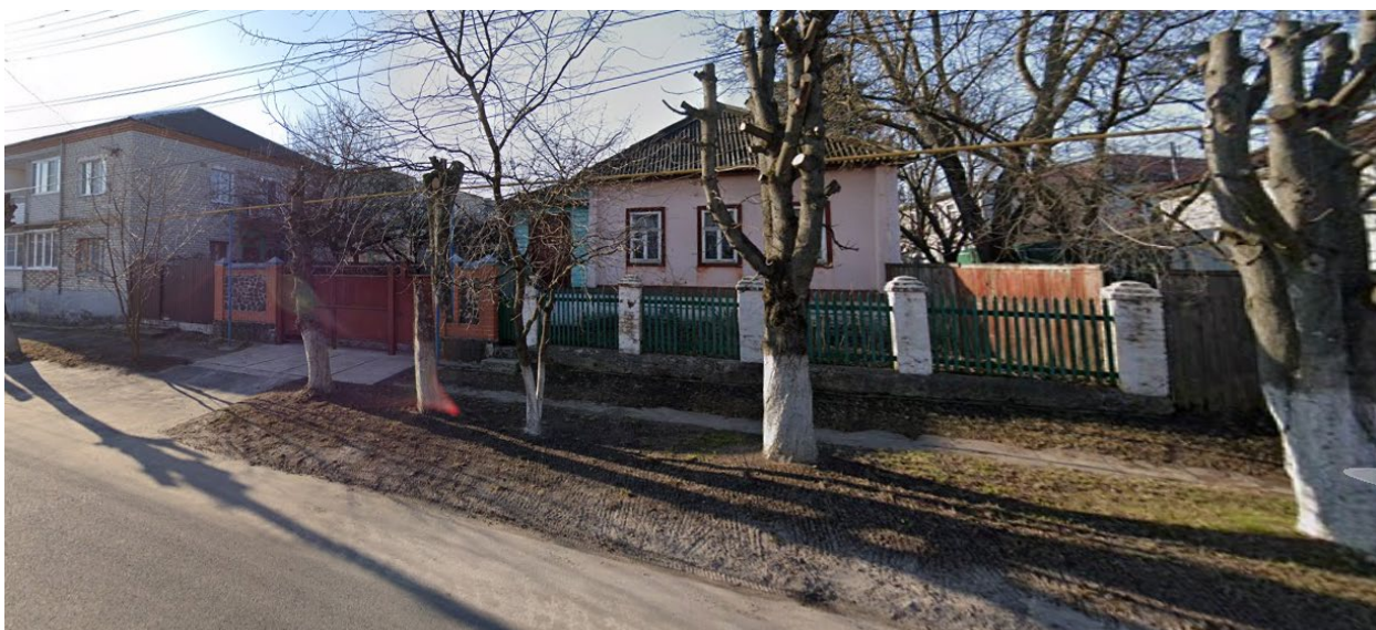
Фотография № 6. Вид с северо-запада на Объект.
