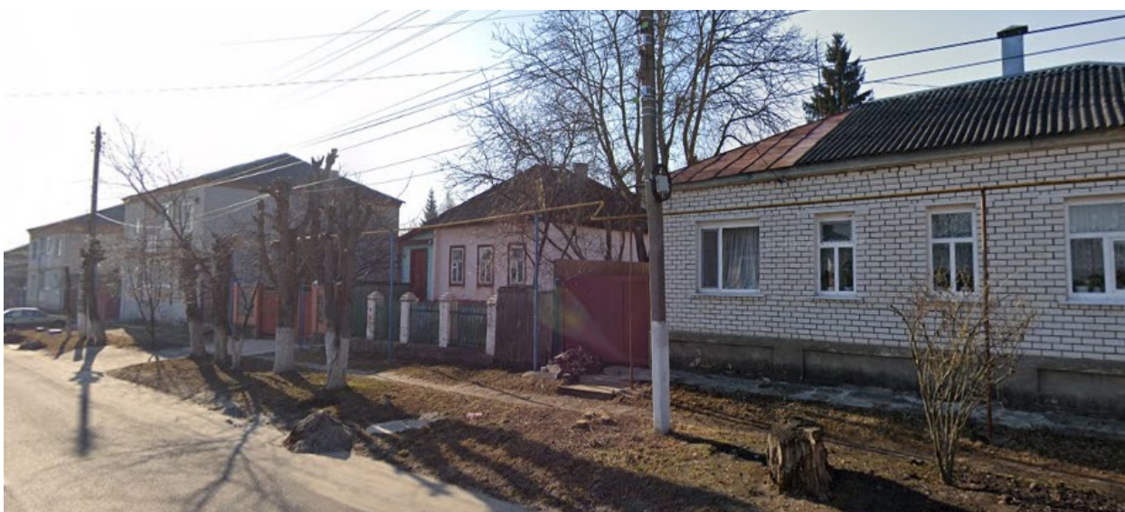
Фотография № 8. Вид с северо-запада на Объект.
