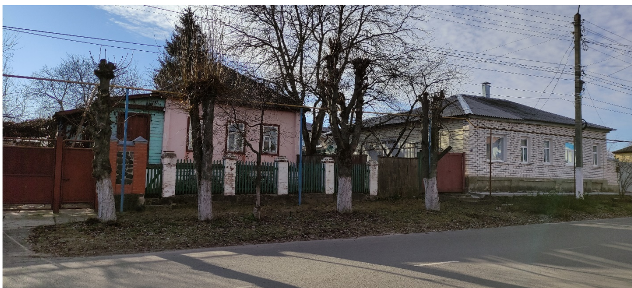
Фотография № 3. Вид с северо-востока на Объект.
