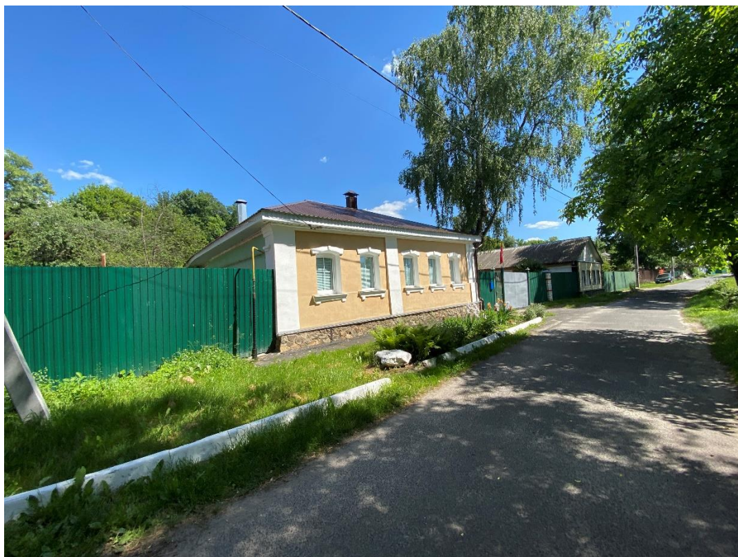
Фотография № 7. Вид с северо-запада на Объект.
