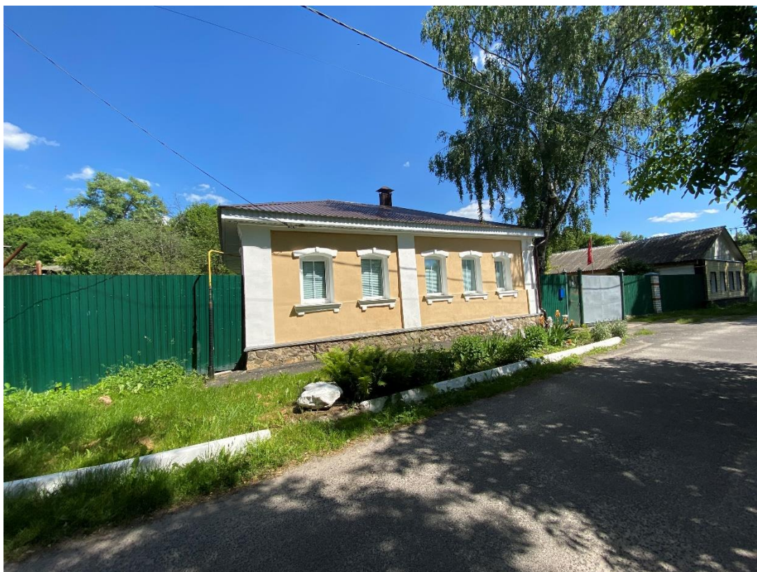
Фотография № 6. Вид с северо-запада на Объект.
