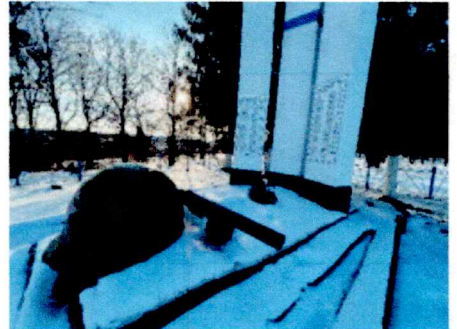
Вид на бетонную площадку
