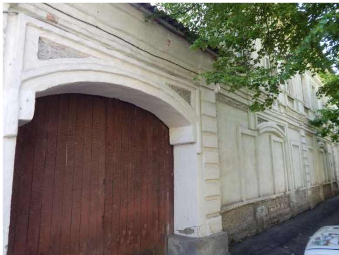
Дворовый фасад. Апрель 2020 г.
