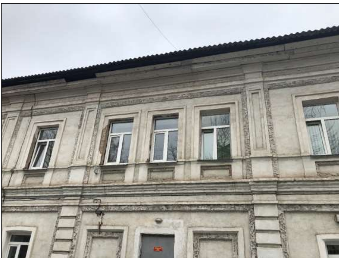
Вид с запада на Объект. Фрагмент западного фасада
