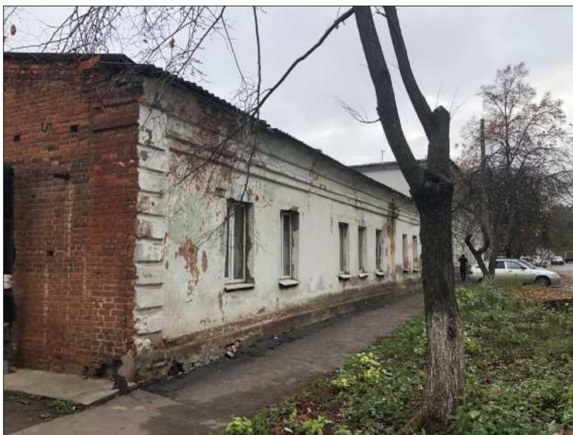
Вид с северо-запада по улице Гайдара на Объект. Западный фасад
