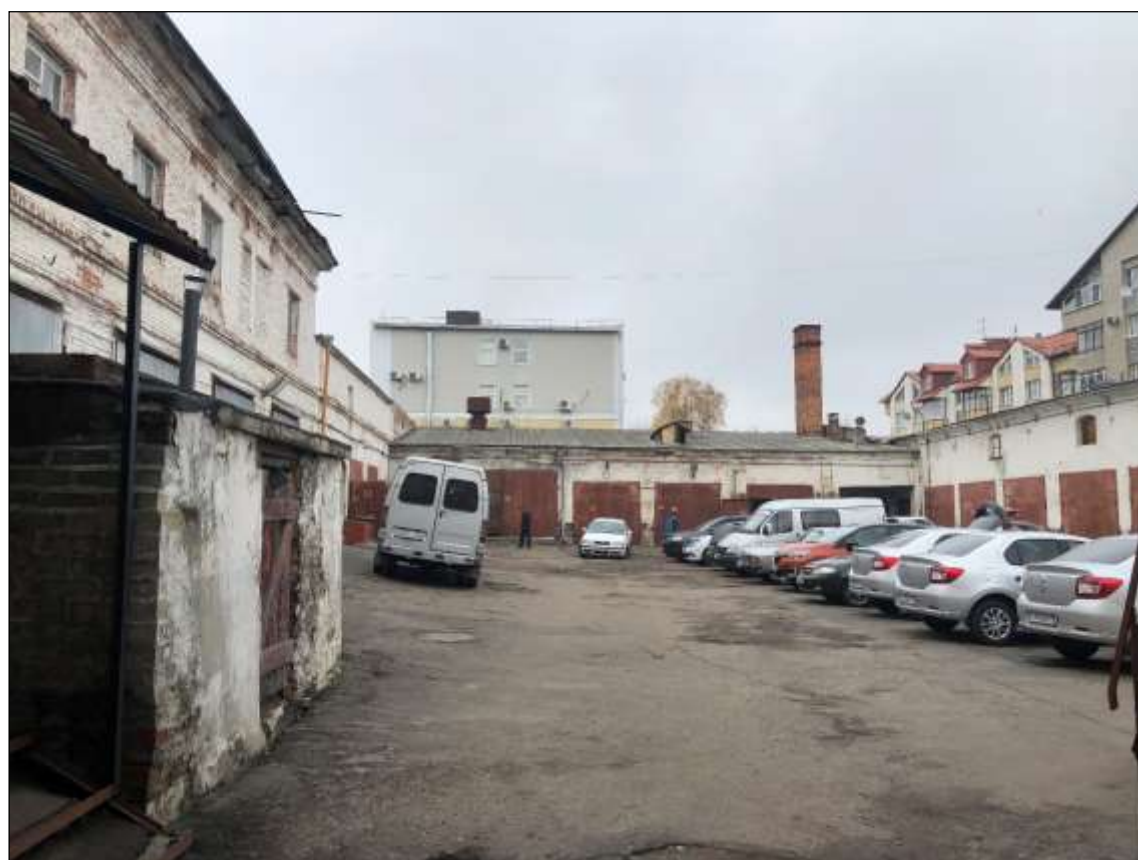
Вид с юга на Объект с дворовой территории. Вид на амбар (сейчас гараж)
