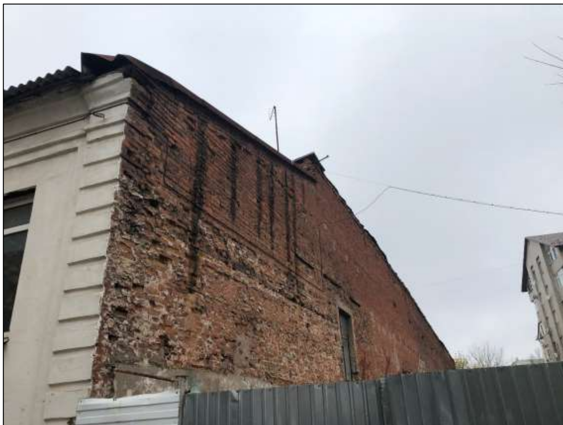
Вид с юго-востока по улице Софьи Перовской на Объект. Восточный фасад.
