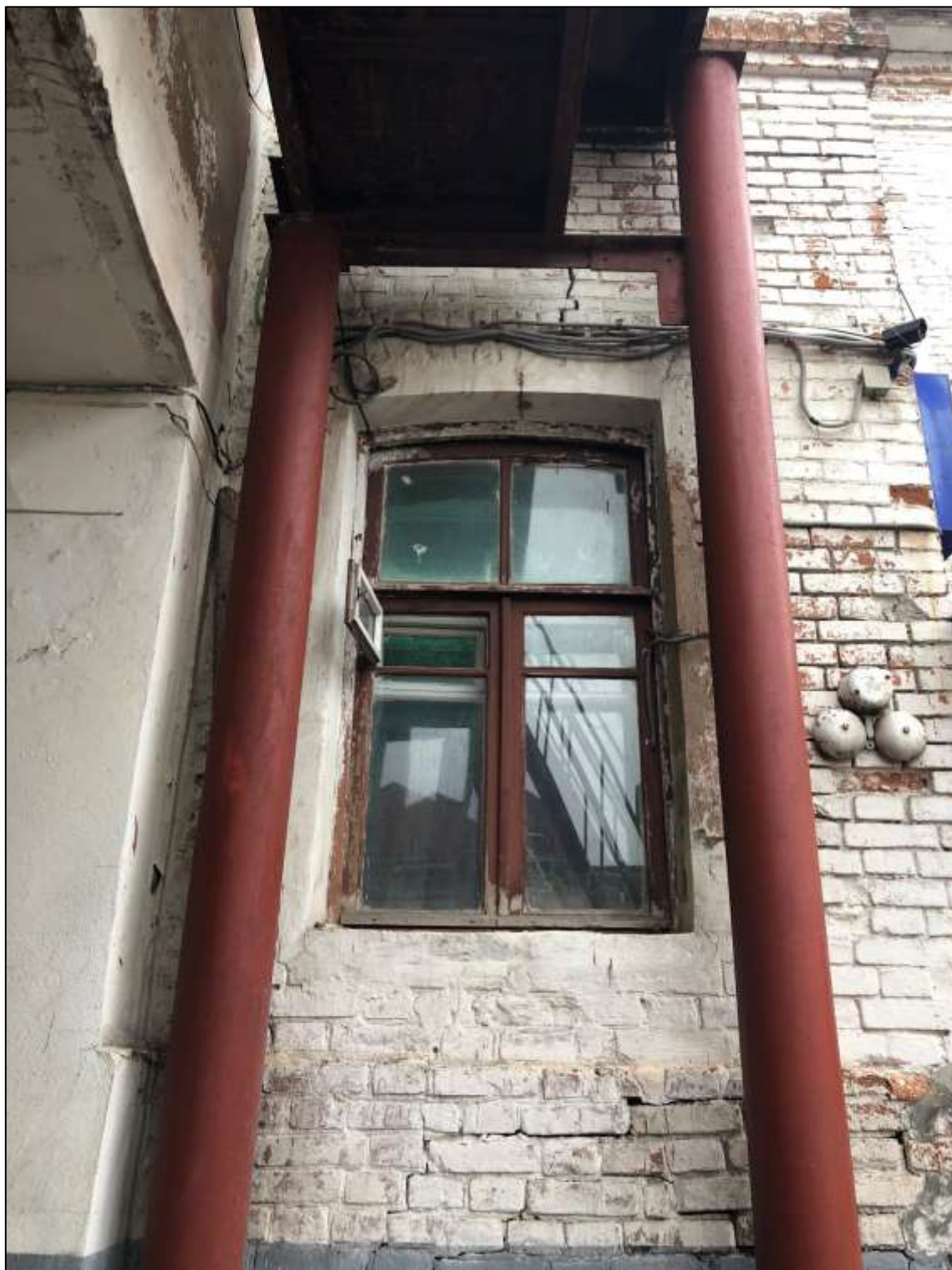
Вид с востока на Объект с дворовой территории. Фрагмент восточного фасада
