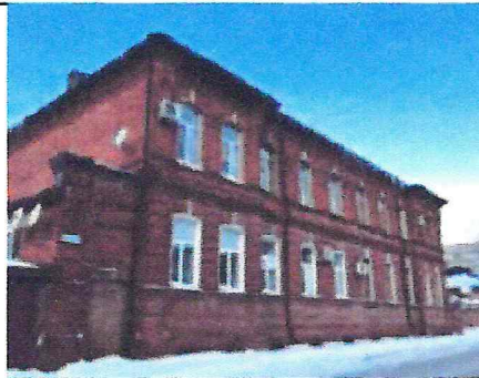
Восточный фасад. Вид с юго-востока
