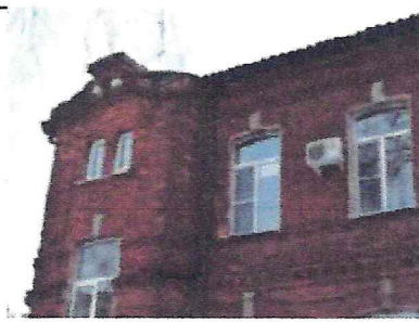
Западный фасад (фрагмент)
