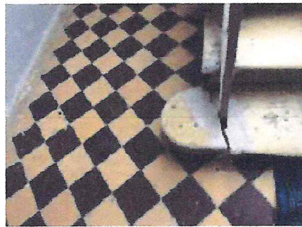
Метлахская плитка (фрагмент)
