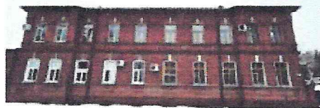
Восточный фасад (фрагмент)
