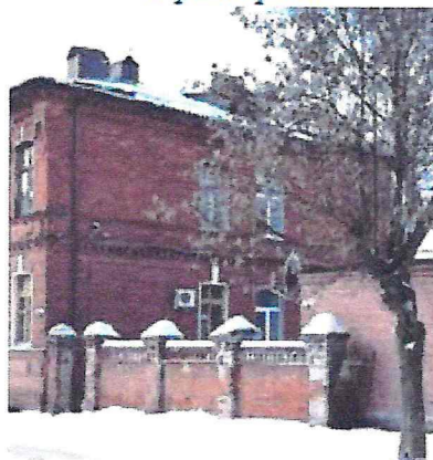
Северный фасад. Вид с северо-востока
