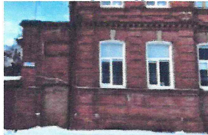
Восточный фасад (фрагмент)
