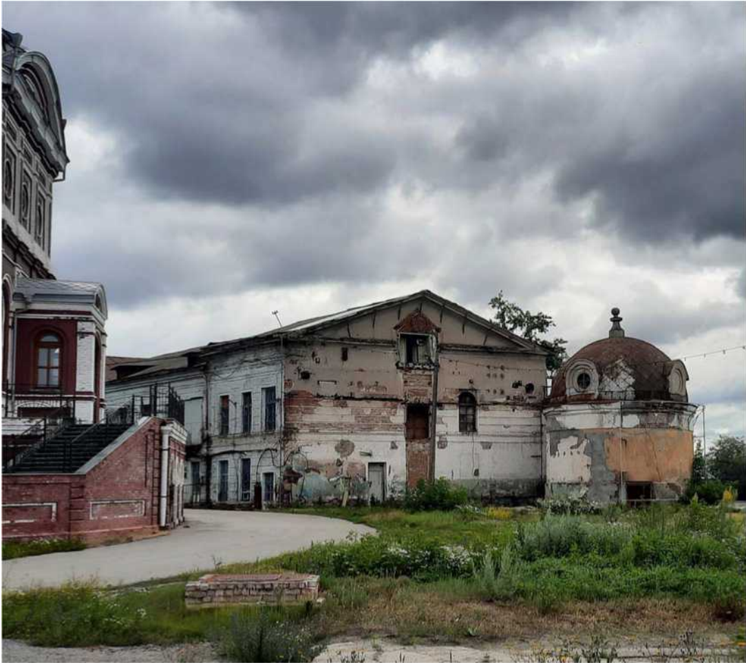
Общий вид торцевого фасада.
