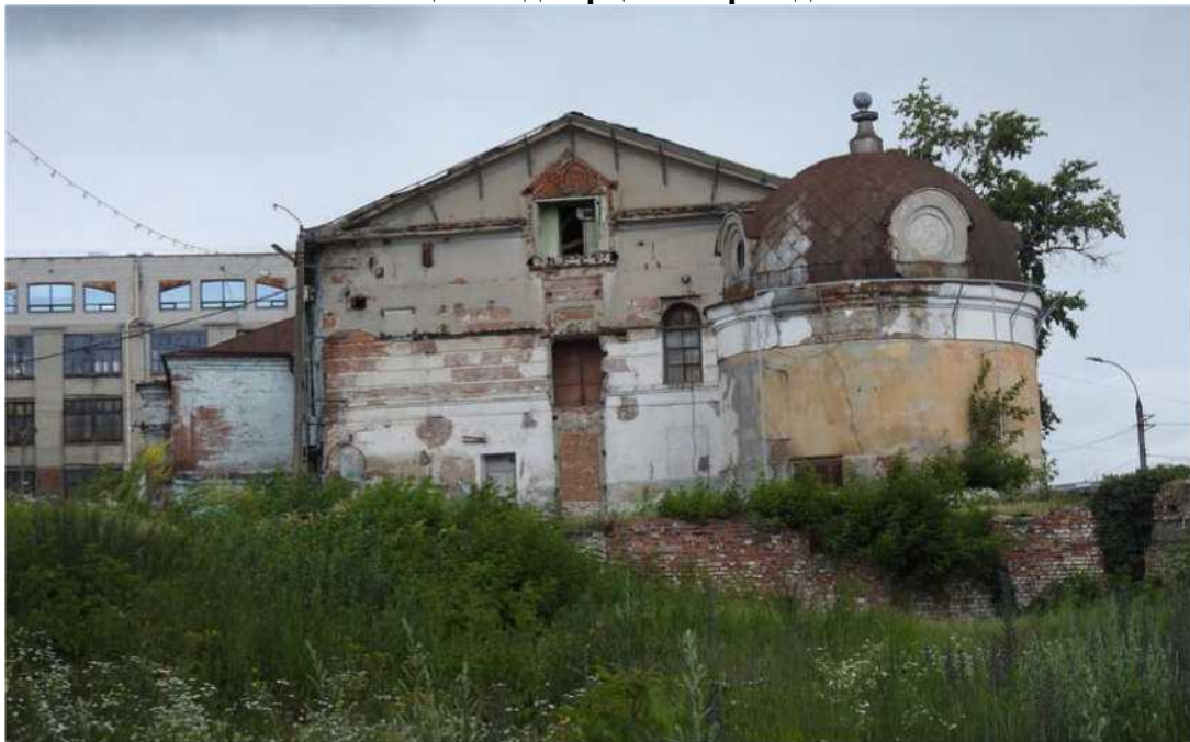
Общий вид торцевого фасада.
