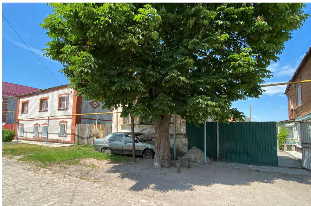
Фотография № 4. Вид с юго-востока на Объект.
