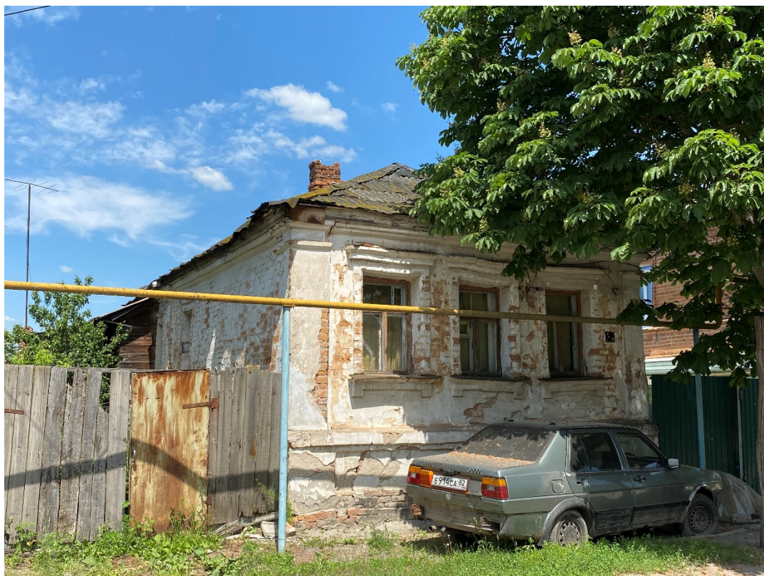
Фотография № 7. Вид с юго-запада на Объект.
