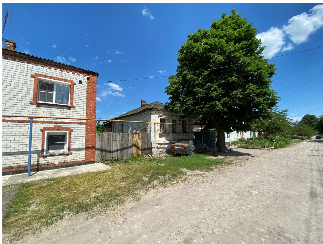
Фотография № 10. Вид с юго-запада на Объект.
