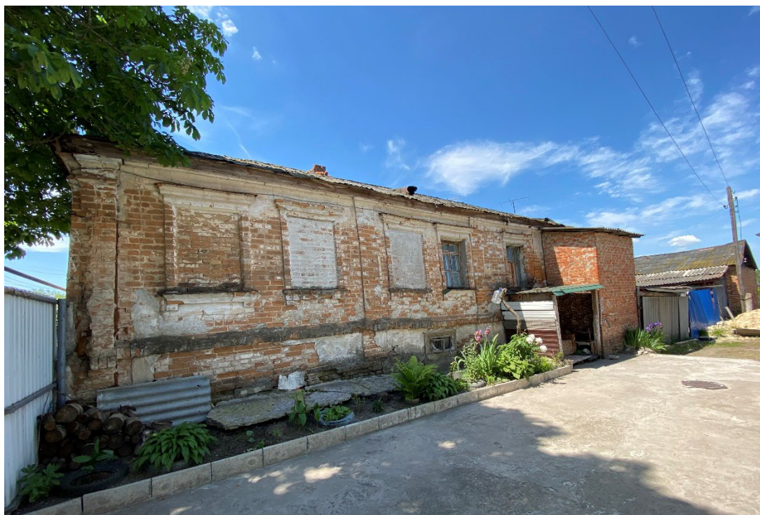
Фотография № 3. Вид с юго-востока на Объект.
