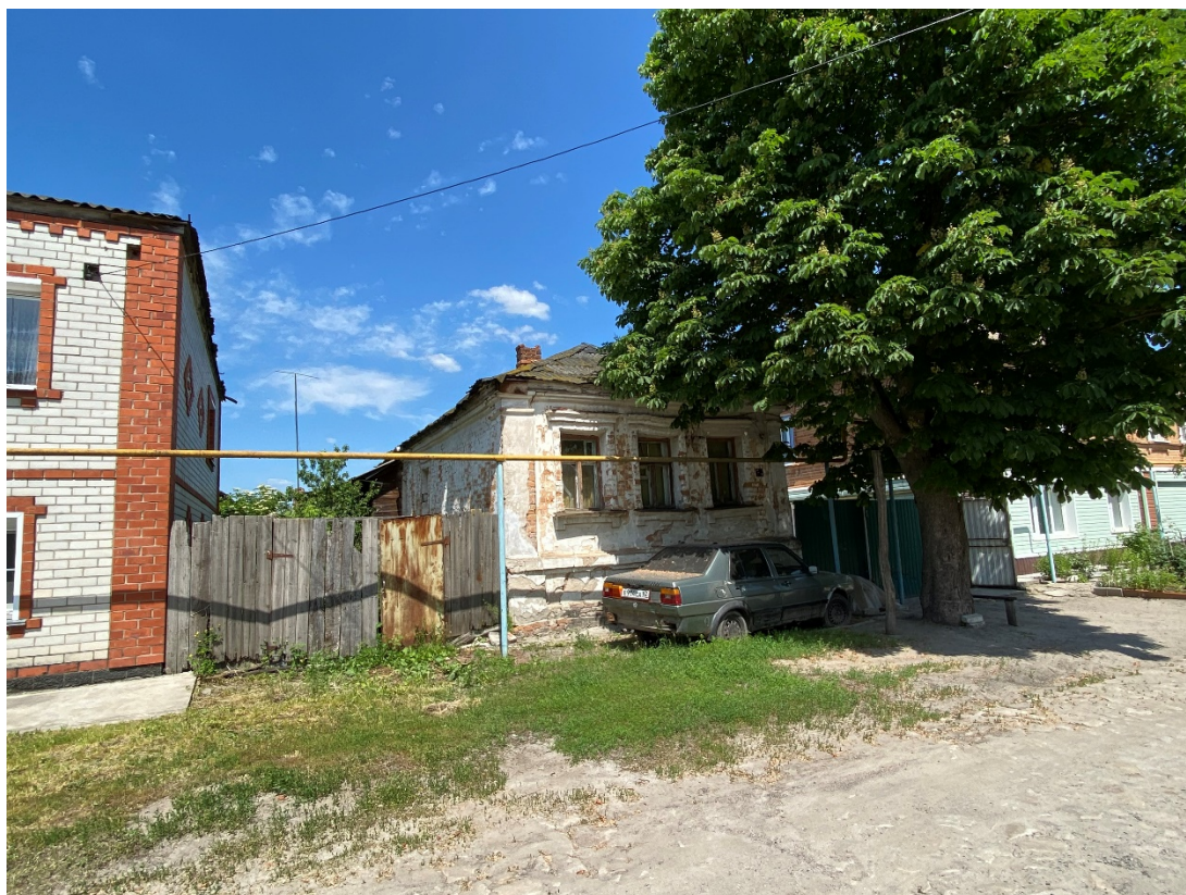
Фотография № 9. Вид с юго-запада на Объект.
