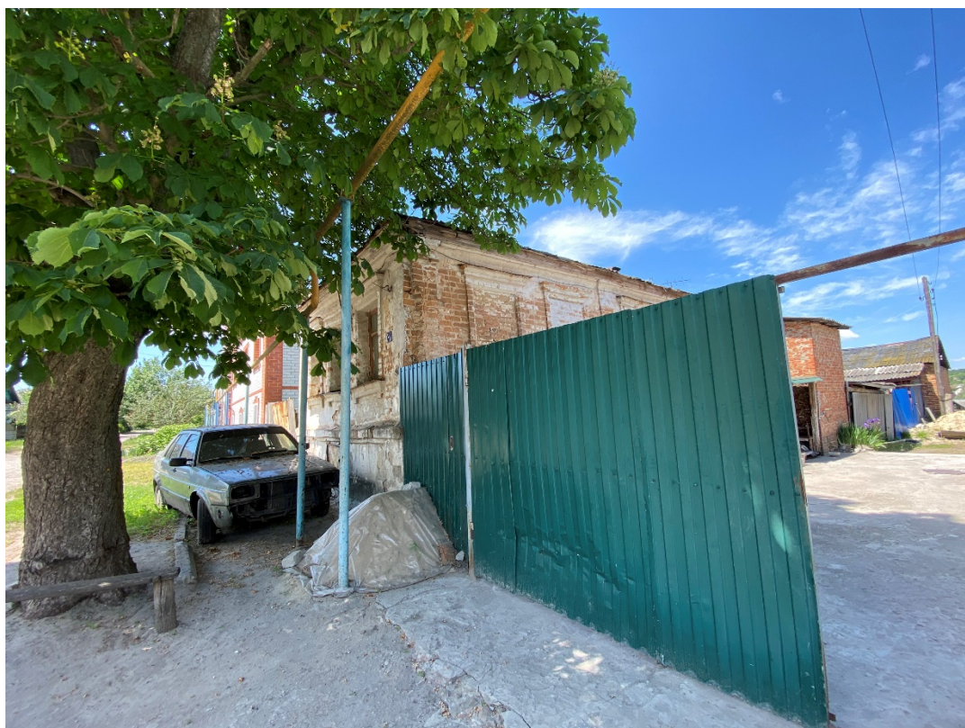
Фотография № 2. Вид с юго-востока на Объект.
