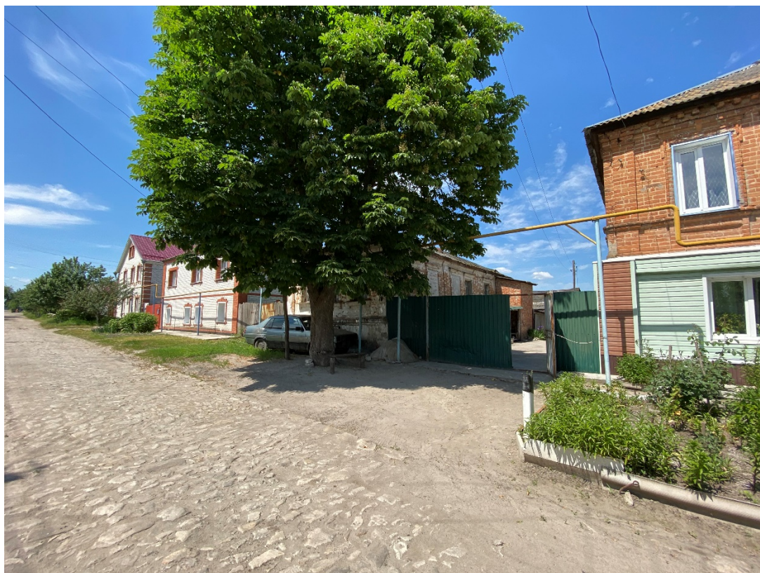
Фотография № 1. Вид с юго-востока на Объект.
