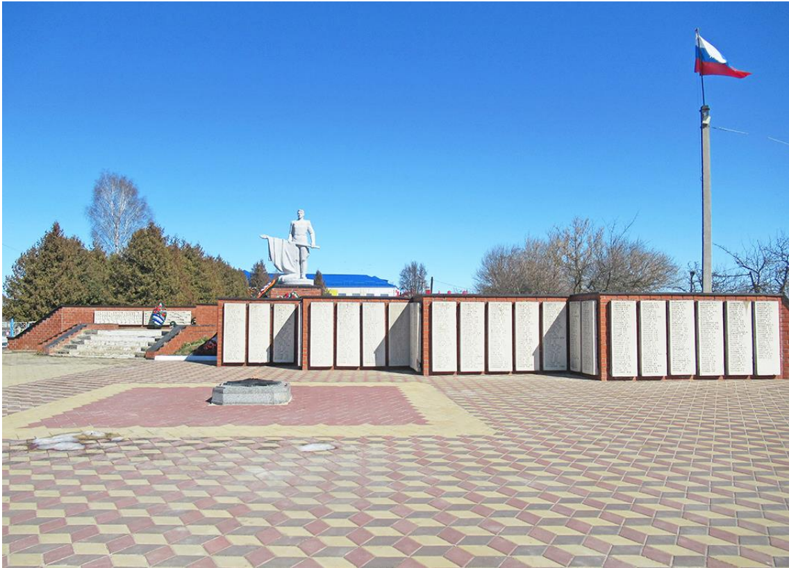
Главный вид на объект культурного наследия с юго-запада. 2022г.
