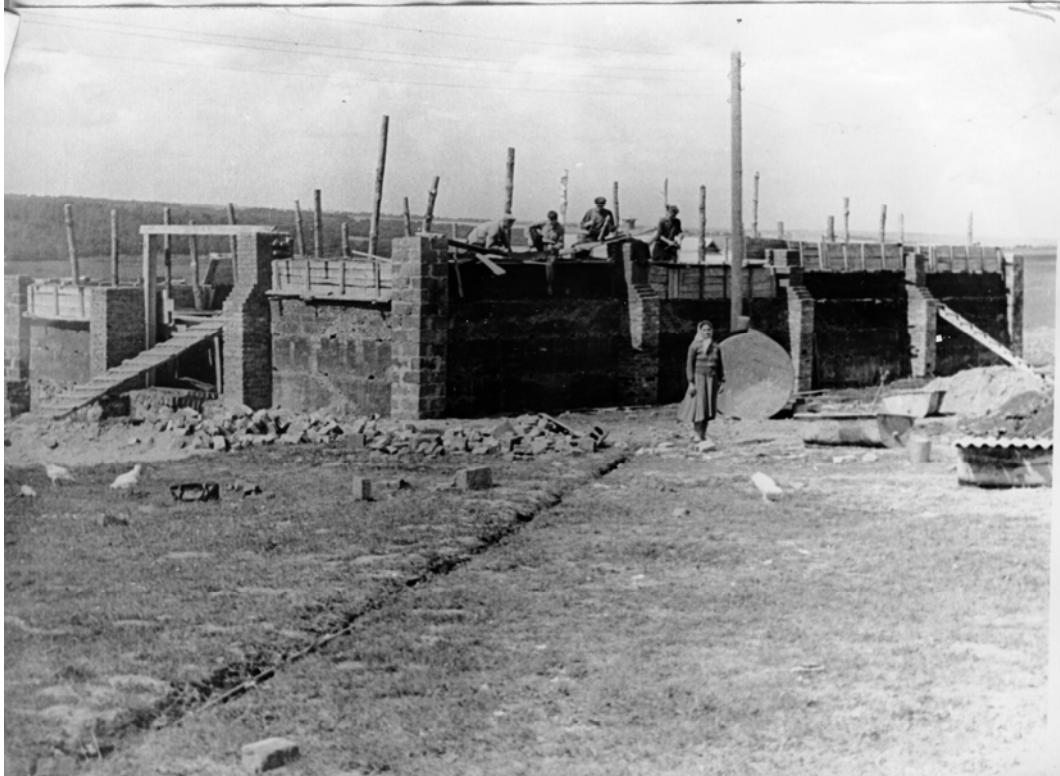
СТРОИТЕЛЬСТВО ЗЕРНОХРАНИЛИЩА НА 300 ТОНН.
