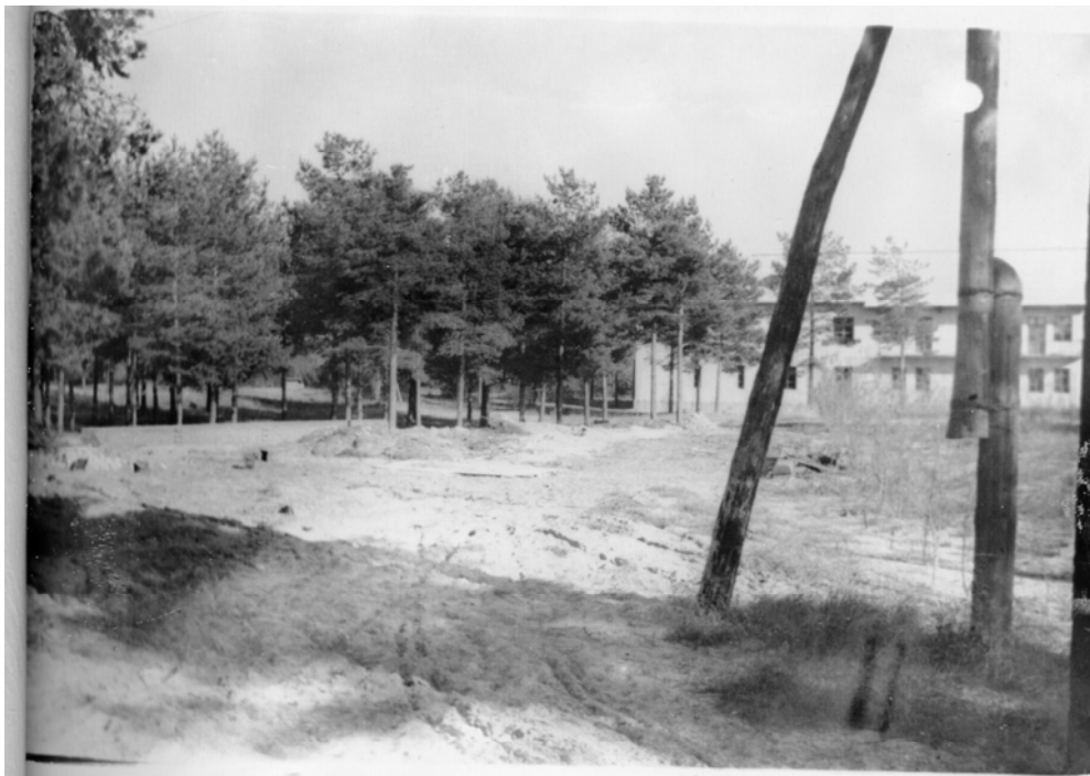
МЕСТО ОТВЕДЕННОЕ ПОД СТРОИТЕЛЬСТВО БАНИ.
