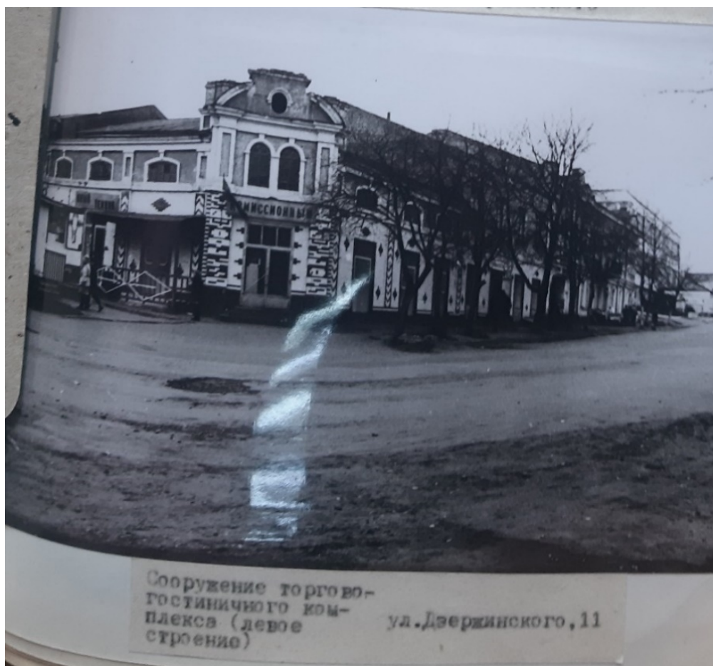
Сооружение торгово-гостиничного комплекса (левое строение), ул. Дзержинского, д. 11, середина XIX в. Здание Объекта на фотографии в «Проекте охранных зон г. Рыльска Курской обл.» 1990 года.
