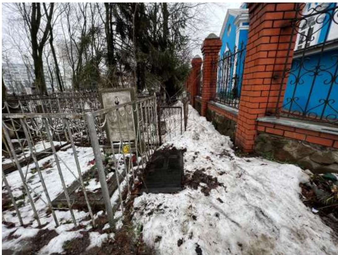
Фотография № 1. Вид с юго-запада на Объект.
