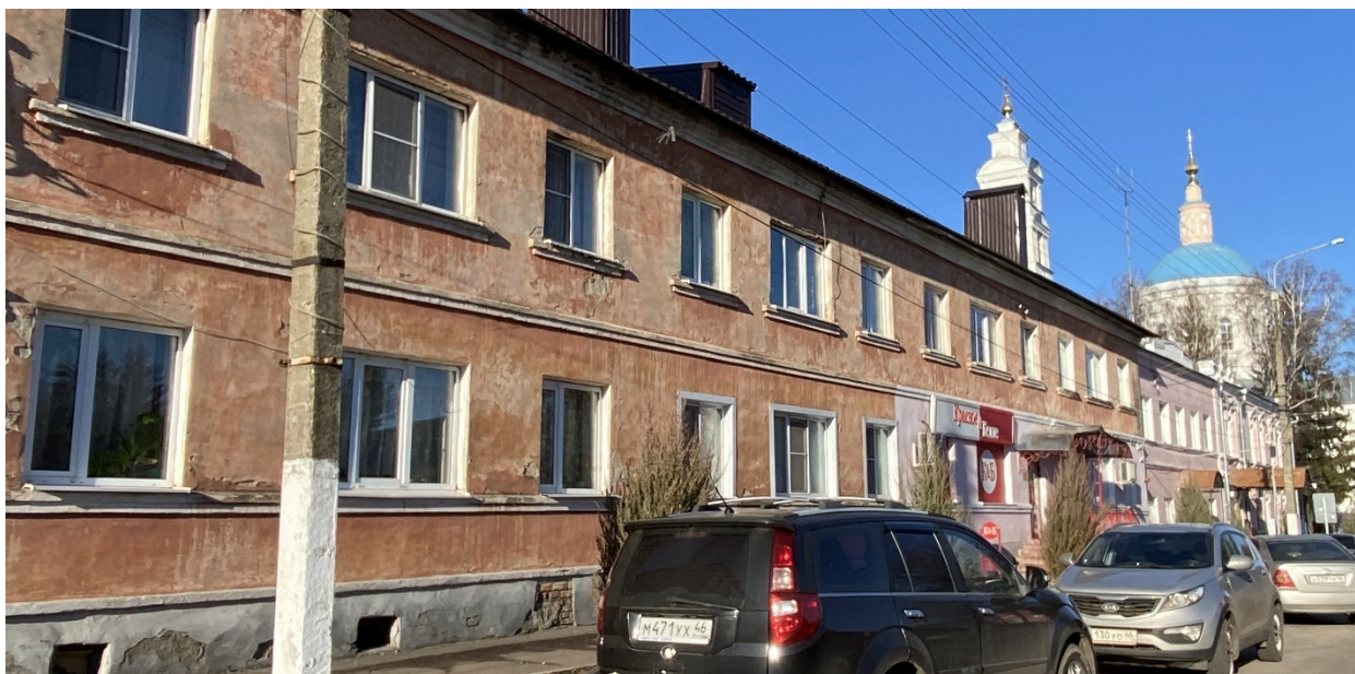
Фотография № 1. Вид с юго-востока на Объект.
