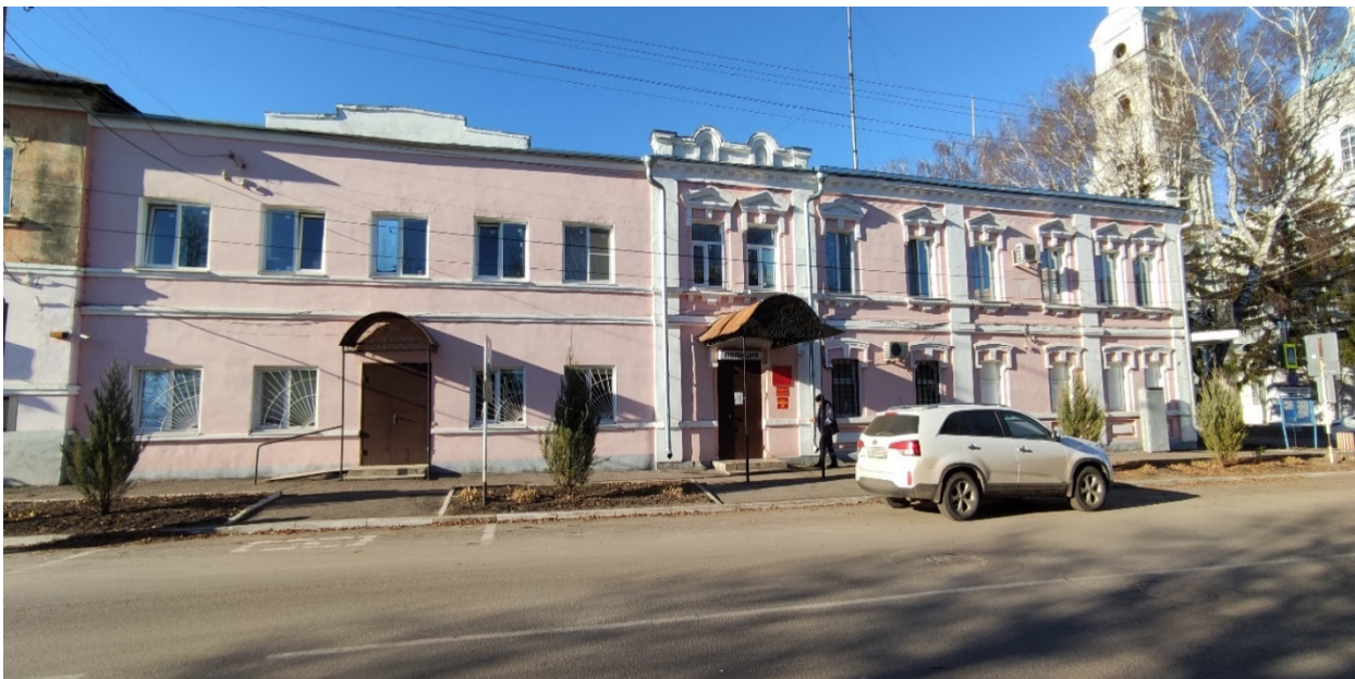
Фотография № 3. Вид с юго-востока на Объект.
