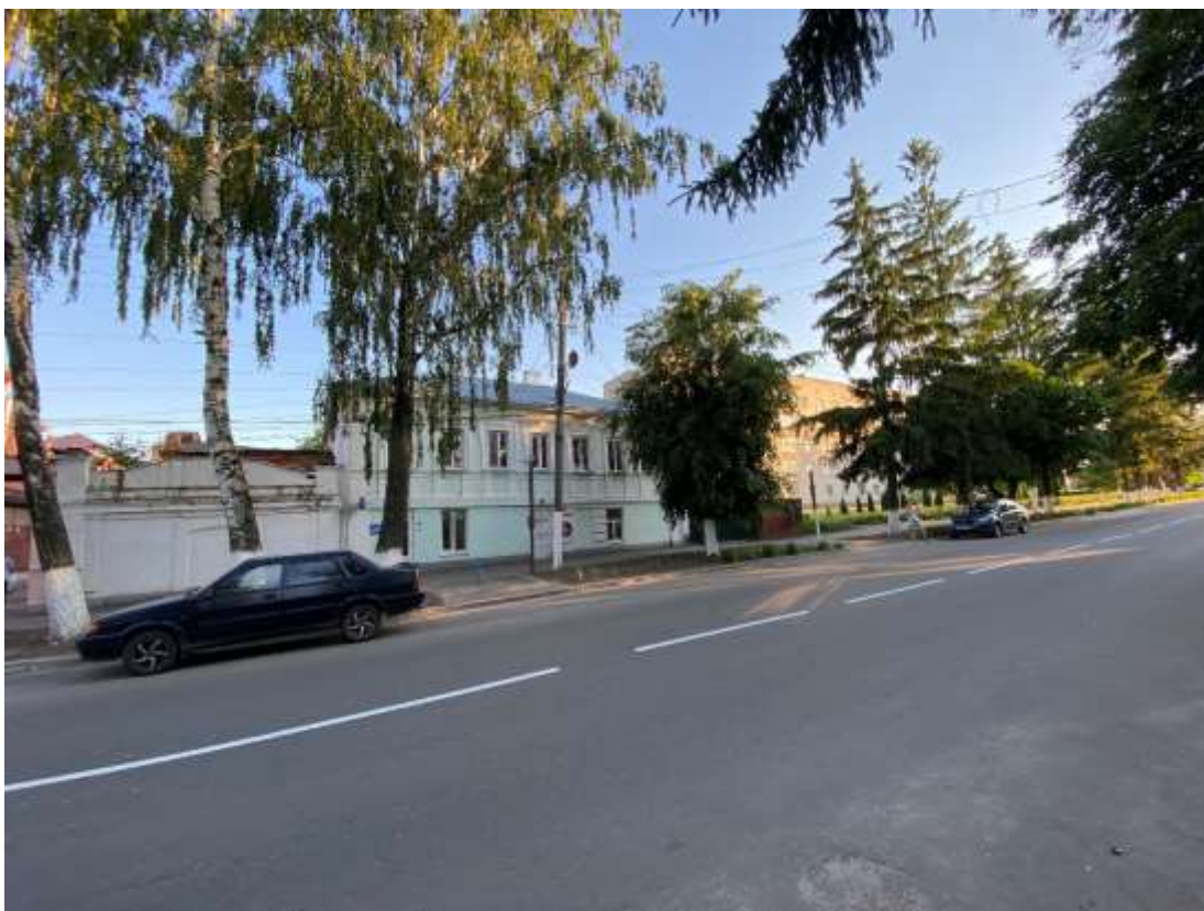
Фотография № 3. Вид с северо-востока на Объект.
