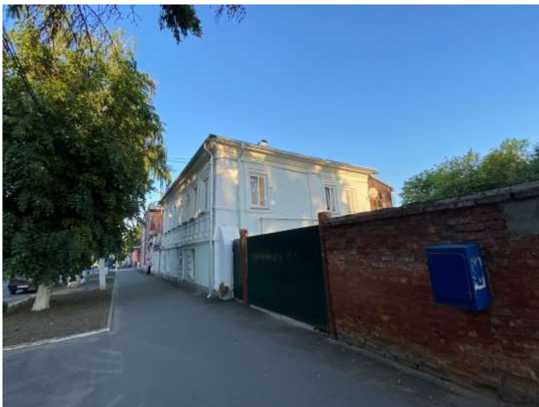
Фотография № 8. Вид с запада на Объект.
