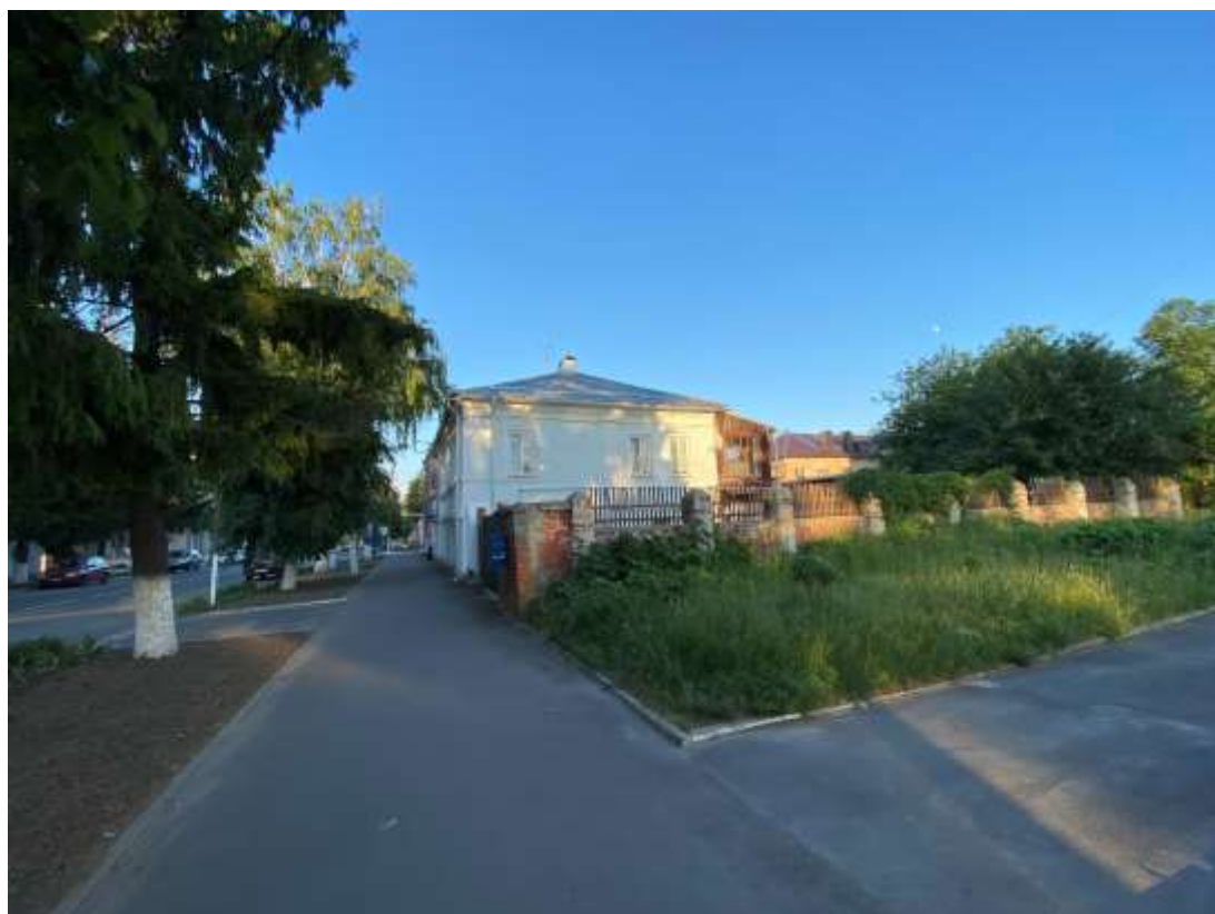
Фотография № 10. Вид с запада на Объект.
