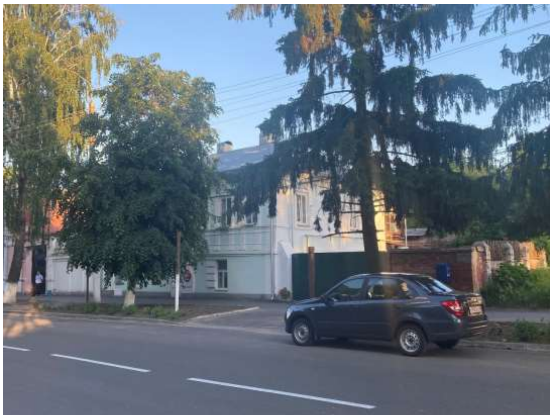
Фотография № 9. Вид с северо-запада на Объект.
