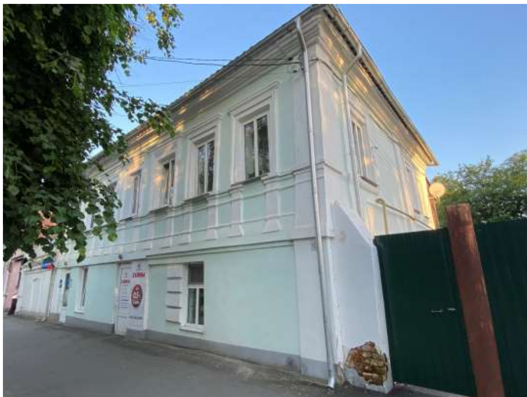
Фотография № 6. Вид с северо-запада на Объект.
