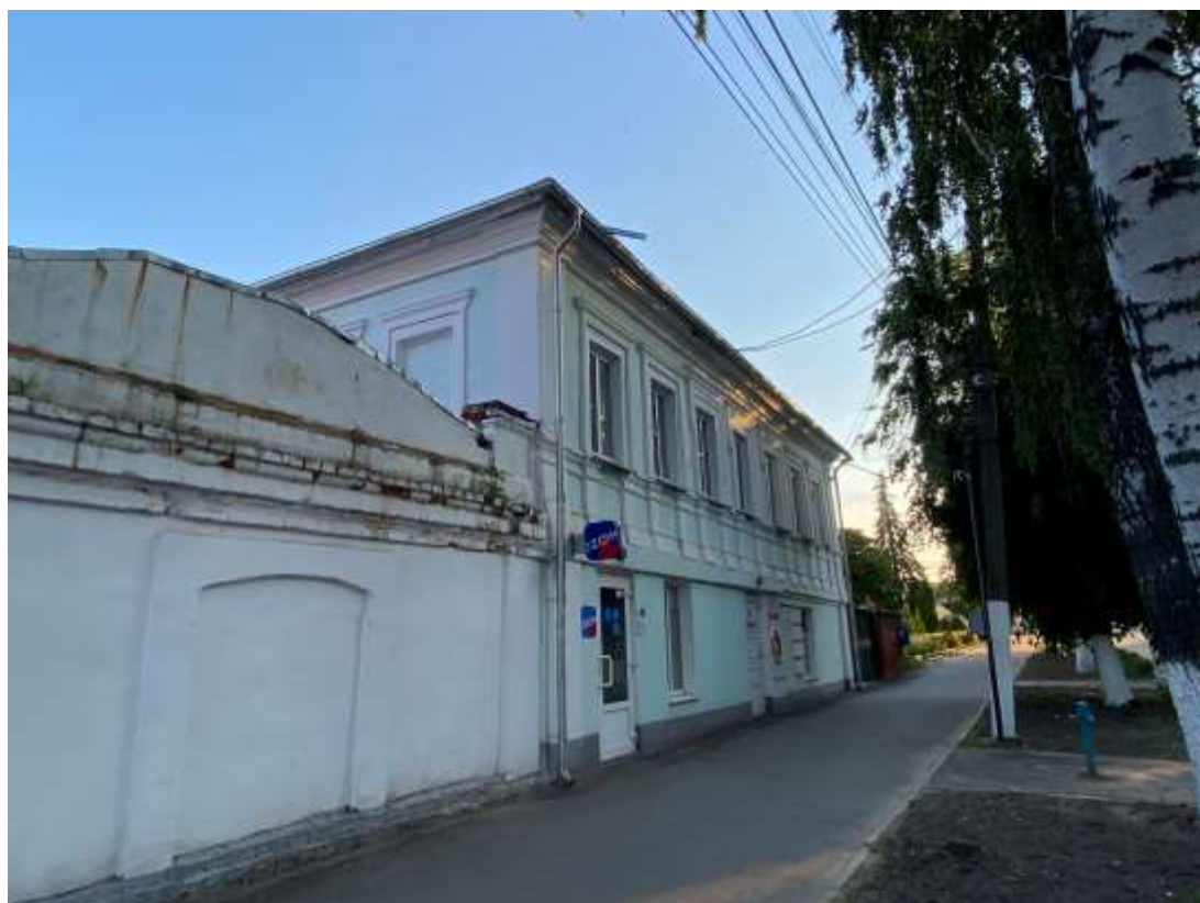
Фотография № 2. Вид с северо-востока на Объект.
