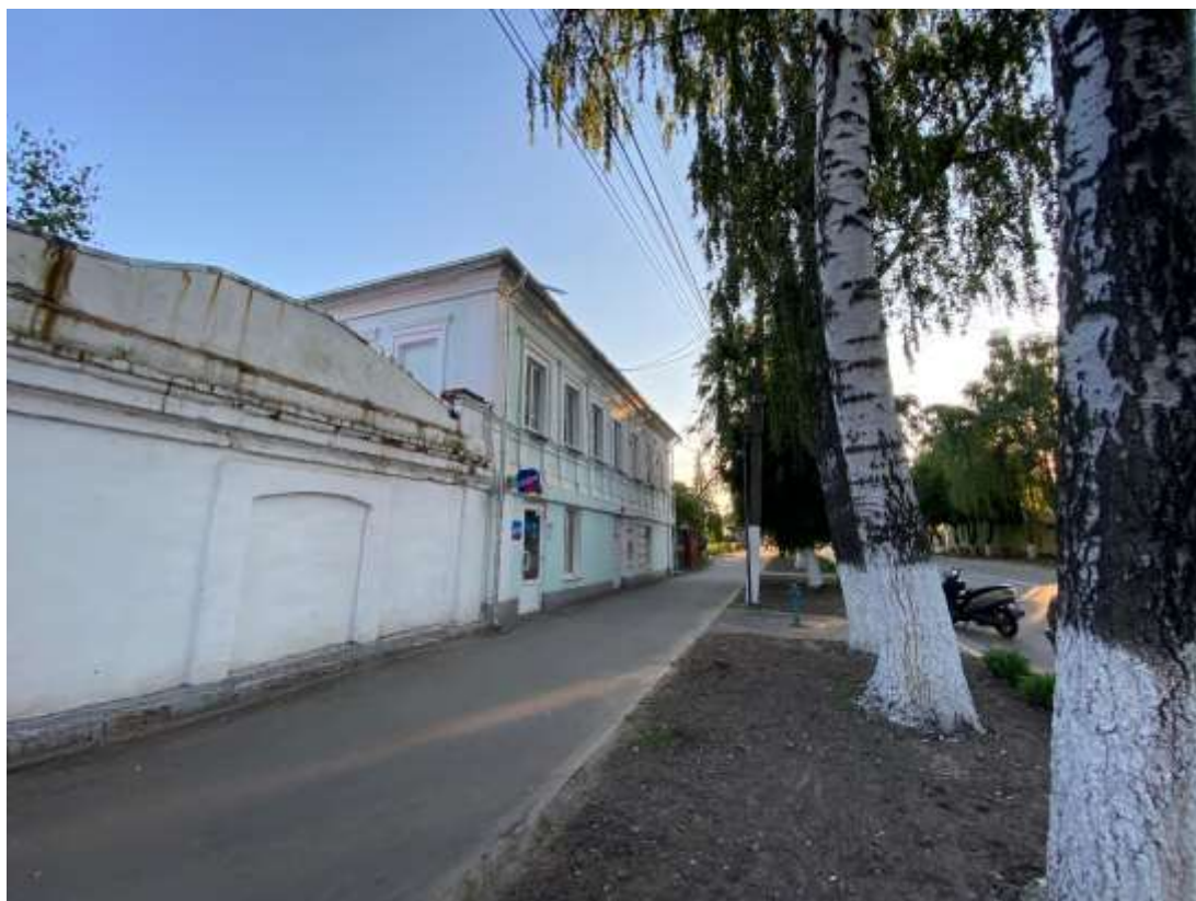
Фотография № 1. Вид с северо-востока на Объект.
