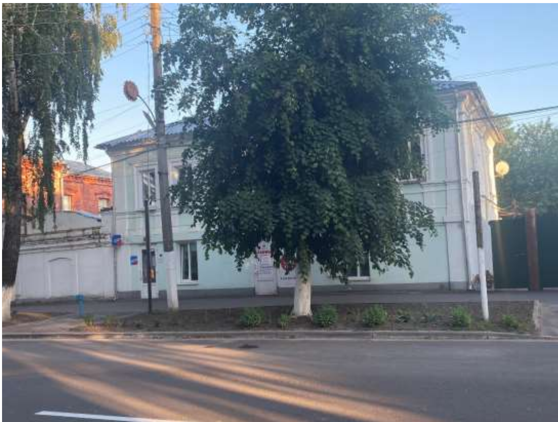
Фотография № 5. Вид с северо-запада на Объект.
