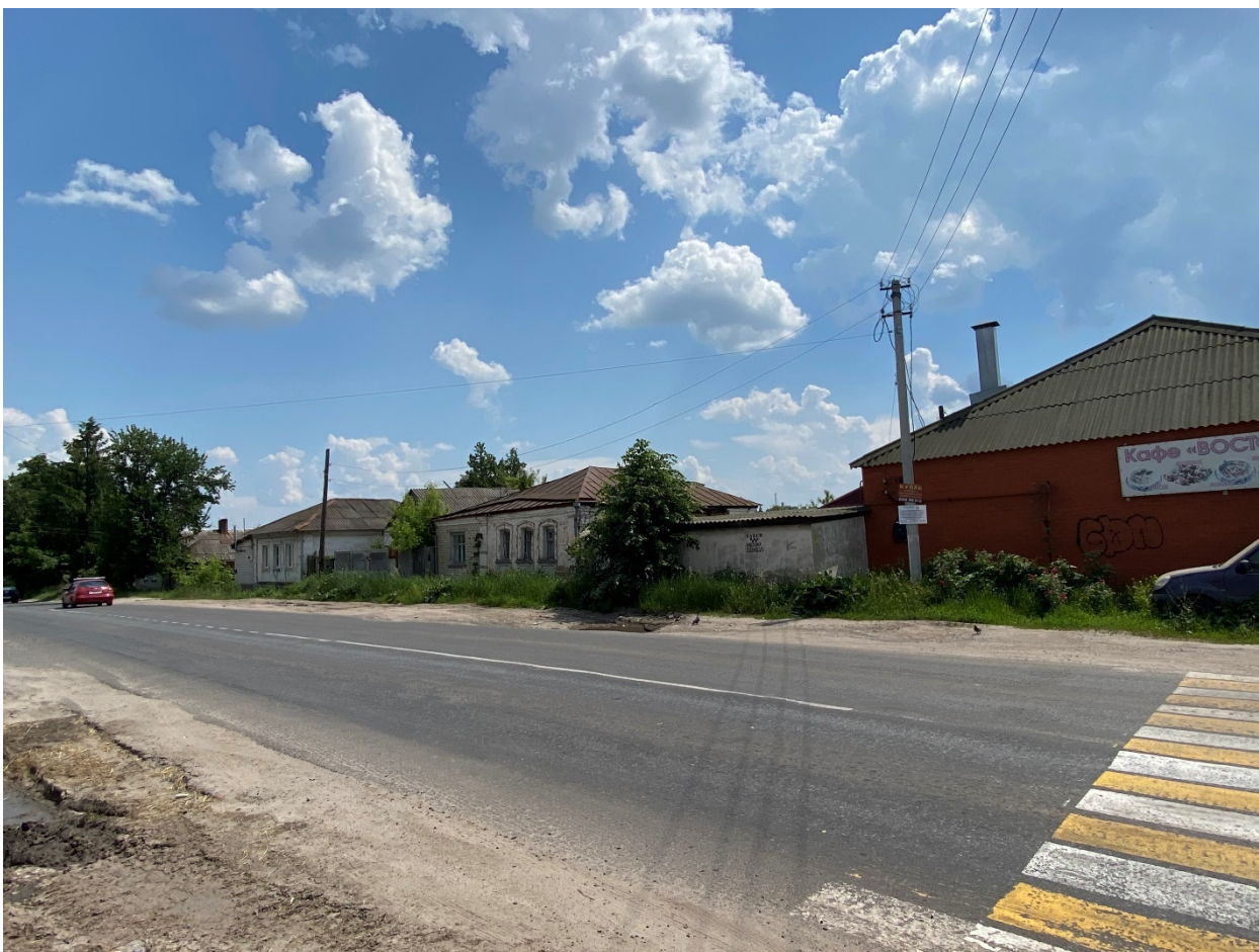
Фотография № 11. Вид с северо-запада на Объект.
