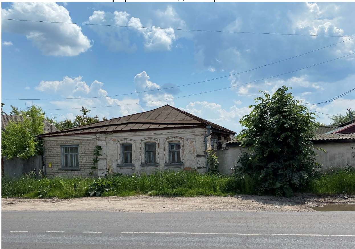
Фотография № 8. Вид с северо-запада на Объект.
