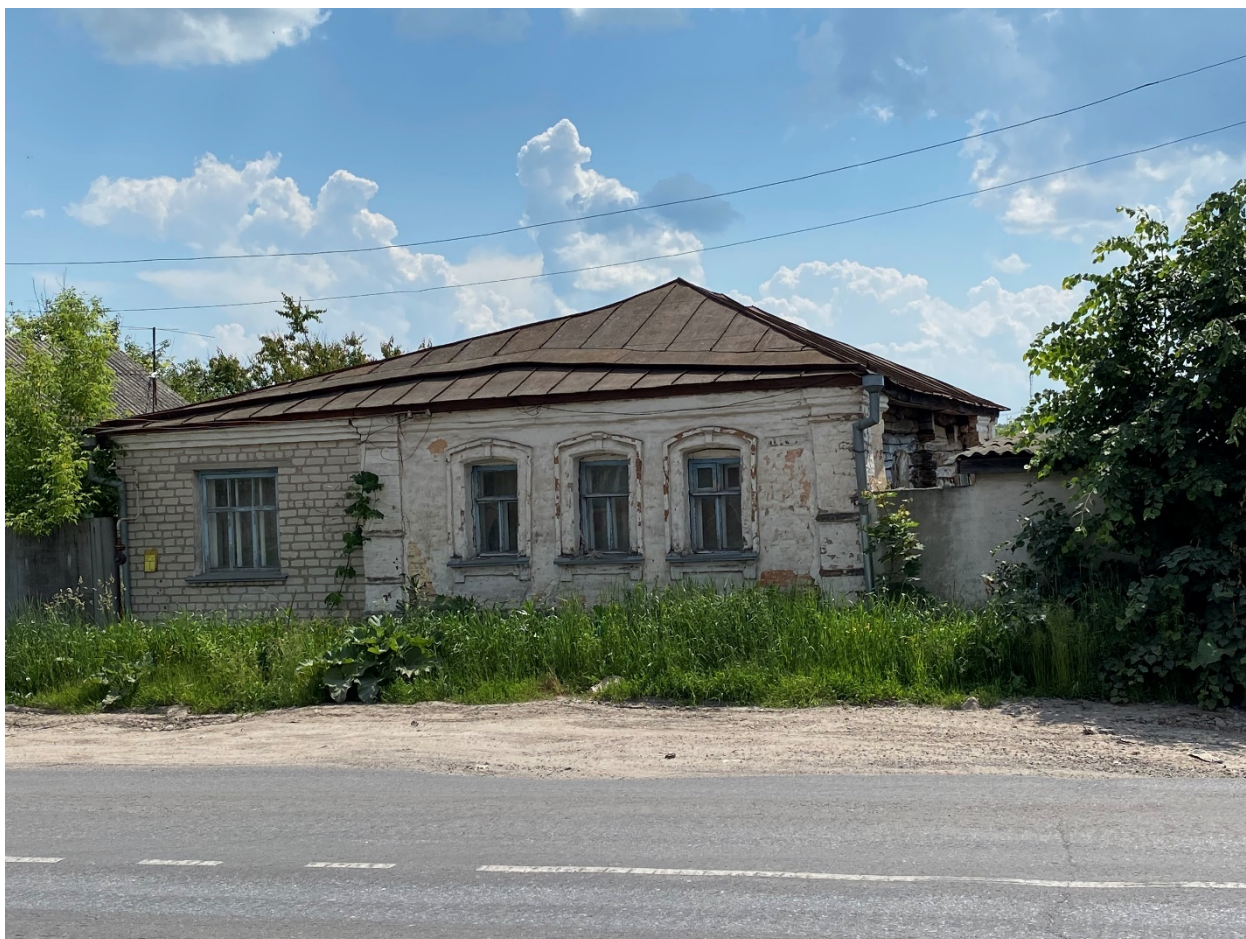
Фотография № 9. Вид с северо-запада на Объект.
