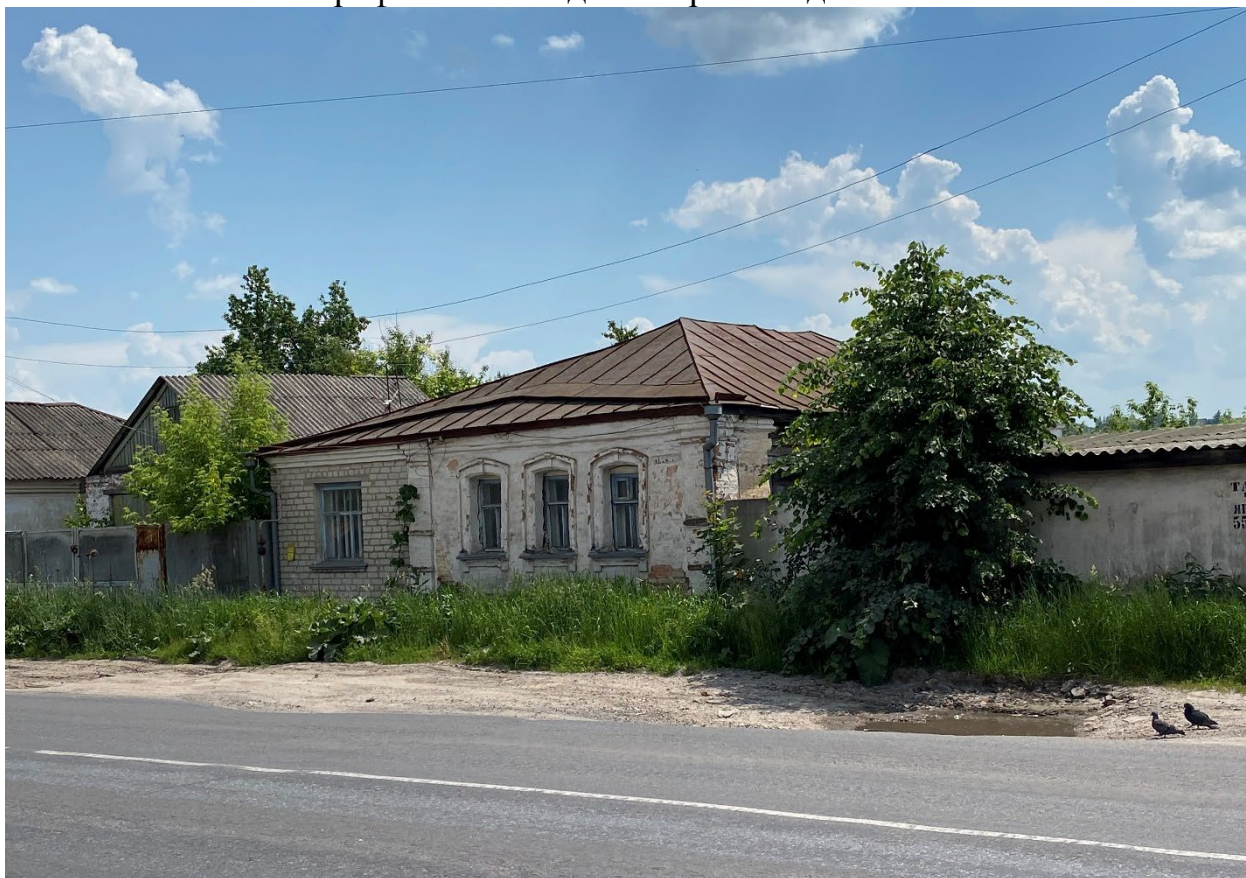
Фотография № 10. Вид с северо-запада на Объект.
