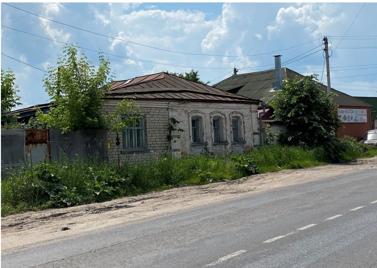
Фотография № 3. Вид с северо-востока на Объект.
