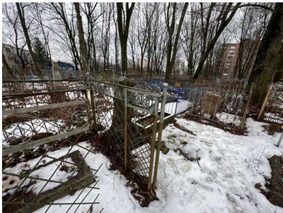
Фотография № 7. Вид с севера на Объект.
