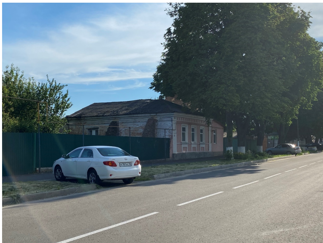
Фотография № 2. Вид с северо-востока на Объект.
