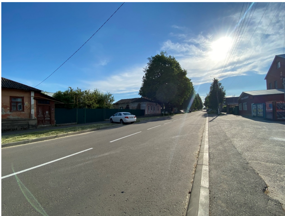
Фотография № 1. Вид с востока на Объект.
