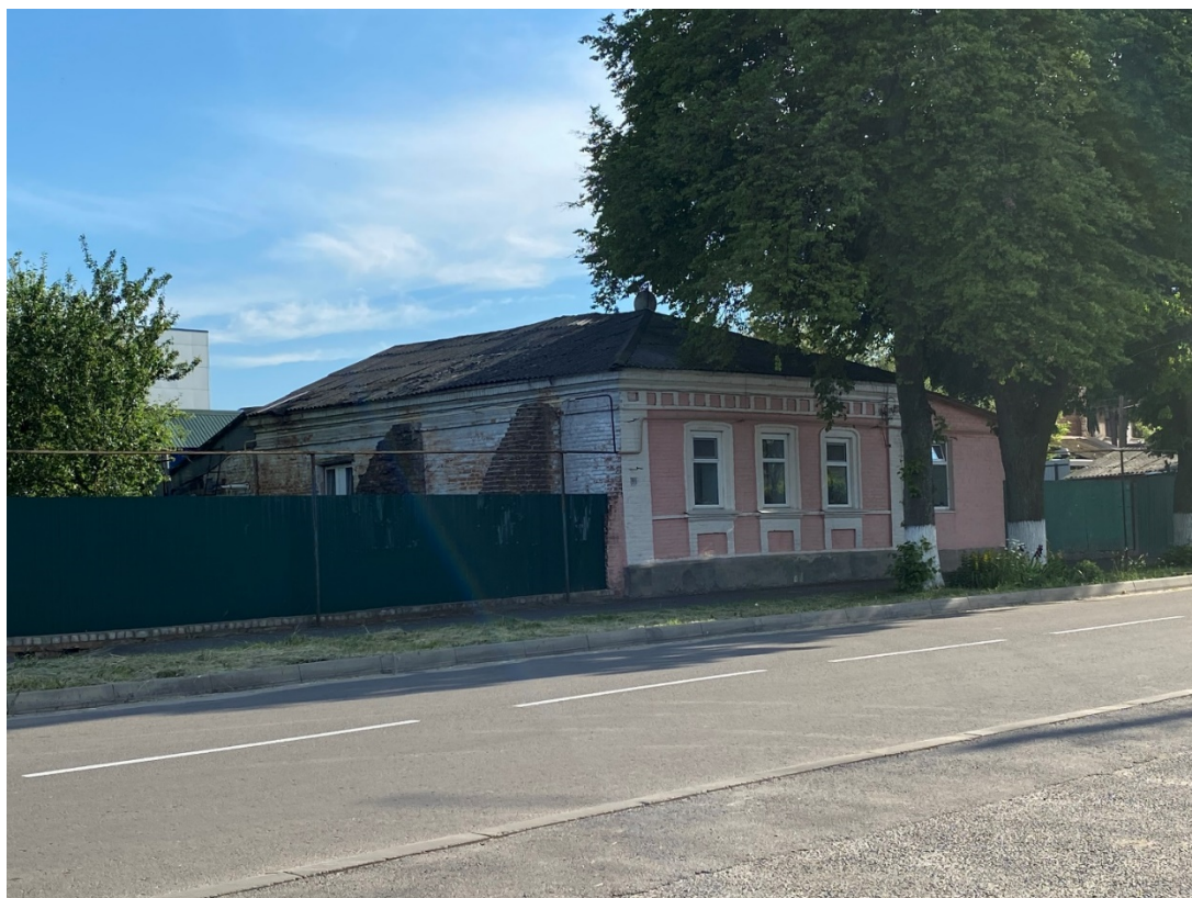
Фотография № 3. Вид с северо-востока на Объект.
