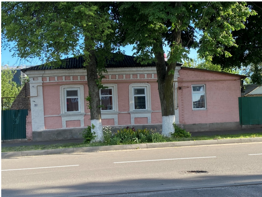
Фотография № 5. Вид с севера на Объект.
