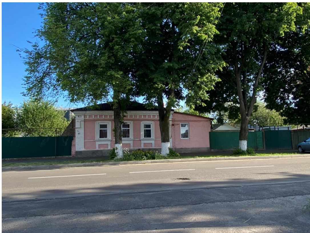
Фотография № 4. Вид с севера на Объект.
