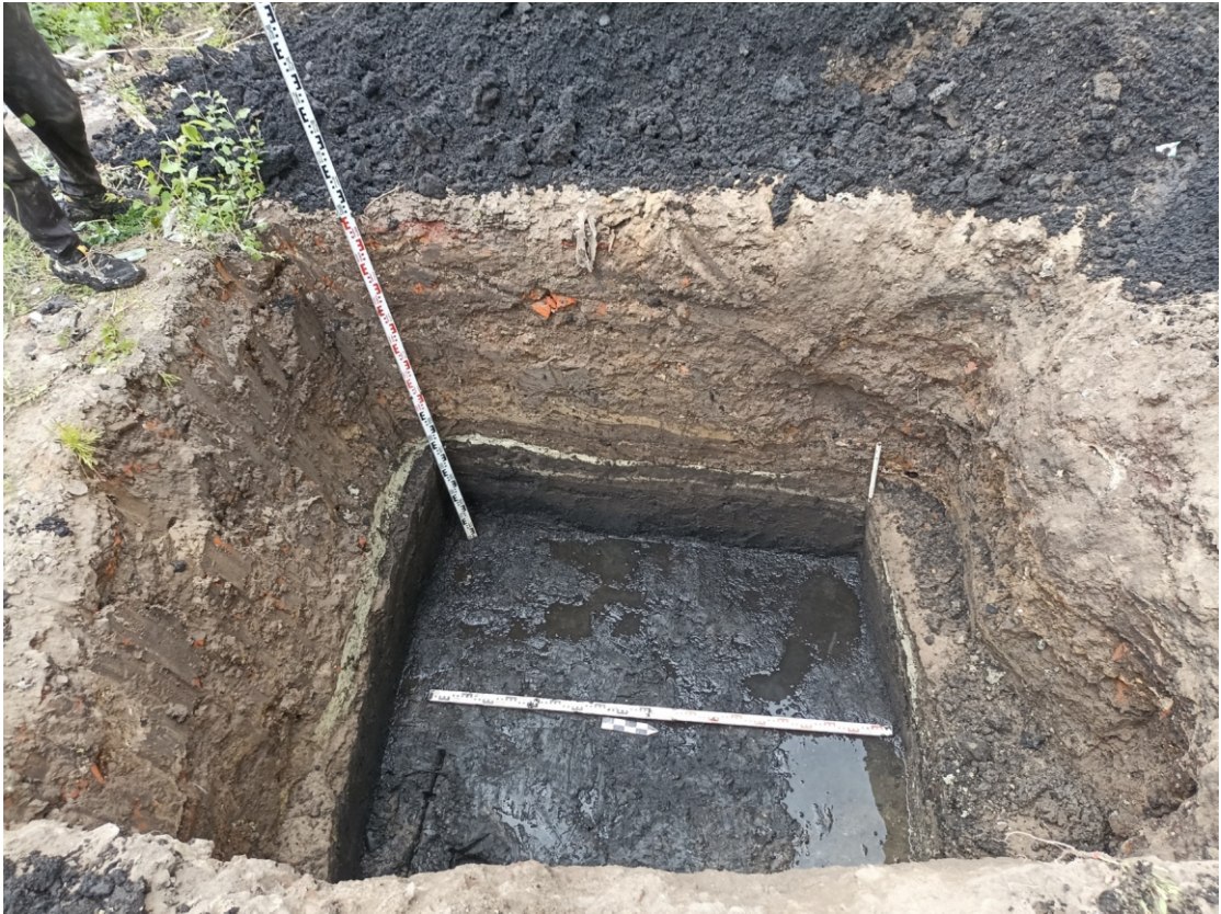
Рис. 33. Работы в границах земельных участков с кадастровыми номерами: 46:29:102288:291, 46:29:102288:292, 46:29:102288:52, в рамках проекта: «Реконструкция здания, расположенного по адресу: г. Курск, ул. Верхняя Луговая, д. 6А». 2024 г. Шурф 1. Пласт 2. Западный борт. Вид с В.
