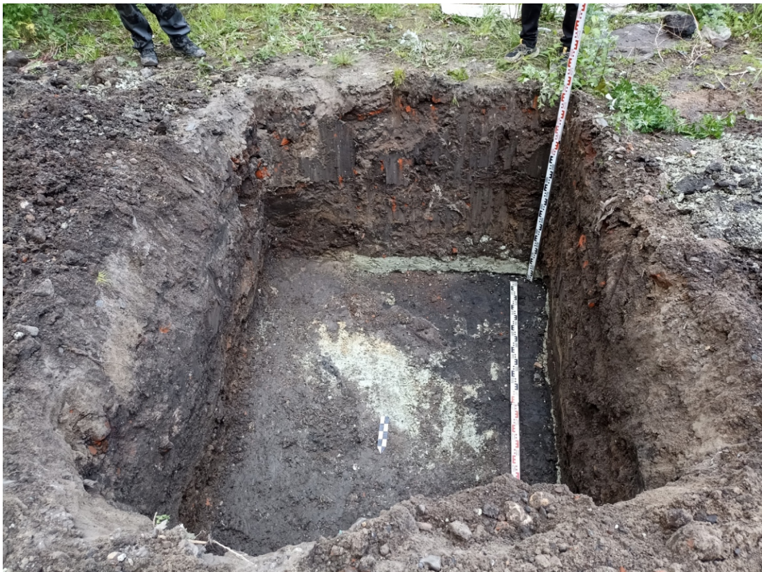
Рис. 26. Работы в границах земельных участков с кадастровыми номерами: 46:29:102288:291, 46:29:102288:292, 46:29:102288:52, в рамках проекта: «Реконструкция здания, расположенного по адресу: г. Курск, ул. Верхняя Луговая, д. 6А». 2024 г. Шурф 1. Пласт 0. Южный борт. Вид с С.
