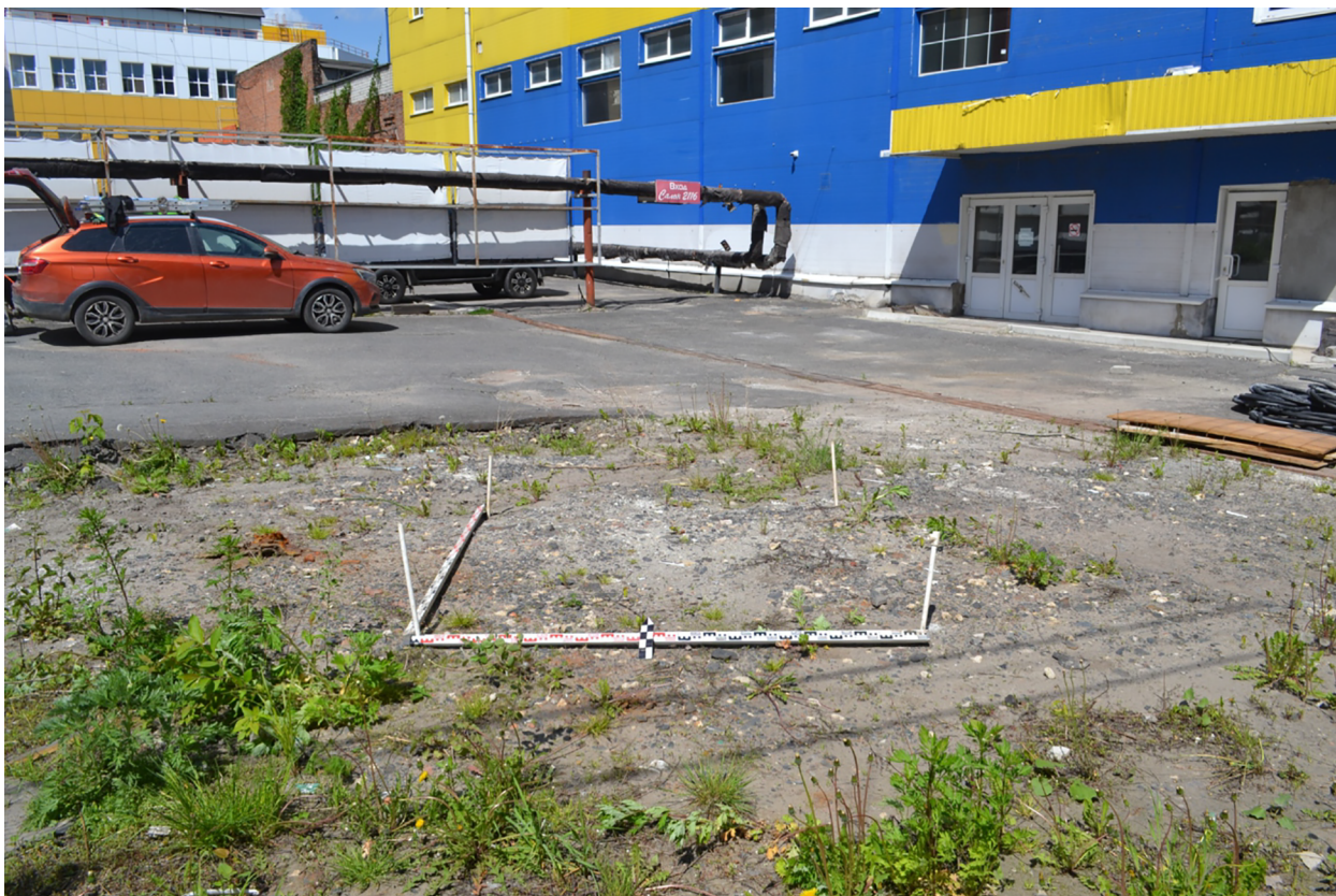
Рис. 17. Работы в границах земельных участков с кадастровыми номерами: 46:29:102288:291, 46:29:102288:292, 46:29:102288:52, в рамках проекта: «Реконструкция здания, расположенного по адресу: г. Курск, ул. Верхняя Луговая, д. 6А». 2024 г. Шурф 1. Дневная поверхность. Общий вид с Ю до начала работ.
