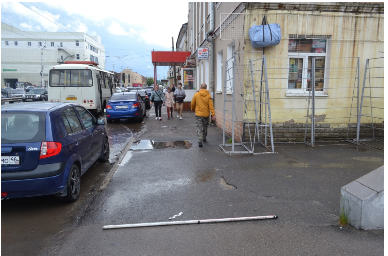
Рис. 13. Работы в границах земельных участков с кадастровыми номерами: 46:29:102288:291, 46:29:102288:292, 46:29:102288:52, в рамках проекта: «Реконструкция здания, расположенного по адресу: г. Курск, ул. Верхняя Луговая, д. 6А». 2024 г. Точка фотофиксации 3. Вид с СЗ.
