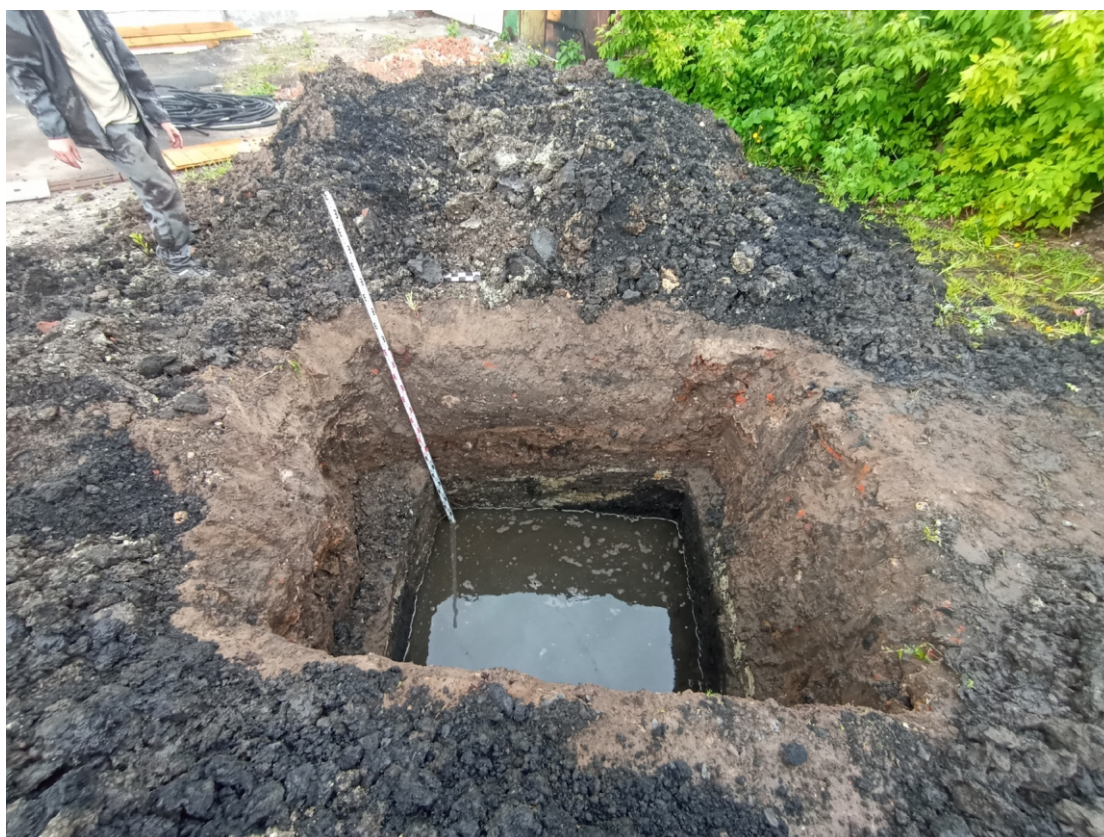
Рис. 38. Работы в границах земельных участков с кадастровыми номерами: 46:29:102288:291, 46:29:102288:292, 46:29:102288:52, в рамках проекта: «Реконструкция здания, расположенного по адресу: г. Курск, ул. Верхняя Луговая, д. 6А». 2024 г. Шурф 1. Пласт 3. Восточный борт (уровень выхода грунтовых вод). Вид с З.
