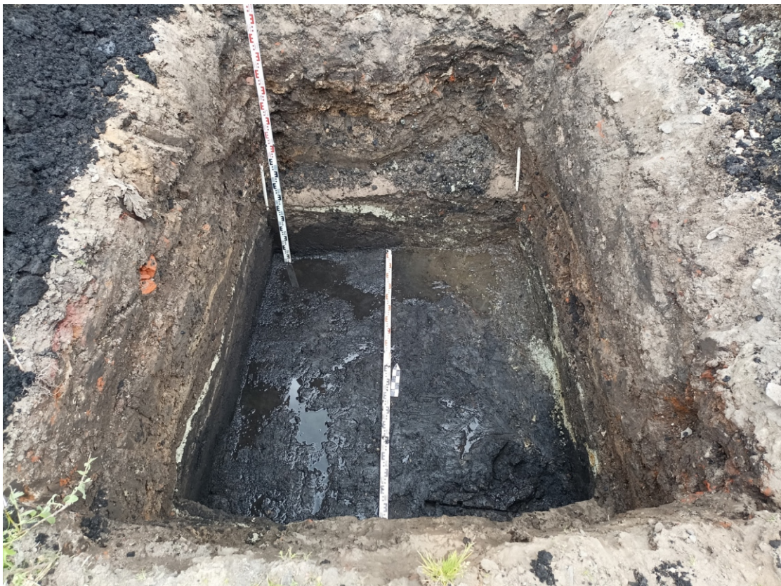
Рис. 32. Работы в границах земельных участков с кадастровыми номерами: 46:29:102288:291, 46:29:102288:292, 46:29:102288:52, в рамках проекта: «Реконструкция здания, расположенного по адресу: г. Курск, ул. Верхняя Луговая, д. 6А». 2024 г. Шурф 1. Пласт 2. Северный борт. Вид с Ю.
