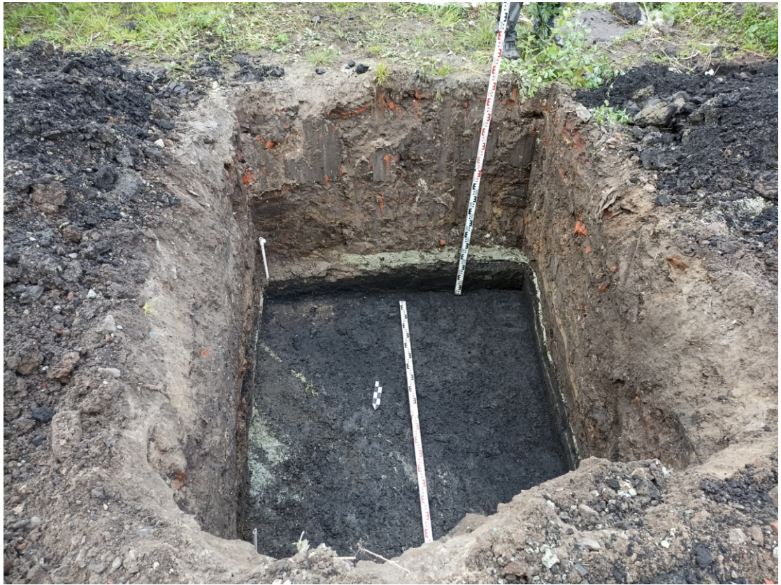
Рис. 27. Работы в границах земельных участков с кадастровыми номерами: 46:29:102288:291, 46:29:102288:292, 46:29:102288:52, в рамках проекта: «Реконструкция здания, расположенного по адресу: г. Курск, ул. Верхняя Луговая, д. 6А». 2024 г. Шурф 1. Пласт 1. Южный борт. Вид с С.
