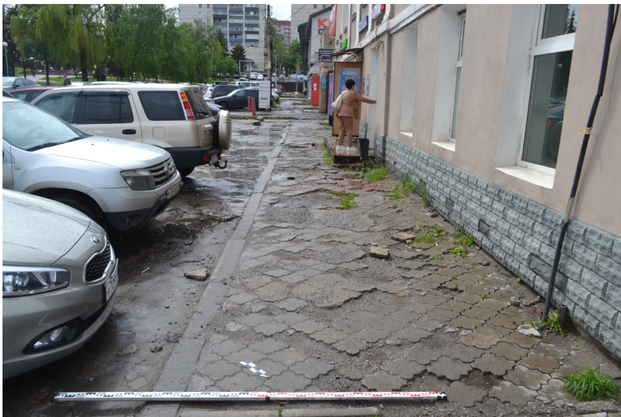
Рис. 11. Работы в границах земельных участков с кадастровыми номерами: 46:29:102288:291, 46:29:102288:292, 46:29:102288:52, в рамках проекта: «Реконструкция здания, расположенного по адресу: г. Курск, ул. Верхняя Луговая, д. 6А». 2024 г. Точка фотофиксации 2. Вид с СВ.
