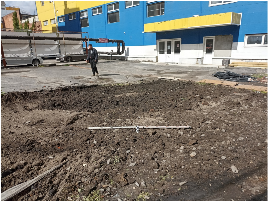
Рис. 39. Работы в границах земельных участков с кадастровыми номерами: 46:29:102288:291, 46:29:102288:292, 46:29:102288:52, в рамках проекта: «Реконструкция здания, расположенного по адресу: г. Курск, ул. Верхняя Луговая, д. 6А». 2024 г. Шурф 1. Рекультивация. Вид с Ю.
