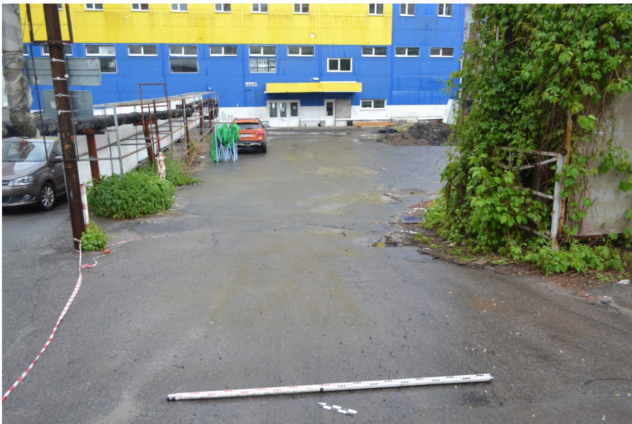
Рис. 10. Работы в границах земельных участков с кадастровыми номерами: 46:29:102288:291, 46:29:102288:292, 46:29:102288:52, в рамках проекта: «Реконструкция здания, расположенного по адресу: г. Курск, ул. Верхняя Луговая, д. 6А» 2024 г. Точка фотофиксации 1. Вид с ЮЗ.
