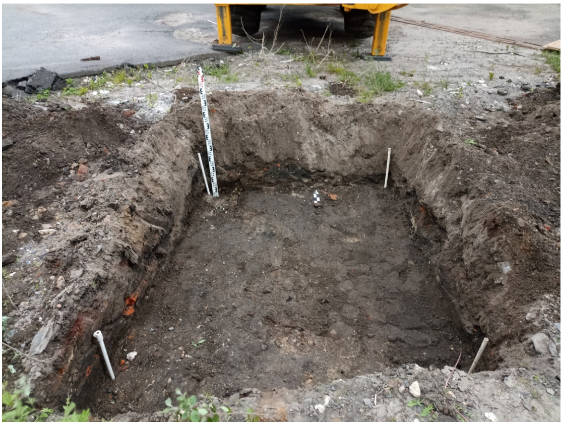
Рис. 20. Работы в границах земельных участков с кадастровыми номерами: 46:29:102288:291, 46:29:102288:292, 46:29:102288:52, в рамках проекта: «Реконструкция здания, расположенного по адресу: г. Курск, ул. Верхняя Луговая, д. 6А». 2024 г. Шурф 1. Балласт. Промежуточная зачистка на глубине 0,7 м. Северный борт. Вид с Ю.
