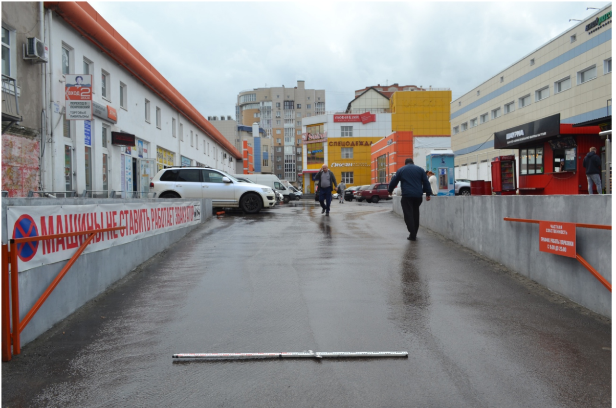
Рис. 14. Работы в границах земельных участков с кадастровыми номерами: 46:29:102288:291, 46:29:102288:292, 46:29:102288:52, в рамках проекта: «Реконструкция здания, расположенного по адресу: г. Курск, ул. Верхняя Луговая, д. 6А». 2024 г. Точка фотофиксации 3. Вид с СВ.
