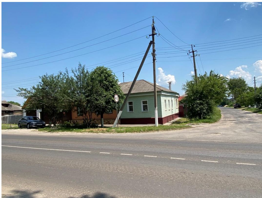
Фотография № 7. Вид с юго-запада на Объект.
