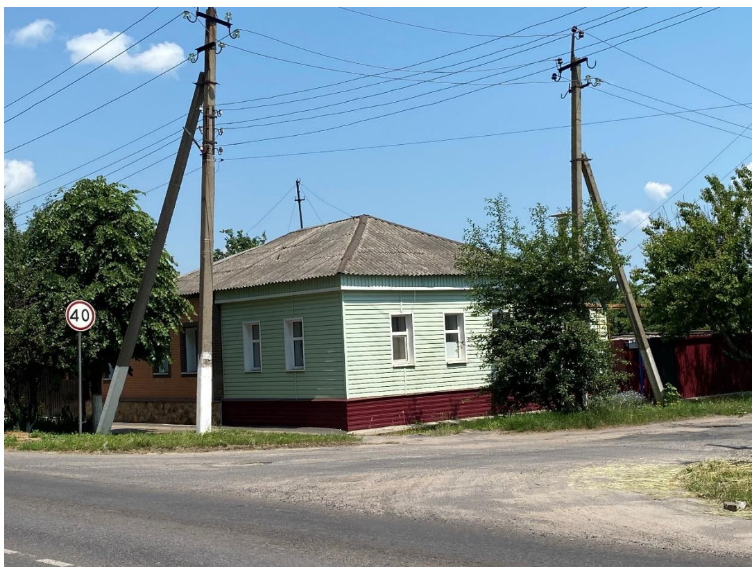
Фотография № 6. Вид с юго-запада на Объект.
