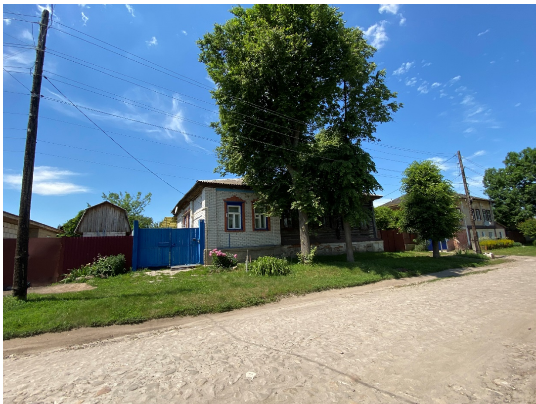
Фотография № 3. Вид с юго-востока на Объект.
