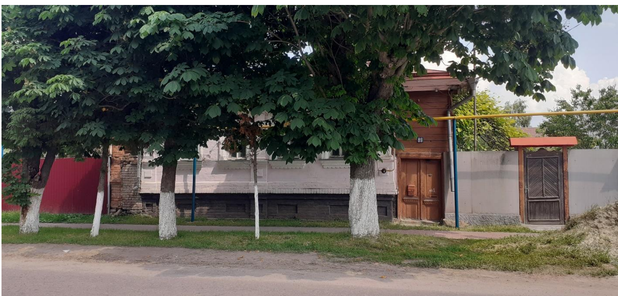
Фотография № 6. Вид с запада на Объект.
