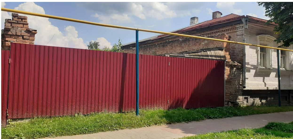
Фотография № 7. Вид с северо-запада на Объект.
