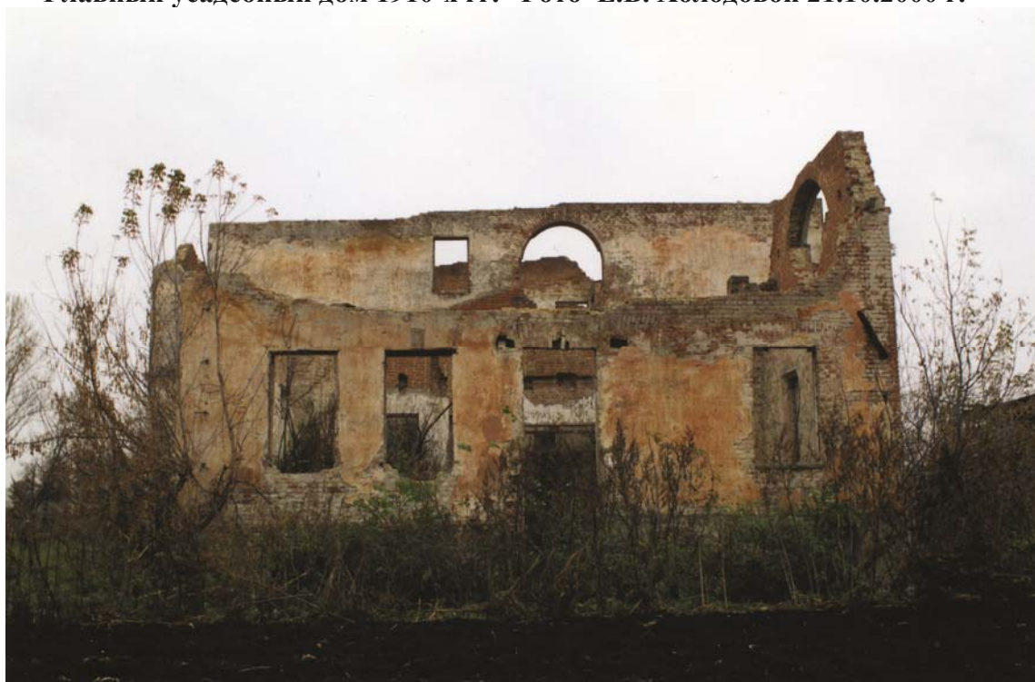
Главный усадебный дом 1910-х гг. Фото Е.В. Холодовой 21.10.2000 г.
