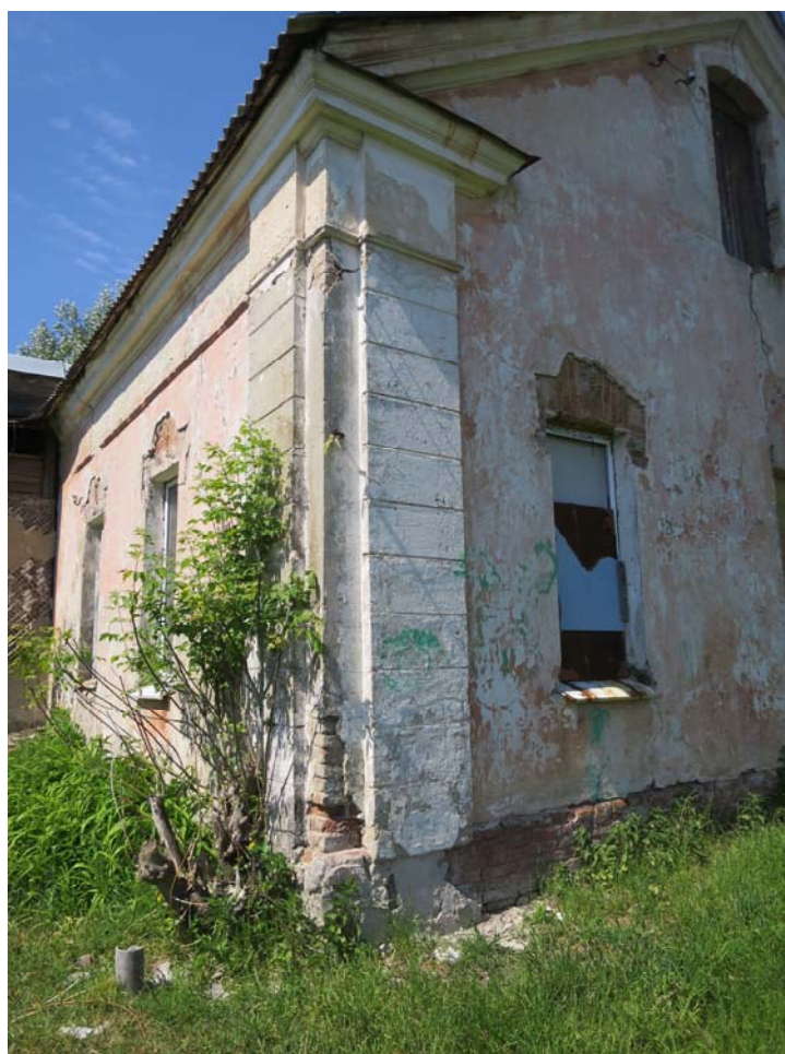
24. Детали фасадов. Характер отделки угла здания. Вид с востока.
