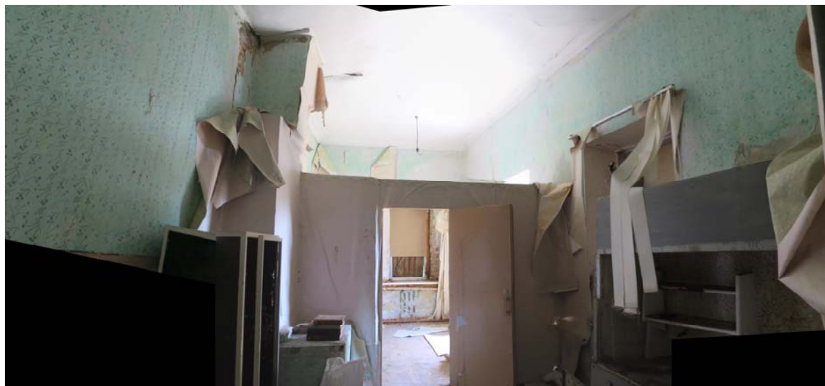
7. Помещение в юго-восточной части здания.
