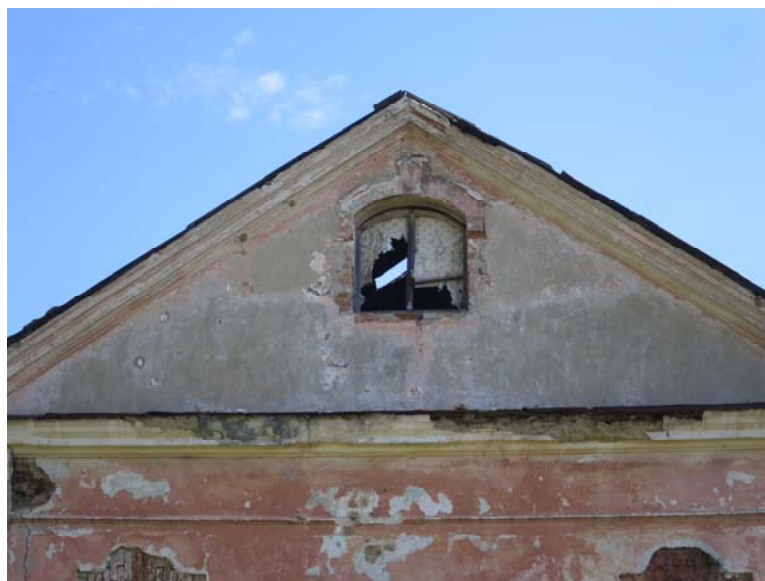
23. Детали юго-западного фасада. Характер фронтона.
